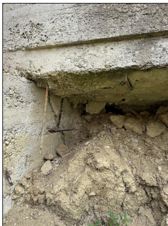
Immagini 9 - 10: dettaglio zona di lesione dello spallone a sostegno del piede di fondazione
