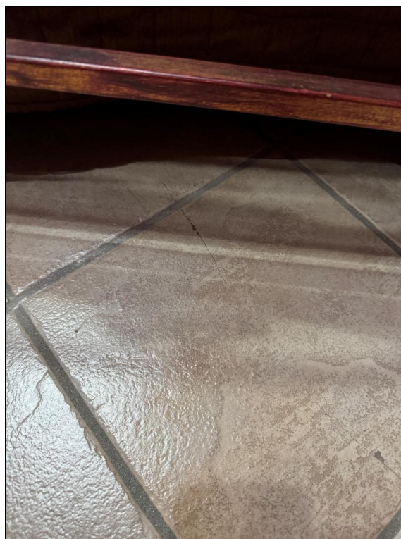
Immagini 4 – 5: vista fessurazioni su pavimentazione piano rialzato
