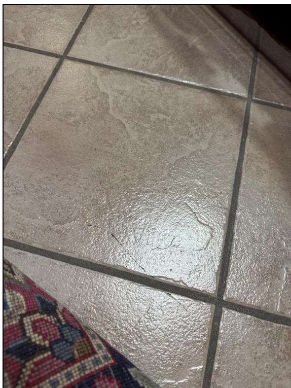
Immagini 4 – 5: vista fessurazioni su pavimentazione piano rialzato
