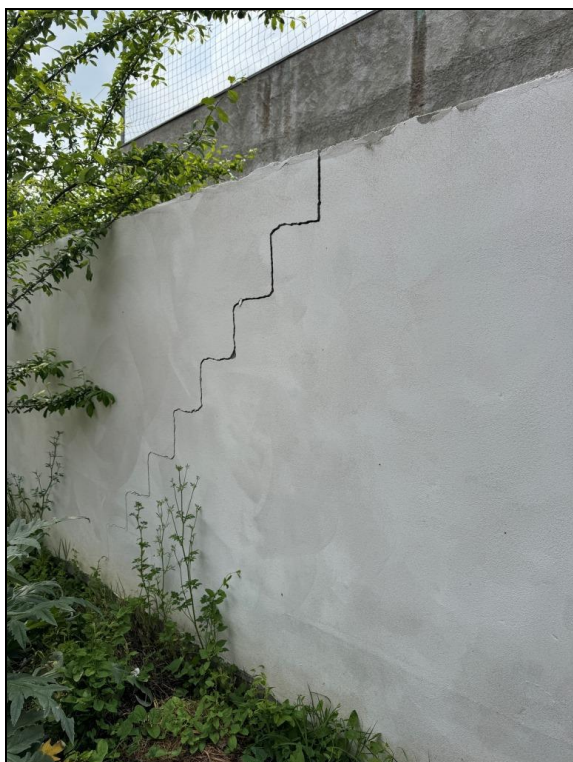
Immagini 11-12: dettaglio del muro realizzato dal Sig. Forciniti con lesioni
