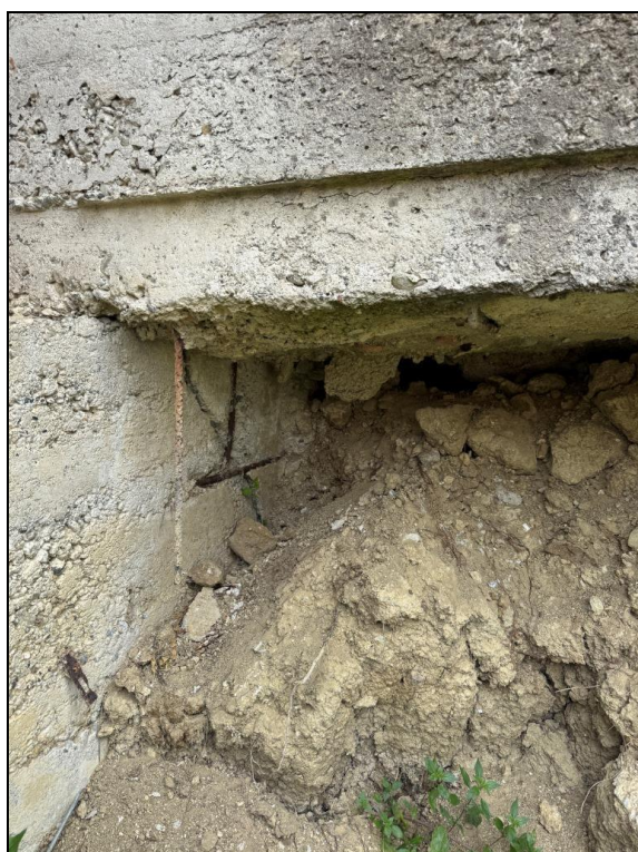
Immagini 9 - 10: dettaglio zona di lesione dello spallone a sostegno del piede di fondazione
