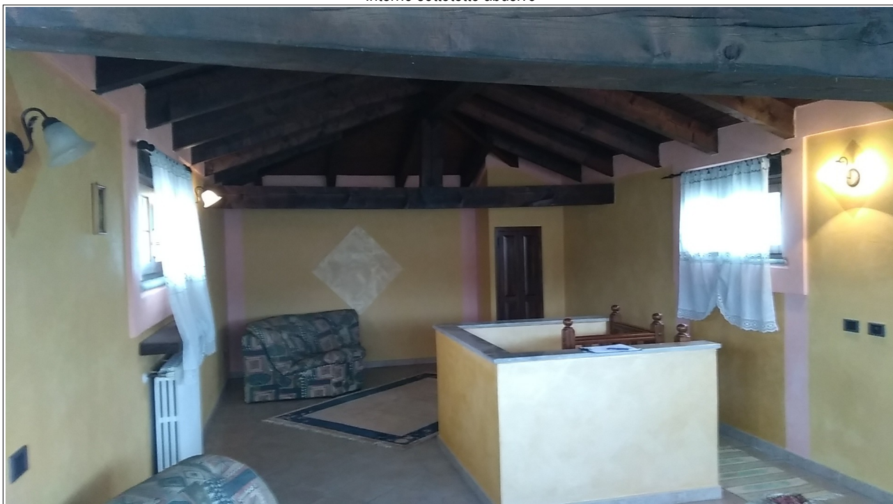
Interno sottotetto abusivo
