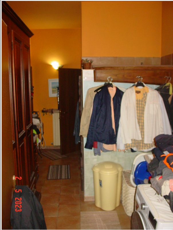
Lavanderia e centrale termica piano seminterrato
