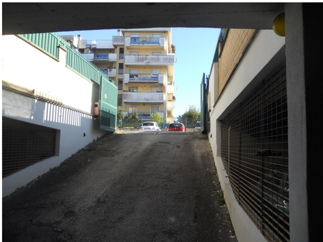
Foto n°20 - Rampa carrabile al piano seminterrato
