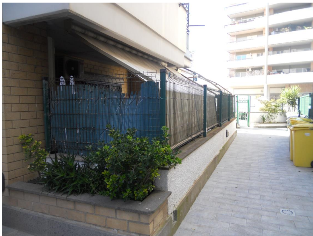
Foto n°6 - Vista da viale di camminamento della corte di pertinenza dell'immobile
