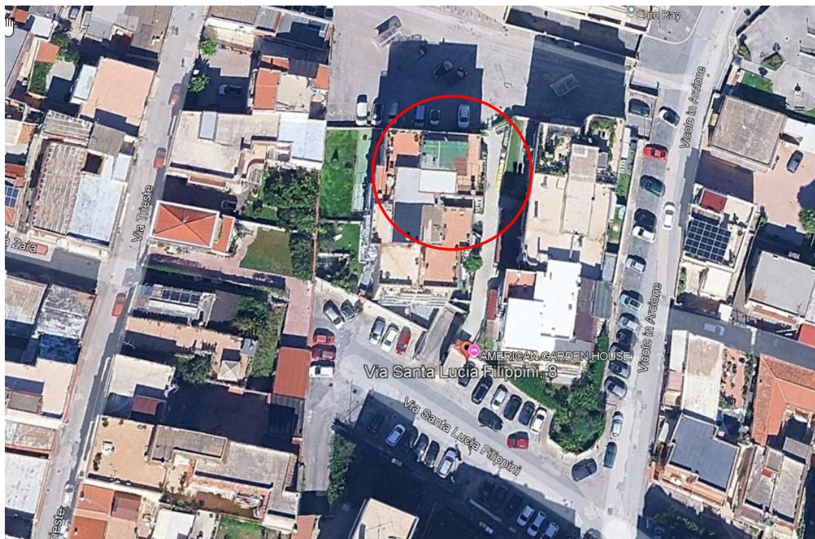
Foto n°1 - Vista dall'alto dell'immobile in comune di Nettuno,- via S. Lucia Filippini 8
