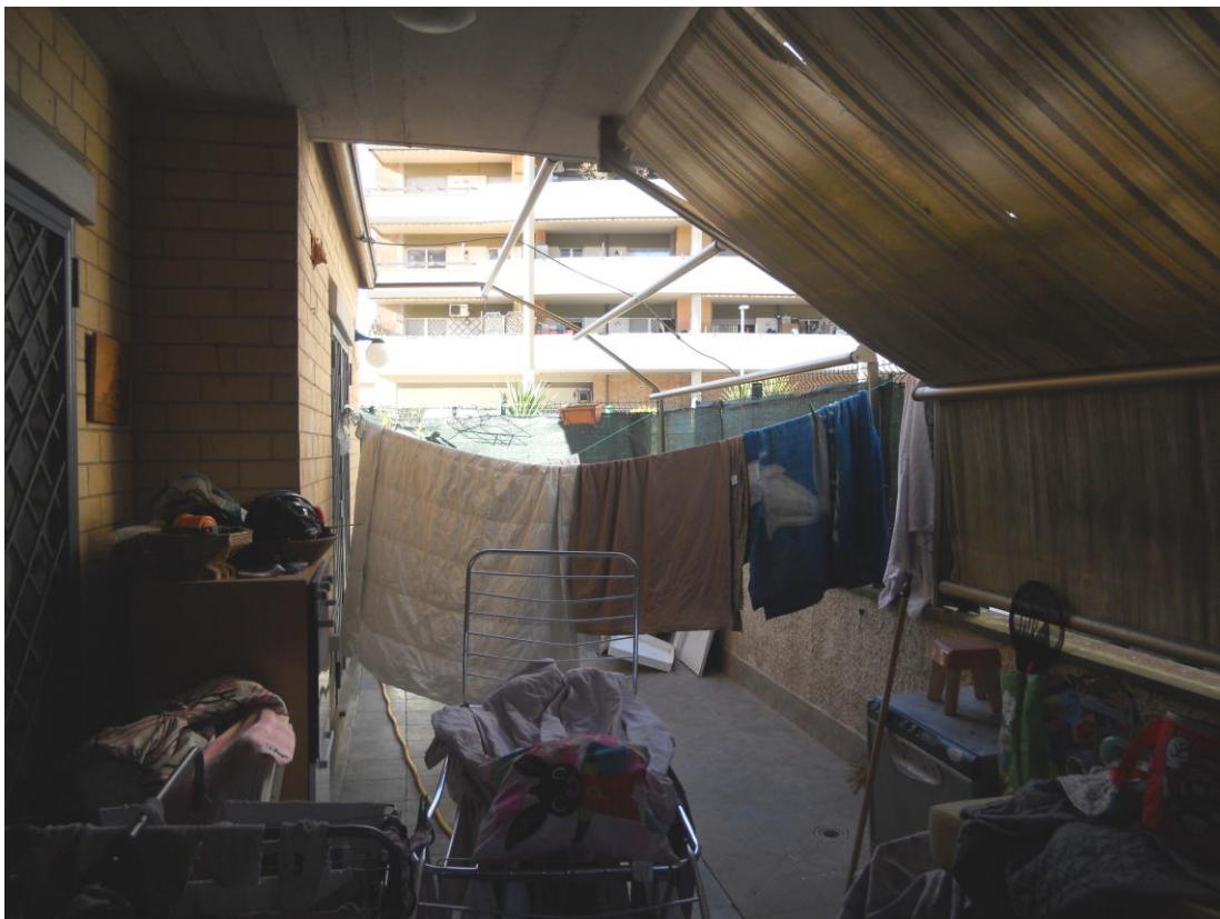
Foto n°17 - Corte di pertinenza al piano terra al confine con il camminamento condominiale
