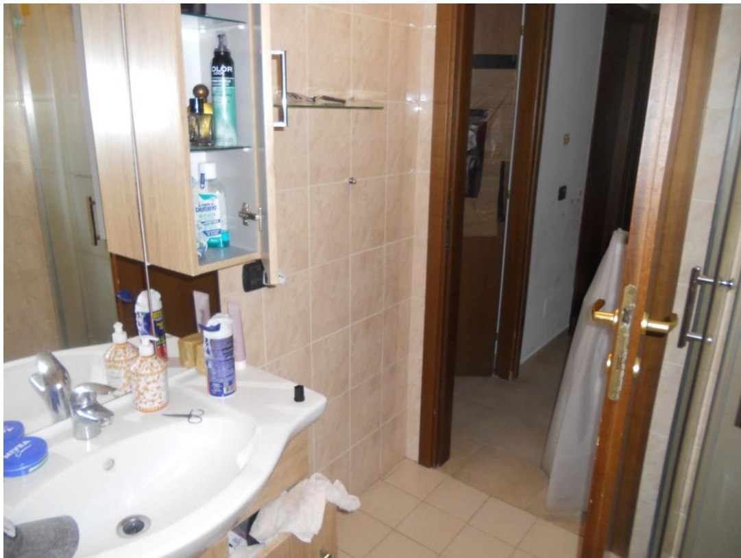
Foto n°15 - W.C. con aeratore lato ovest
