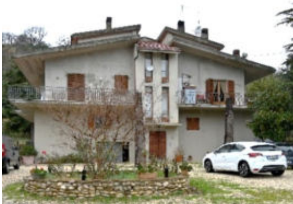
f. 6 – edificio part. 484 fronte principale
