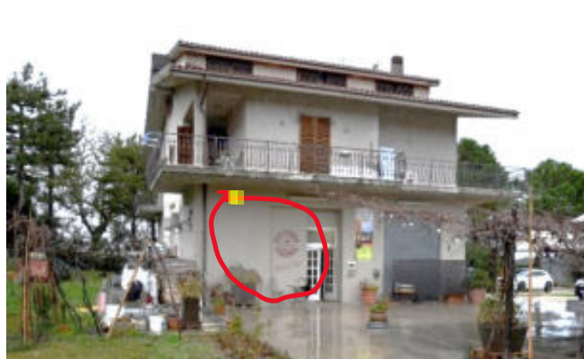
f. 7 – edificio part. 484 fronte principale
