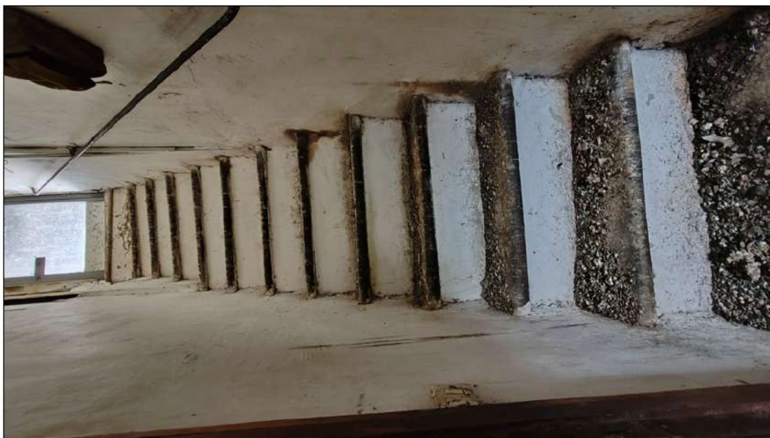
foto 31 - vista della scala che conduce al piano 3°.
