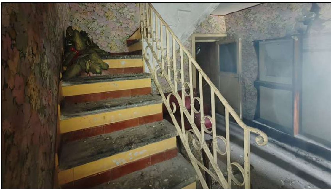
foto 21 - vista della scala di accesso al piano 2°.
