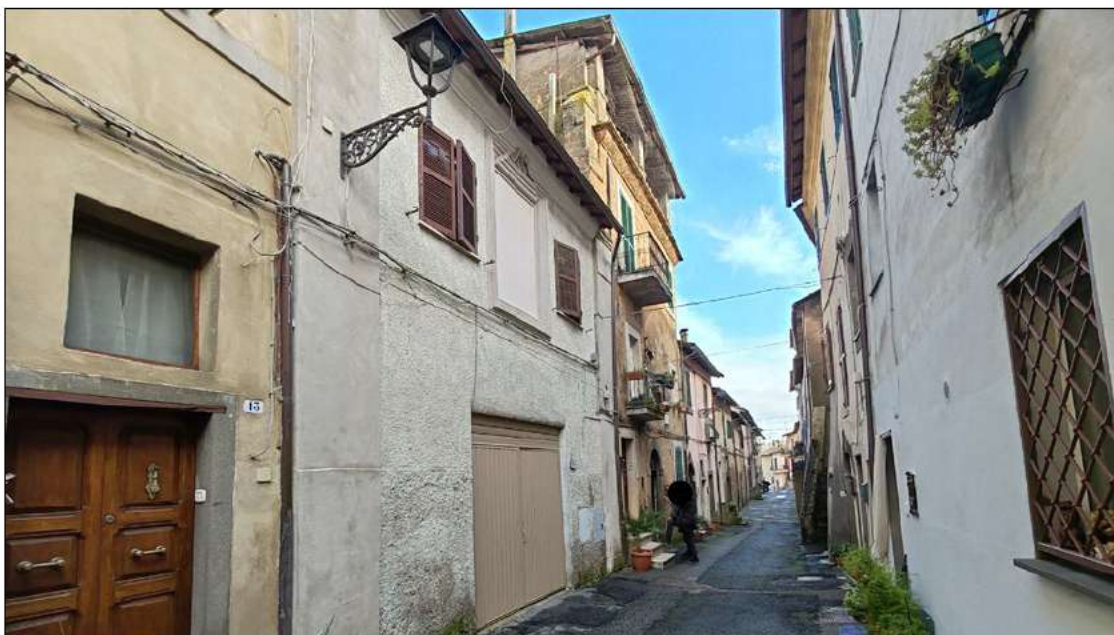
foto 1 - vista esterna dell'immobile da via Borgo San Filippo.
