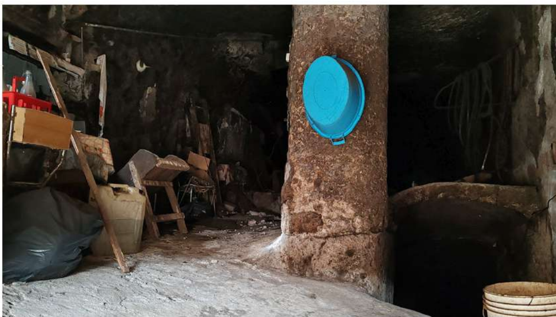
foto 36 - vista dall'ingresso del locale 1.
