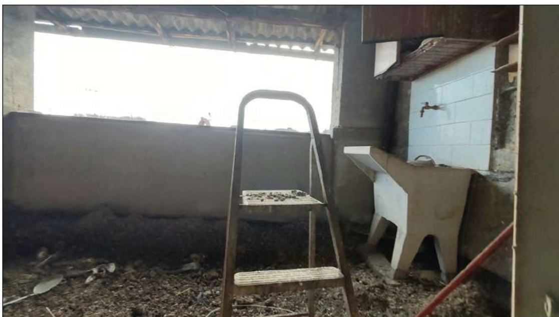
foto 32 - vista dall'accesso alla loggia al piano 3°.
