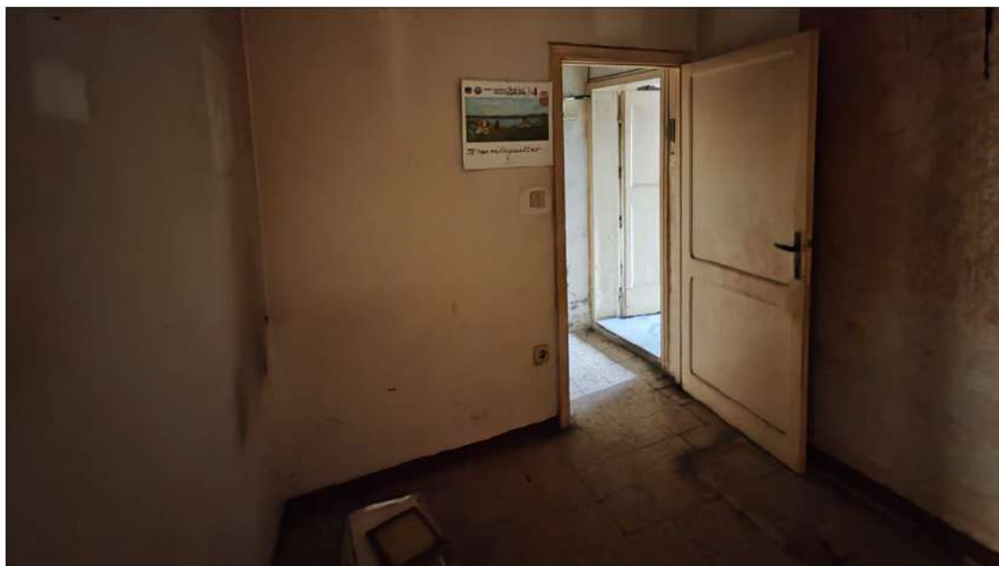
foto 13 - altro ambiente al piano terra.
