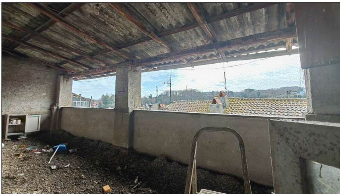
foto 33 - vista della loggia al piano 3°.
