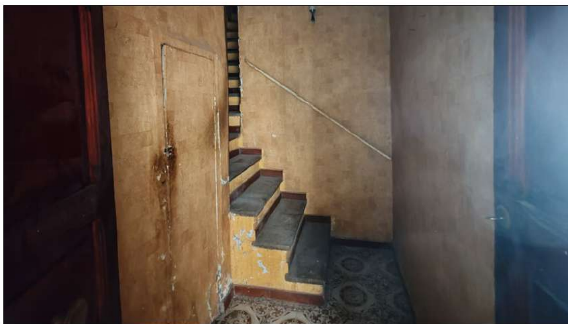
foto 14 - vista del disimpegno che porta alla scala di accesso al piano 1°.
