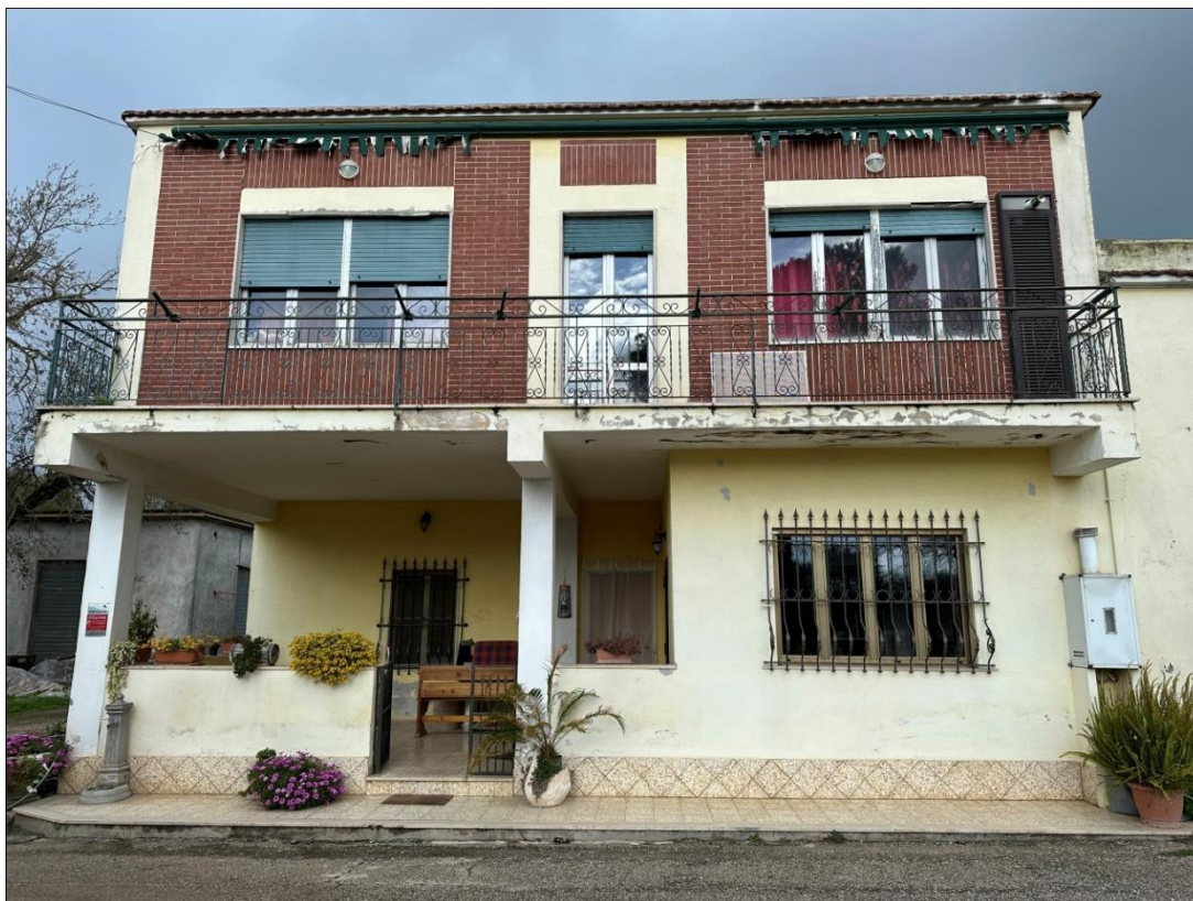
5) FOTO: FACCIATA PRINCIPALE DELL'IMMOBILE PIGNORATO (PIANO PRIMO)
