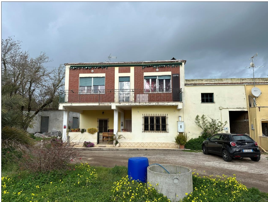
4) FOTO: FACCIATA PRINCIPALE DELL'IMMOBILE OGGETTO DI PIGNORAMENTO
