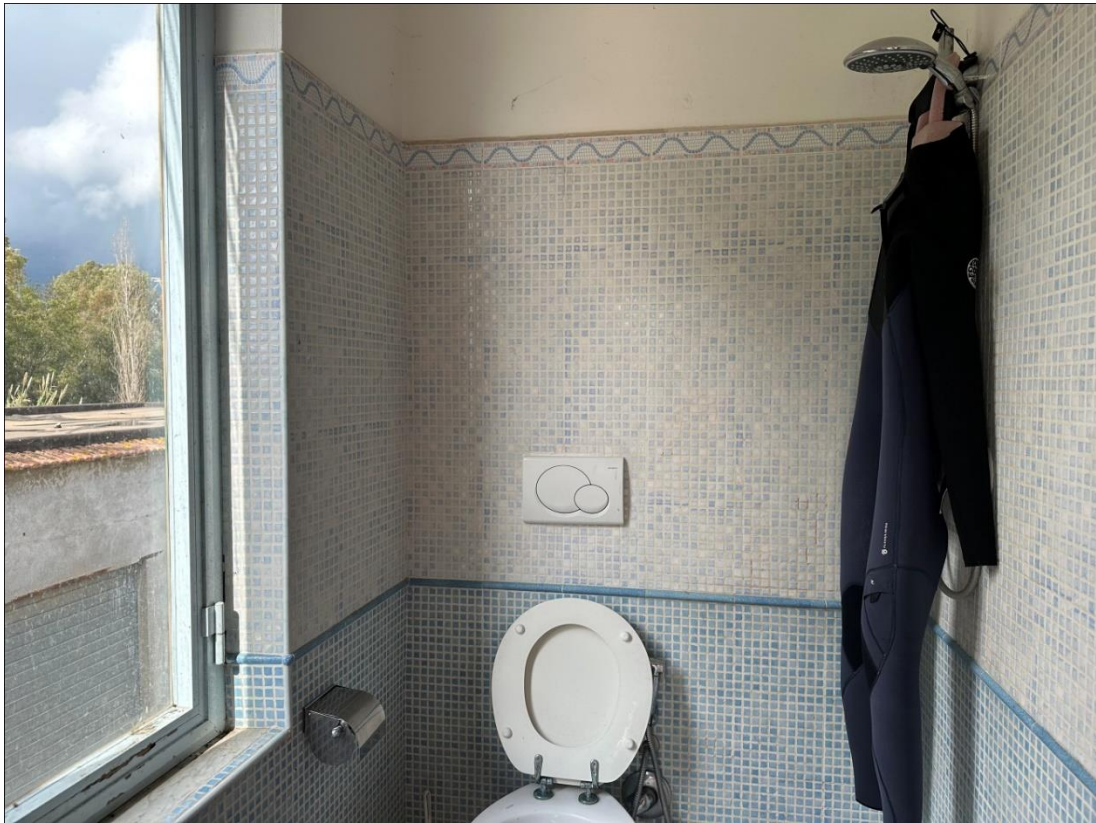
32) FOTO: BAGNO N°2 DELL'IMMOBILE PIGNORATO (POSTO SUL BALCONE N°2)
