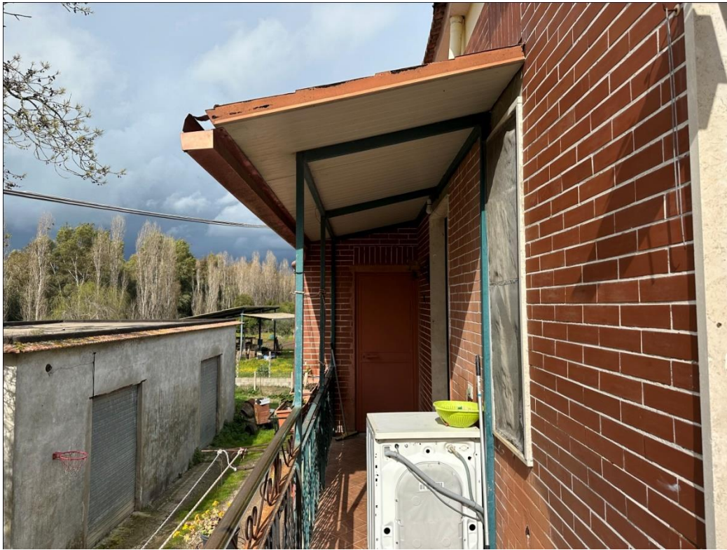
29) FOTO: BALCONE N°2 DELL'IMMOBILE PIGNORATO
