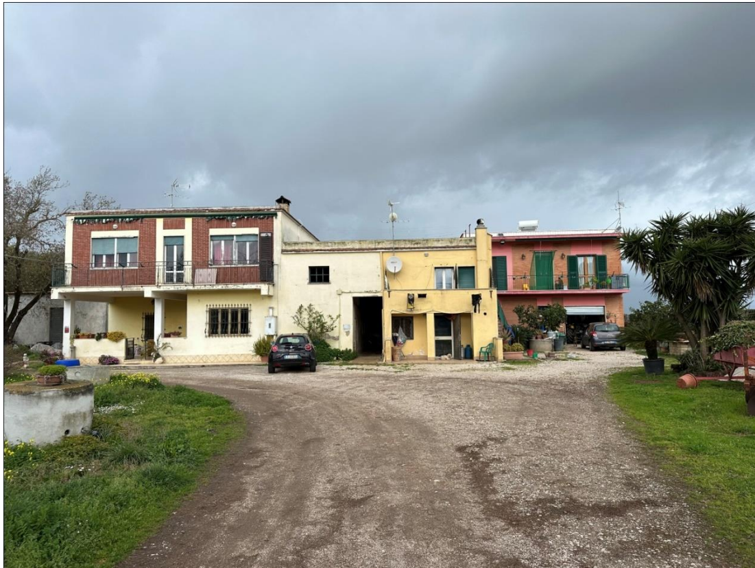
3) FOTO: FACCIATA PRINCIPALE DELL'IMMOBILE OGGETTO DI PIGNORAMENTO
