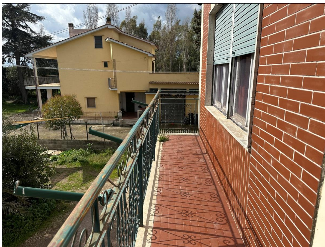
26) FOTO: BALCONE N°1 DELL'IMMOBILE PIGNORATO
