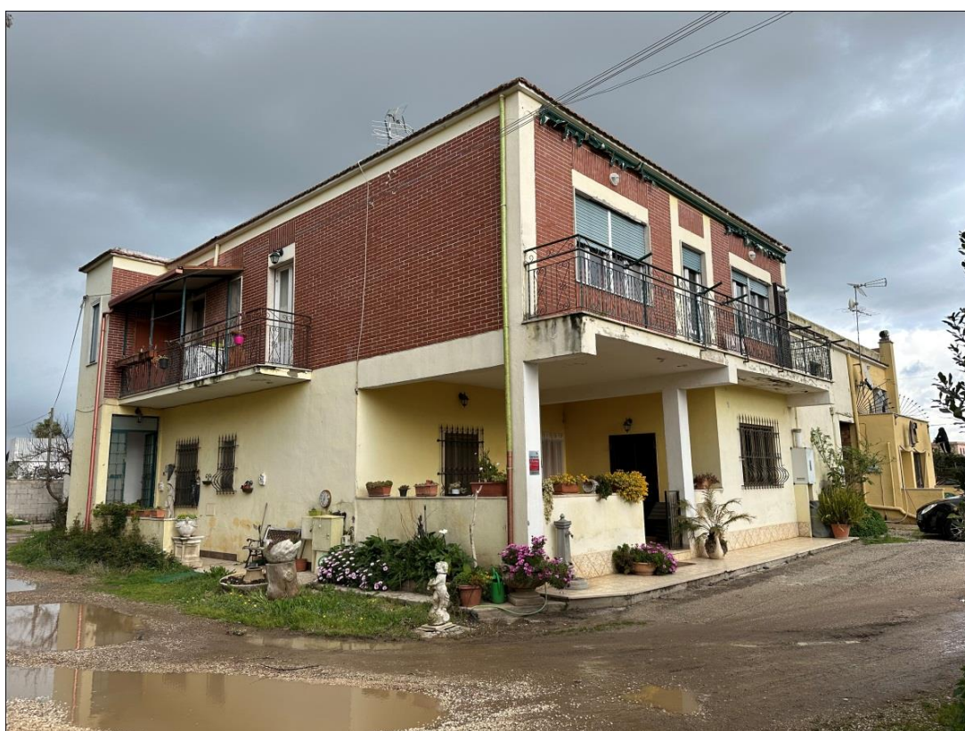
6) FOTO: FACCIATA PRINCIPALE/LATERALE DELL'IMMOBILE PIGNORATO (PIANO PRIMO)
