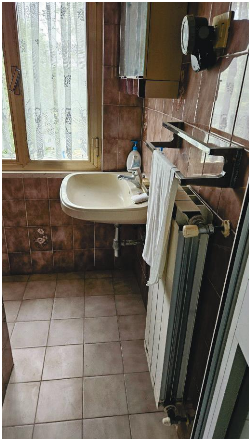
FOTO 10: PIANO TERRA – BAGNO 1
