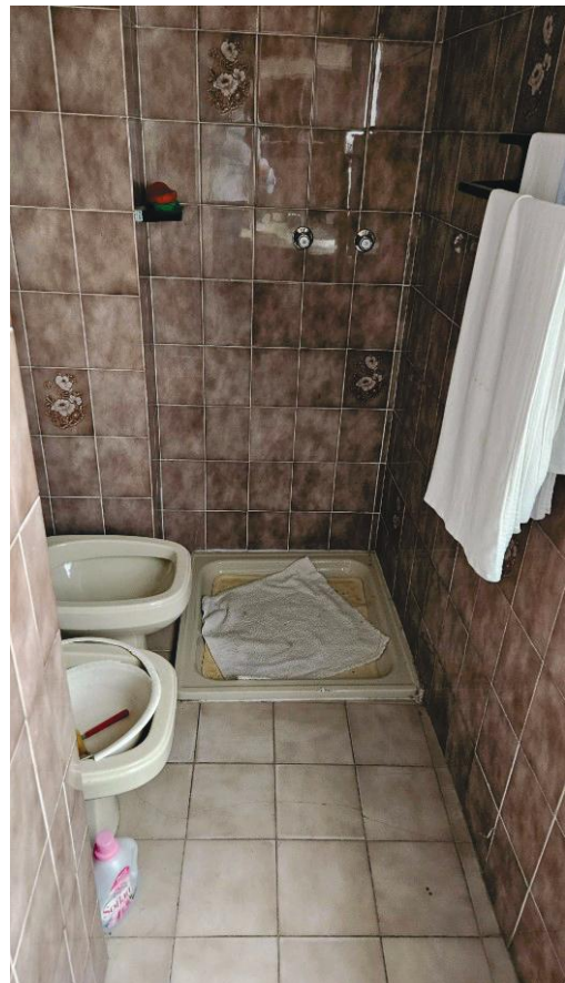
FOTO 11: PIANO TERRA – BAGNO 1
