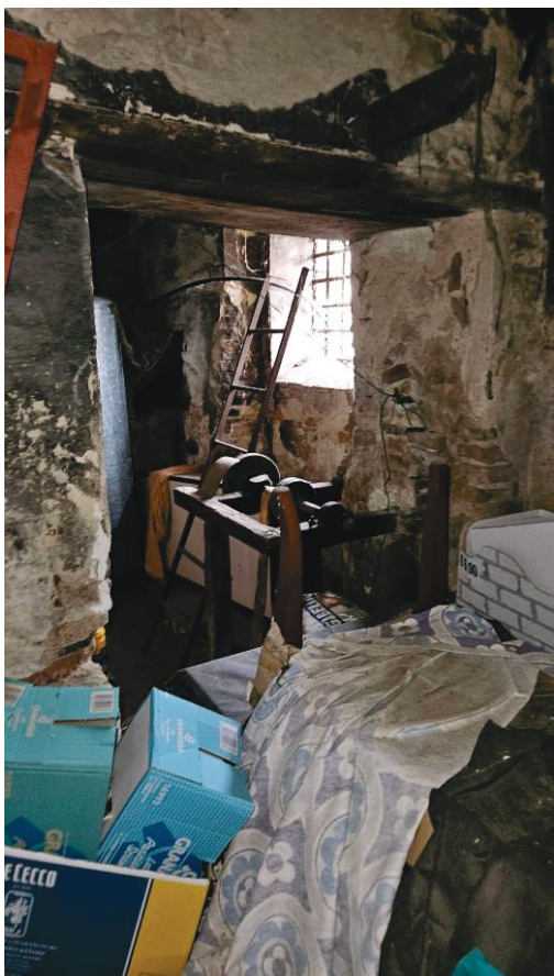
FOTO 26: PIANO SEMINTERRATO – DEPOSITO
