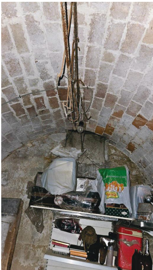
FOTO 24: PIANO SEMINTERRATO – DETTAGLIO VOLTE
