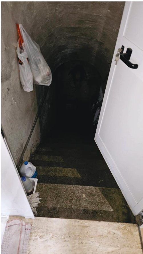
FOTO 22: GRADINATA DI ACCESSO AL SEMINTERRATO
