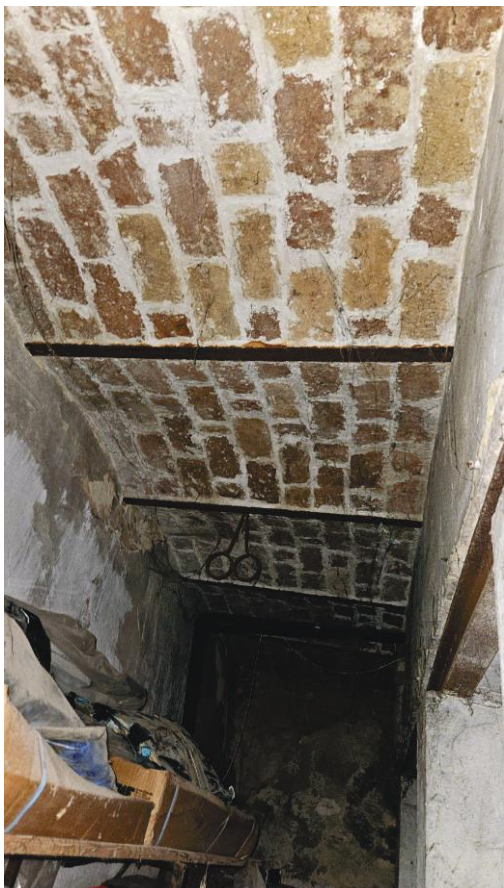
FOTO 28: PIANO SEMINTERRATO – SOLAIO A VOLTINE FOTO 29: GRADINATA DI ACCESSO AL PIANO TERRA
