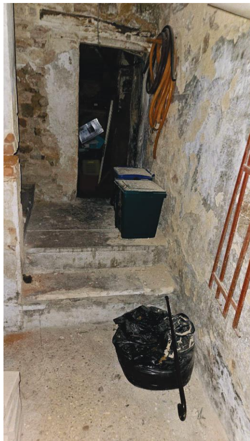
FOTO 25: PIANO SEMINTERRATO - DEPOSITO
