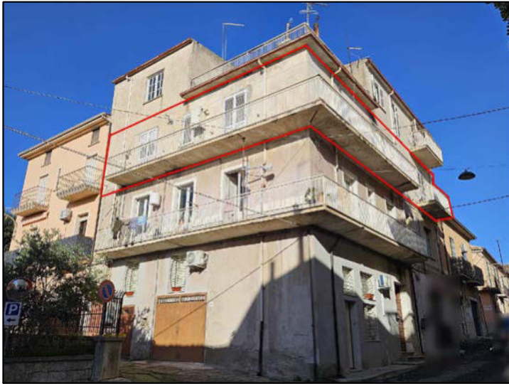
FOTO 1 - Esterni con indicazione appartamento
