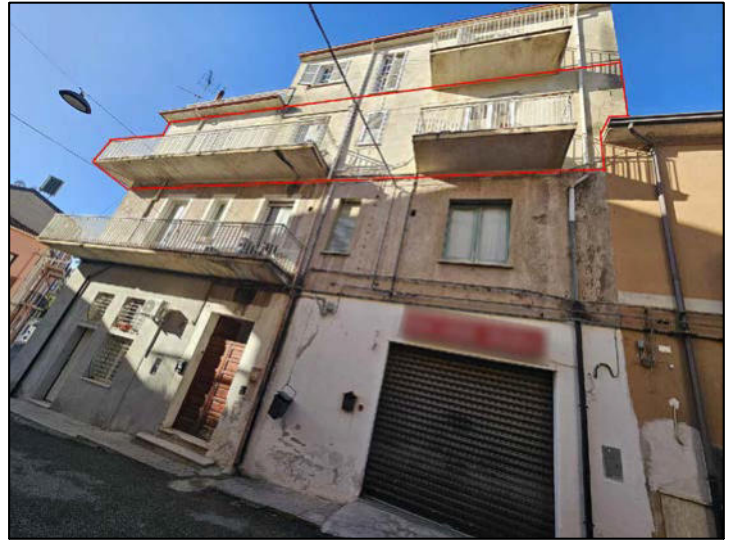
FOTO 2 - Esterni con indicazione appartamento
