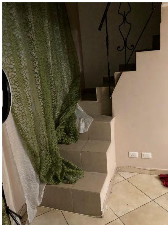
Foto n. 14: Scala di accesso al soppalco.
