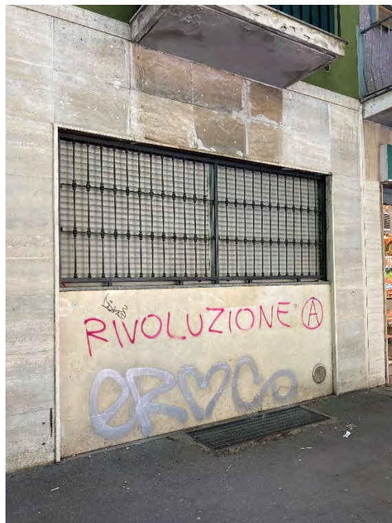
Foto n. 3: Particolare della facciata su Via Val di Bondo.
