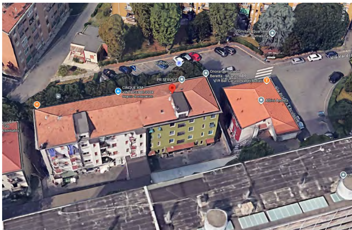
Foto n. 1: Vista del fabbricato.
