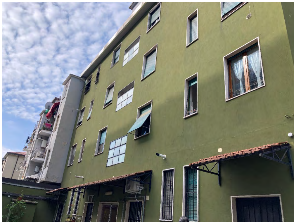
Foto n. 5: Facciata sul cortile interno.
