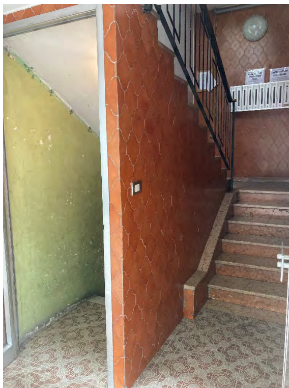
Foto n. 18: Androne comune e accesso alle cantine.
