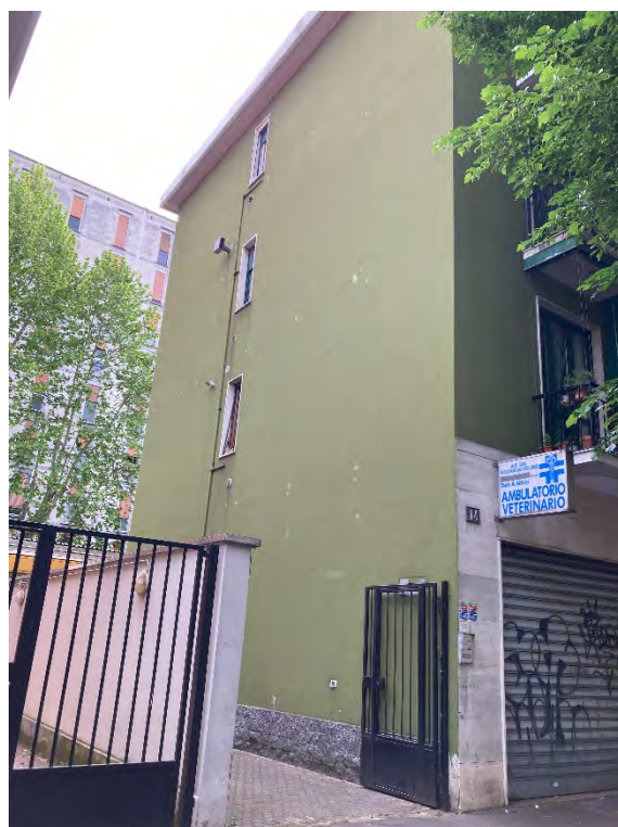
Foto n. 4: Facciata laterale e accesso al condominio.
