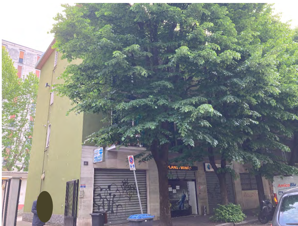
Foto n. 2: Facciata su Via Val di Bondo.
