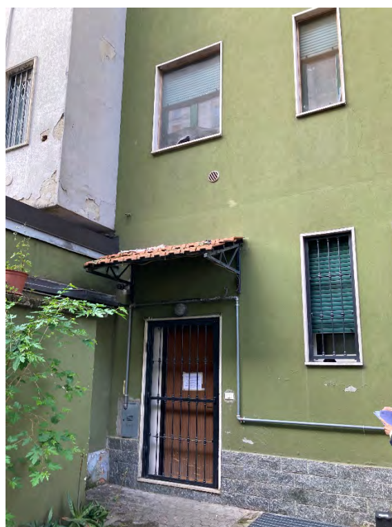
Foto n. 6: Particolare della facciata interna.
