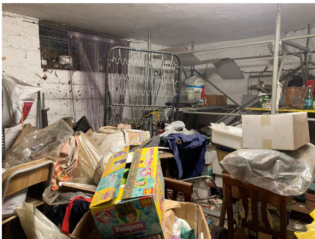
Foto n. 20: Cantina al Piano S1.
