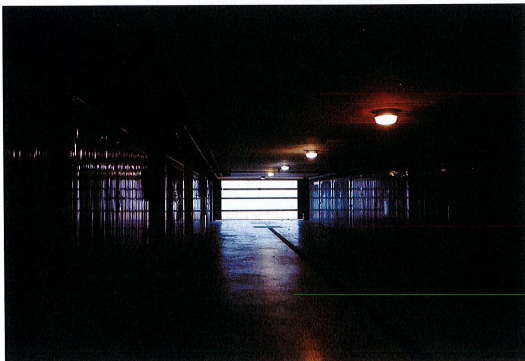
FOTO 6 - Piano interrato. La corsia di manovra.
