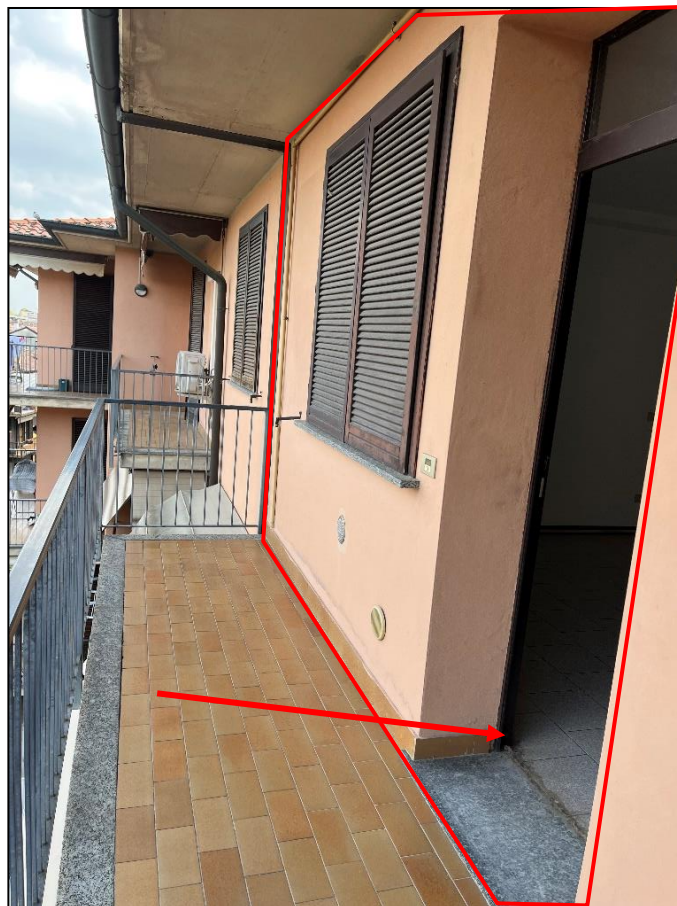
Foto n. 5 – ingresso all'appartamento da ballatoio comune
