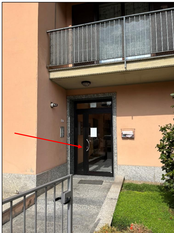
Foto n. 1 – ingresso al vano scala condominiale P.T.
