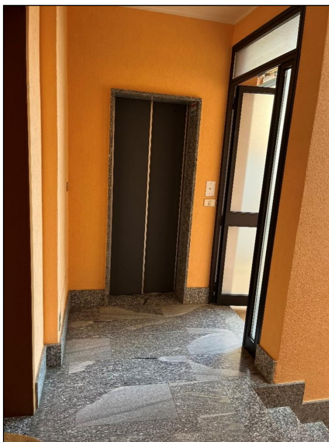
Foto n.2 – Vano scala P.3 con uscita su ballatoio comune
