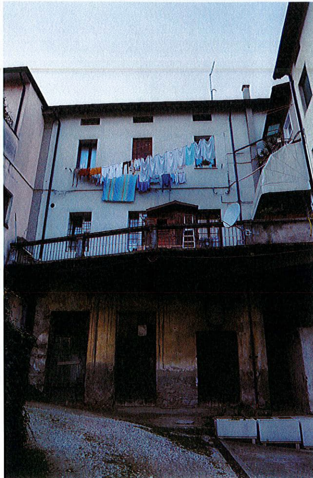
FOTO 9 - Il complesso in cui si trova l'unità ex cinema in esame. L'ingresso dal retro.
