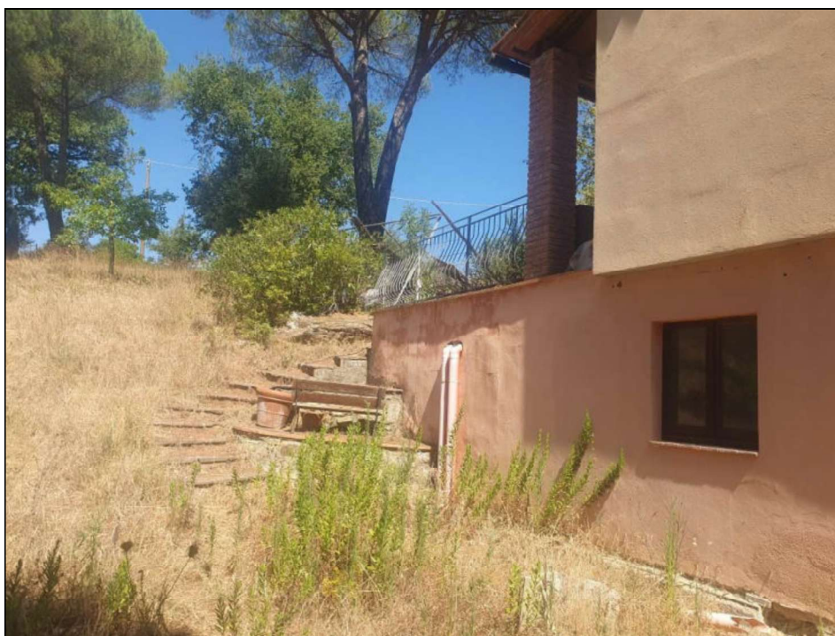
Foto B: Vista n.1 facciata sud-ovest
