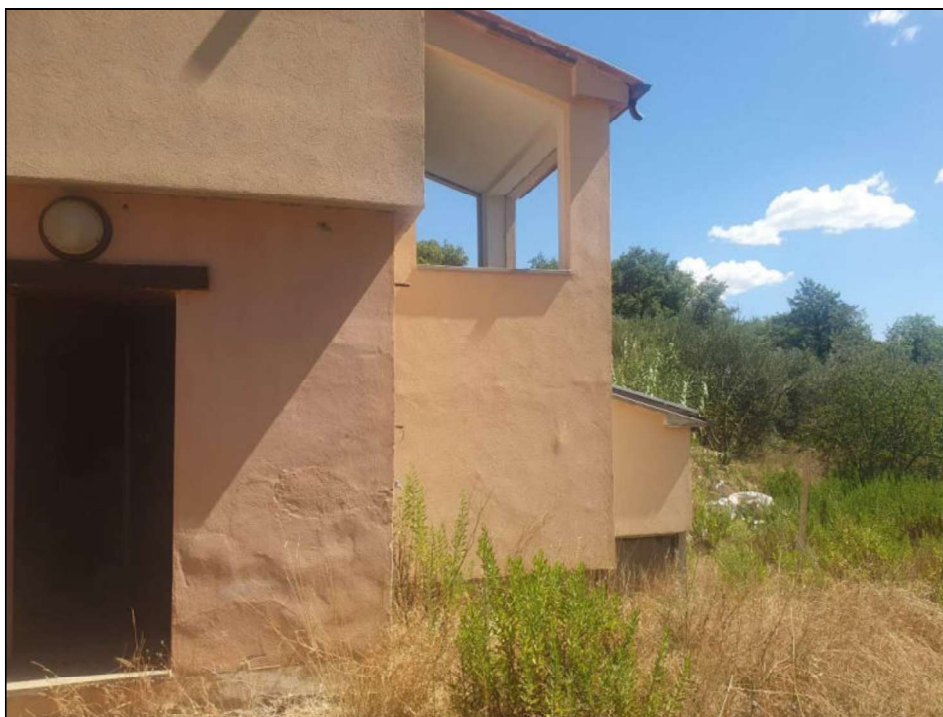
Foto D: Vista n.3 facciata sud-ovest
