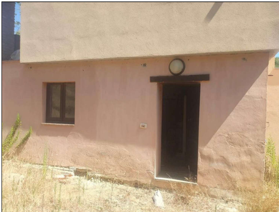
Foto C: Vista n.2 facciata sud-ovest
