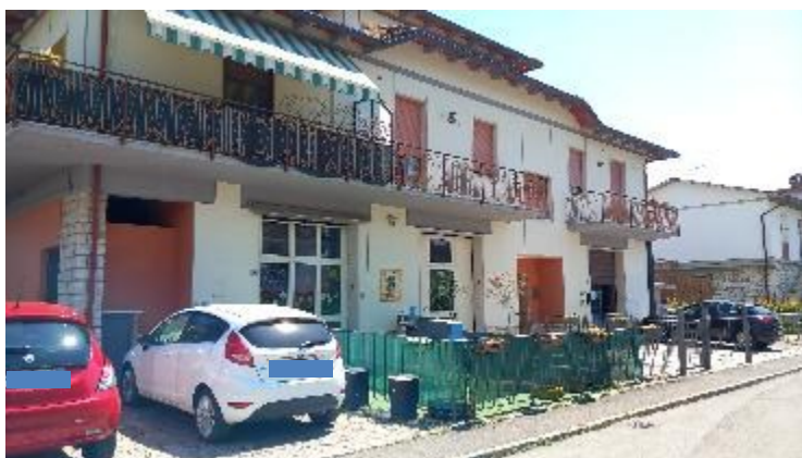
Vista fabbricato in contesto urbano
