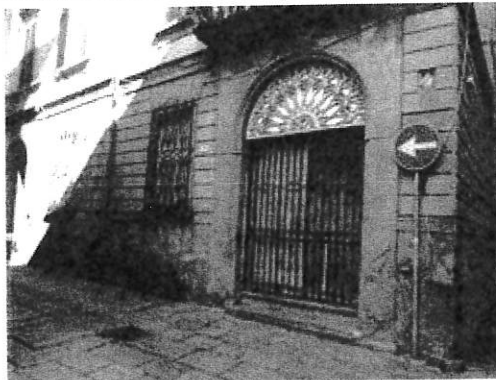
veduta dell'ingresso al piano terra al bene oggetto di stima
