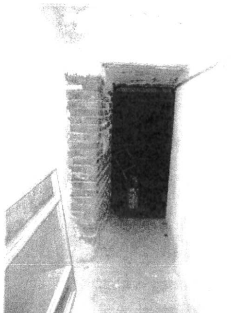
veduta della nuova apertura nella muratura portante del fabbricato ripresa dal corridoio vano 8.4: oltre l'apertura si trova la cantina - magazzino vano 8.5
