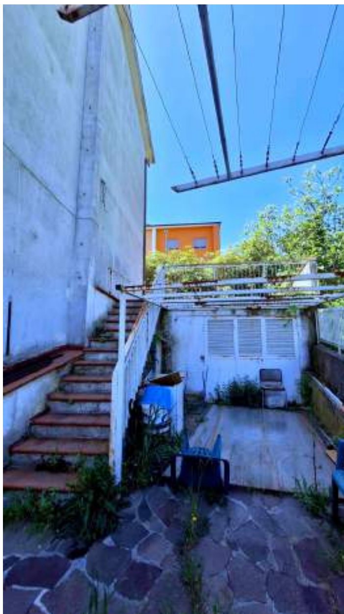
Foto n.5 – Particolare corpo aggiunto
