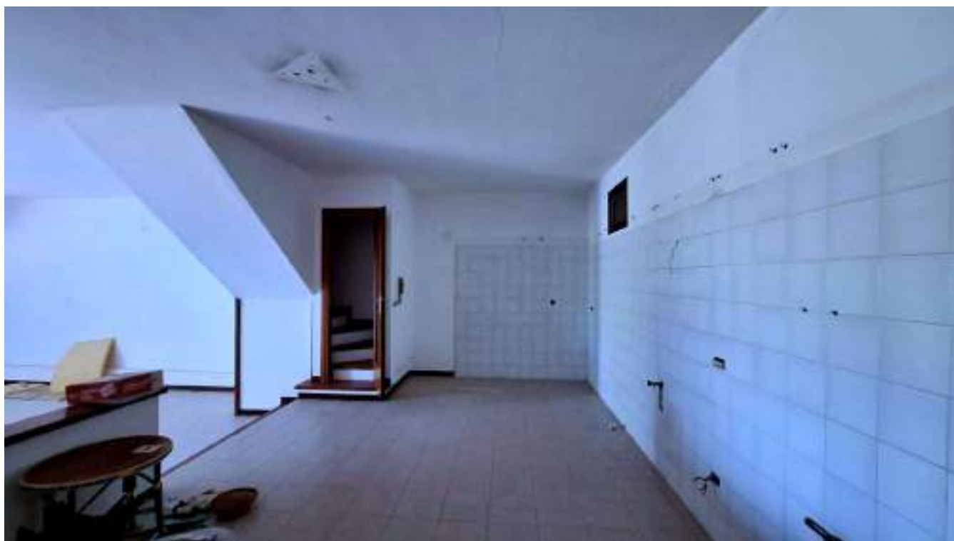
Foto n.8 – PIANO SEMINTERRATO – Particolare angolo cottura e vano scala
