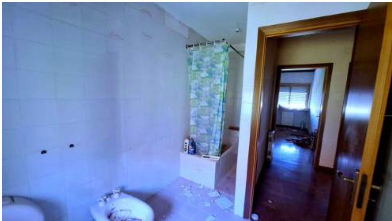
Foto n.19 – PIANO PRIMO– Particolare bagno
