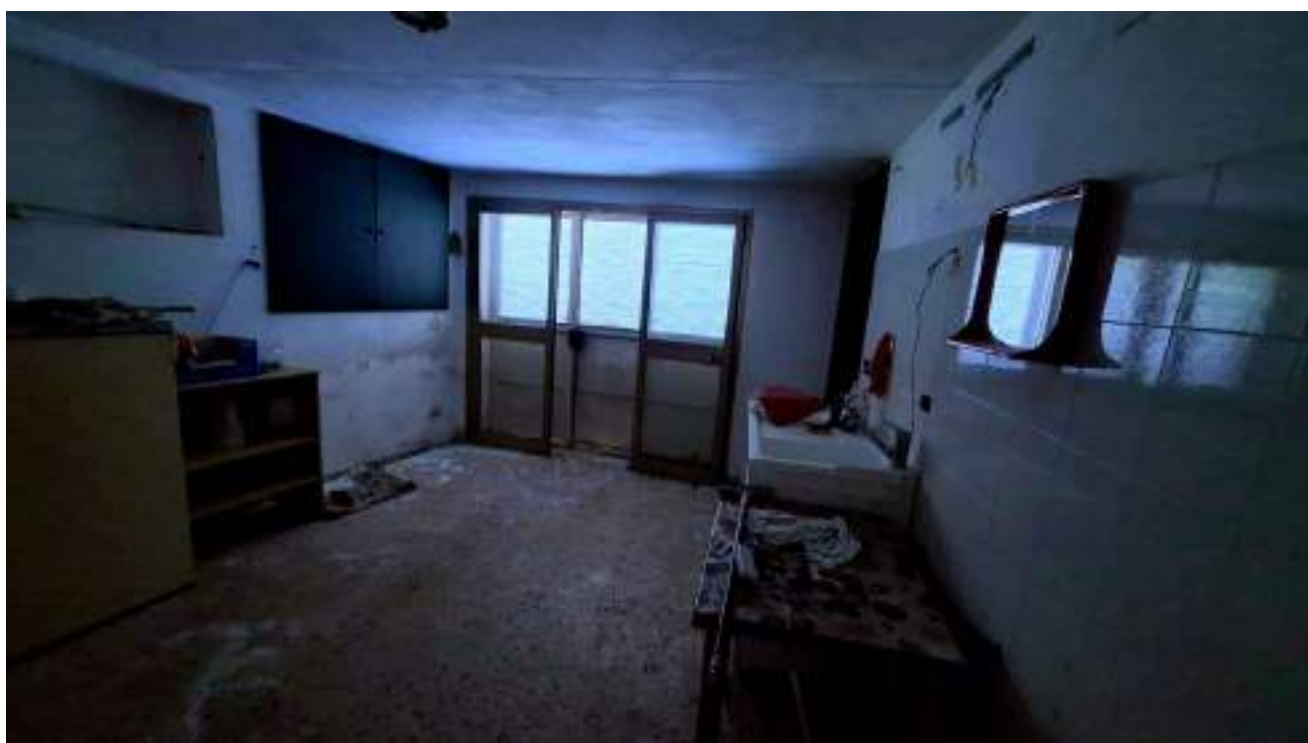
Foto n.10 – PIANO SEMINTERRATO – Interno corpo aggiunto
