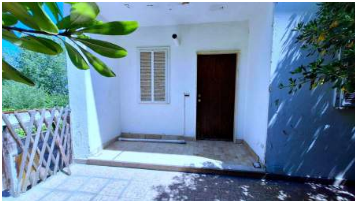
Foto n.3 – Particolare ingresso su via Milone
