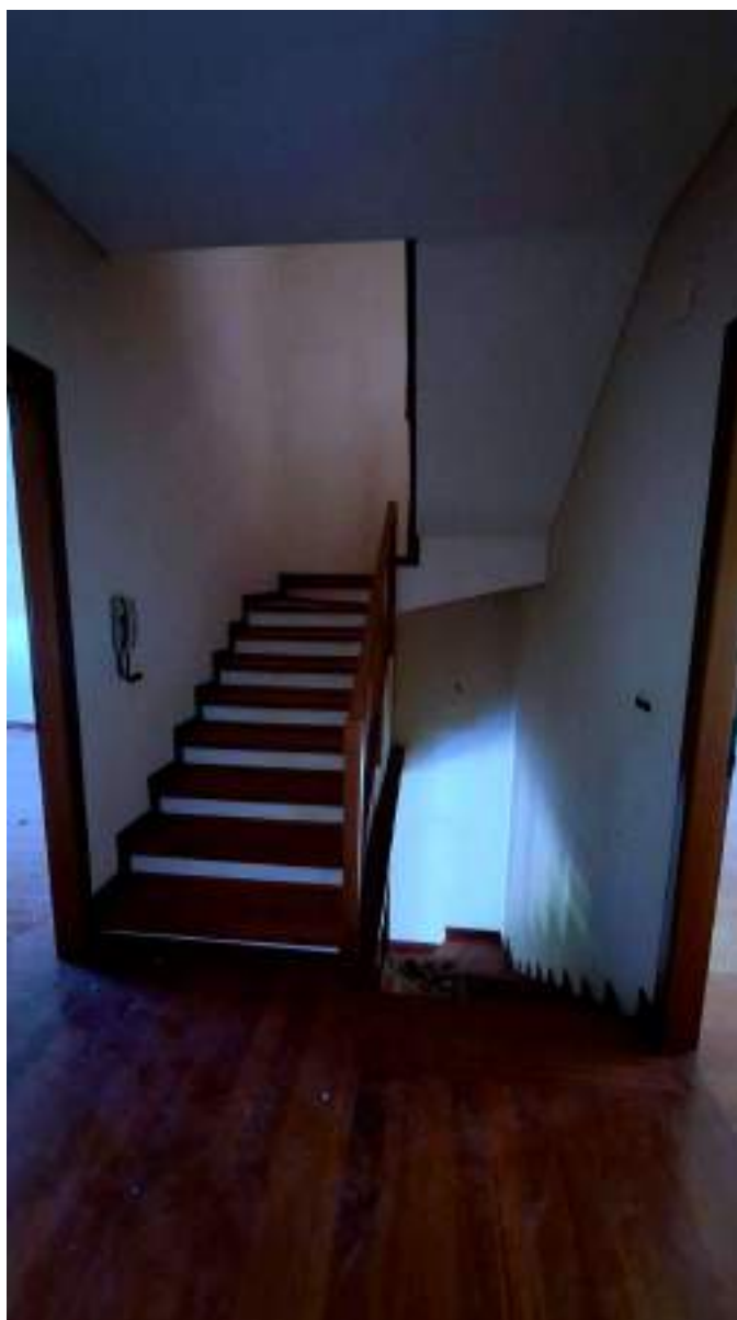
Foto n.18 – PIANO PRIMO– Particolare disimpegno e vano scala
