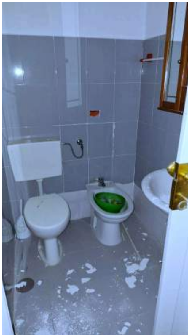
Foto n.11 – PIANO SEMINTERRATO – Particolare bagno corpo aggiunto
