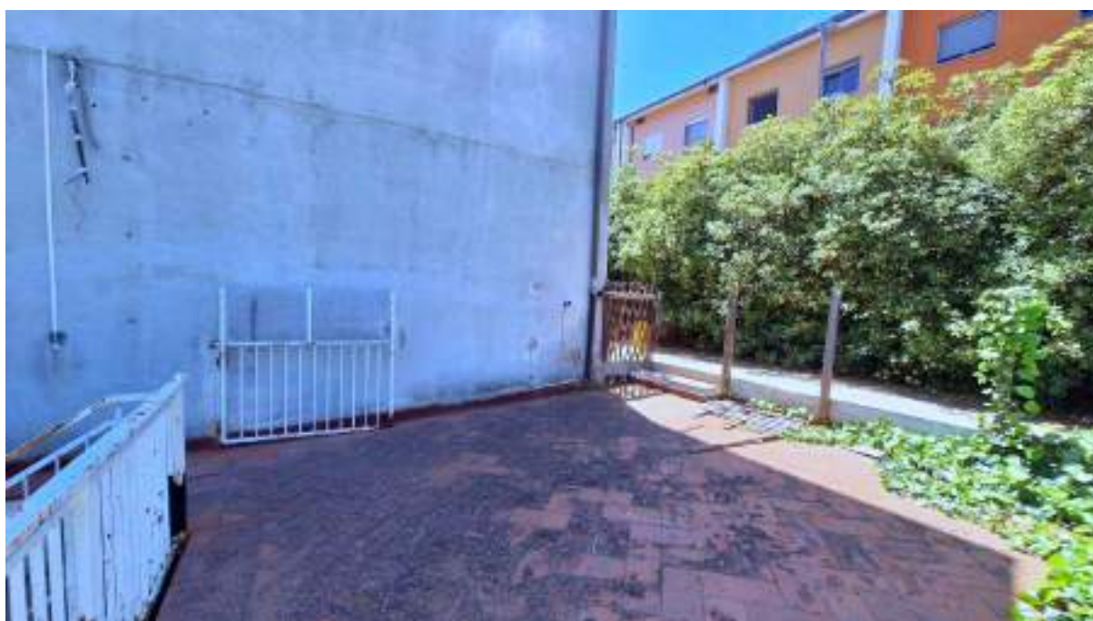
Foto n.6 – Particolare sbarco scala esterna e terrazzo sul corpo aggiunto
