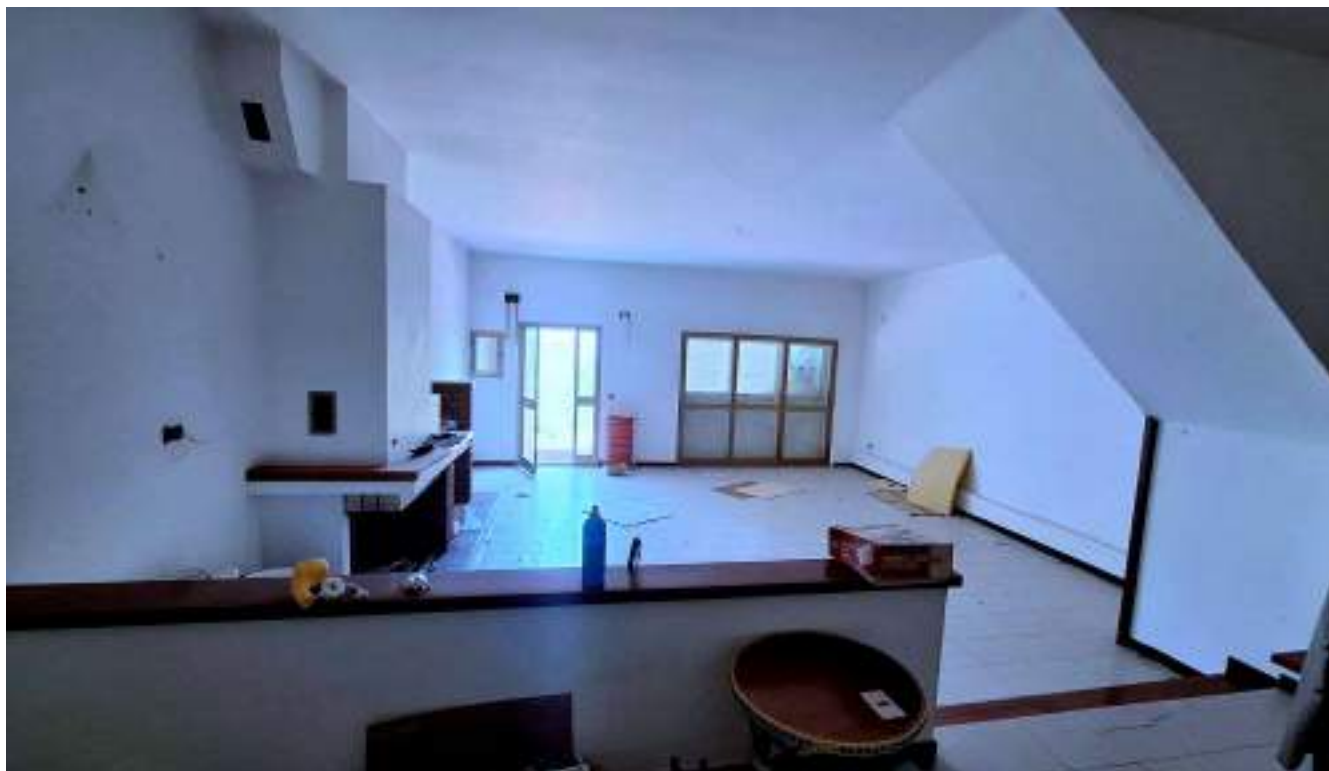
Foto n.9 – PIANO SEMINTERRATO – Vista dall'angolo cottura
