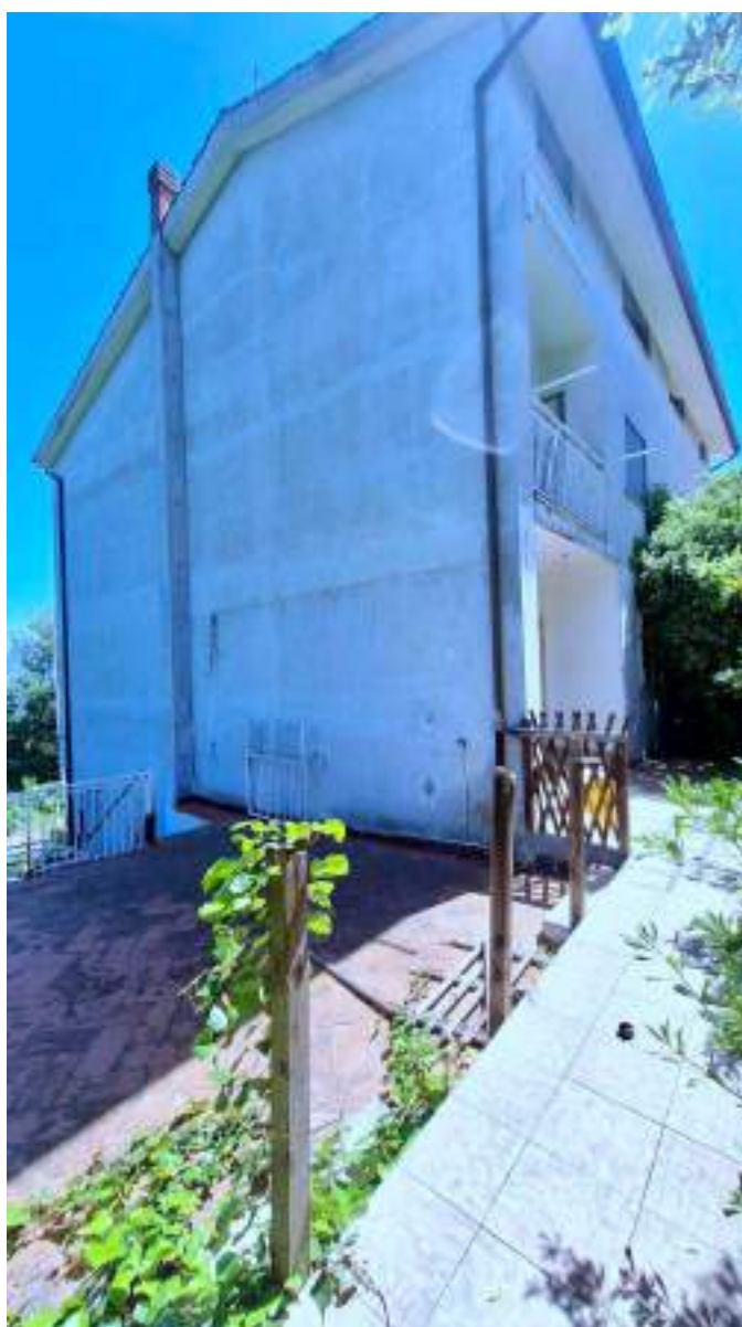
Foto n.2 – Vista prospettica su via Milone e parete NO
