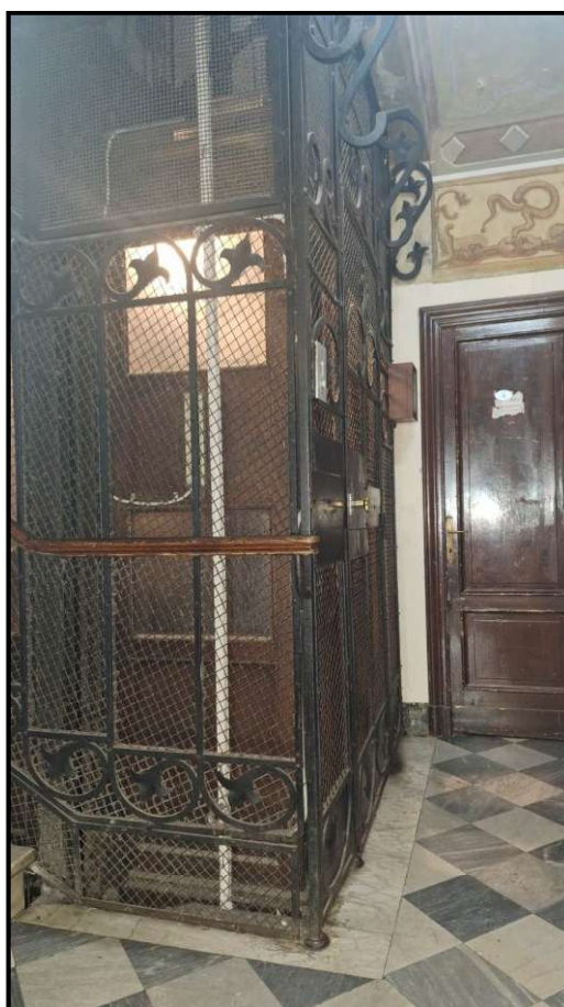
FOTO N. 5 – Vano scala e ascensore
