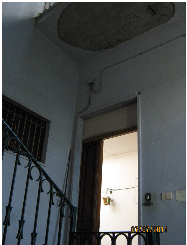
Foto n.9 – Pianerottolo di smonto e porta di caposala che consente l'accesso alla loggia comune
