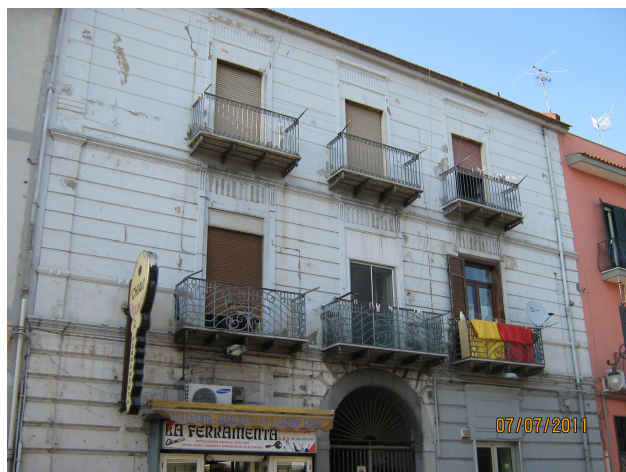
Foto n.3 – Facciata principale dell'edificio
