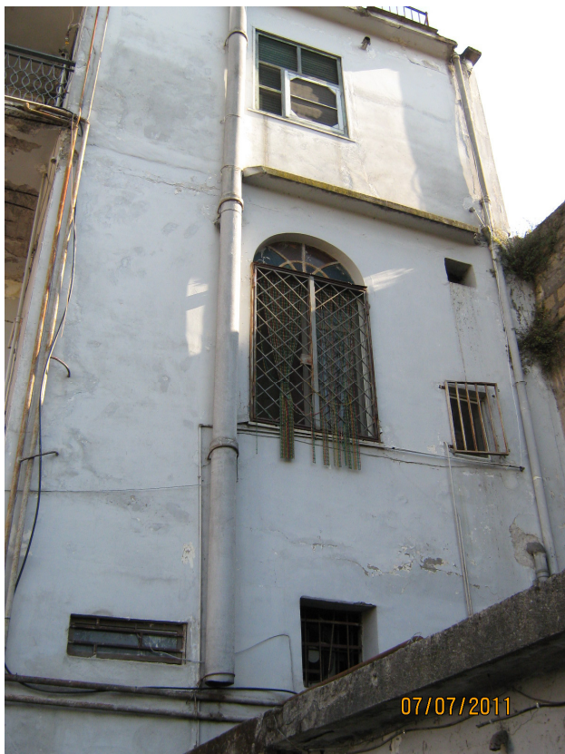
Foto n.7 – Porzione della facciata interna dell'edificio
