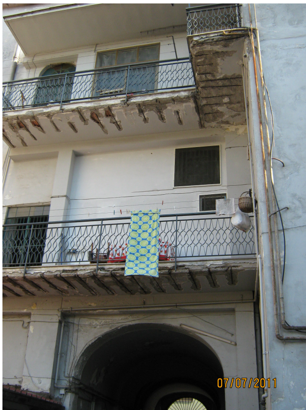
Foto n.6 – Porzione della facciata interna dell'edificio
