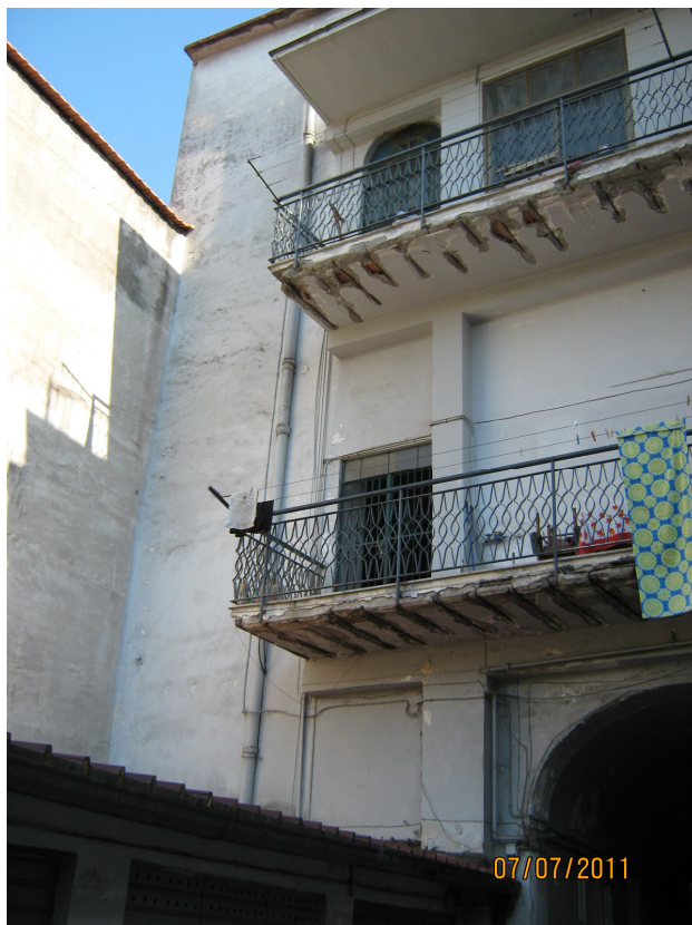
Foto n.5 – Porzione della facciata interna dell'edificio
