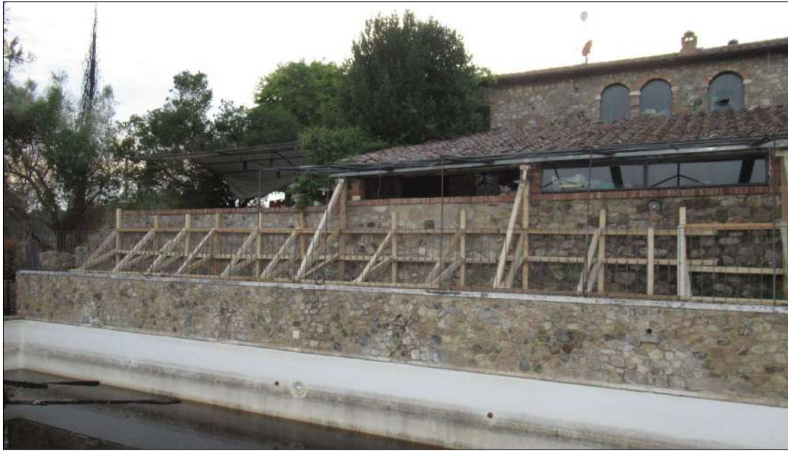
Foto DOPO I LAVORI
