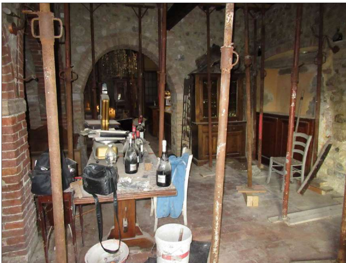
Foto DOPO I LAVORI
