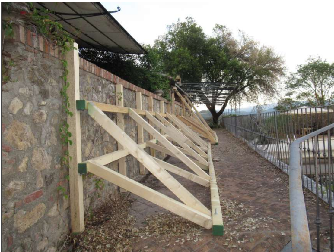
Foto DOPO I LAVORI
