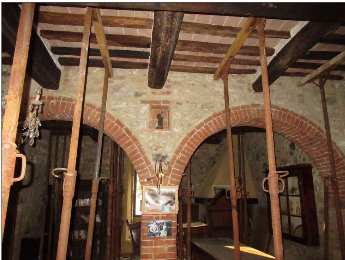
Foto DOPO I LAVORI
