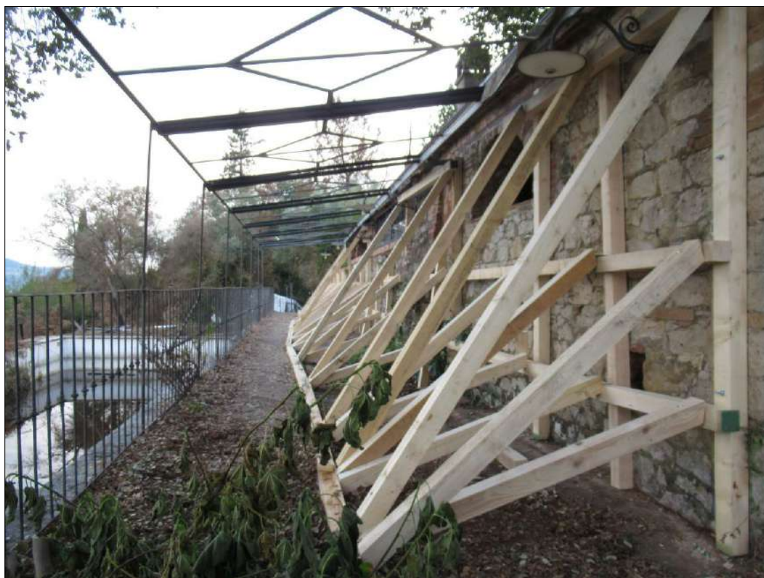
Foto DOPO I LAVORI
