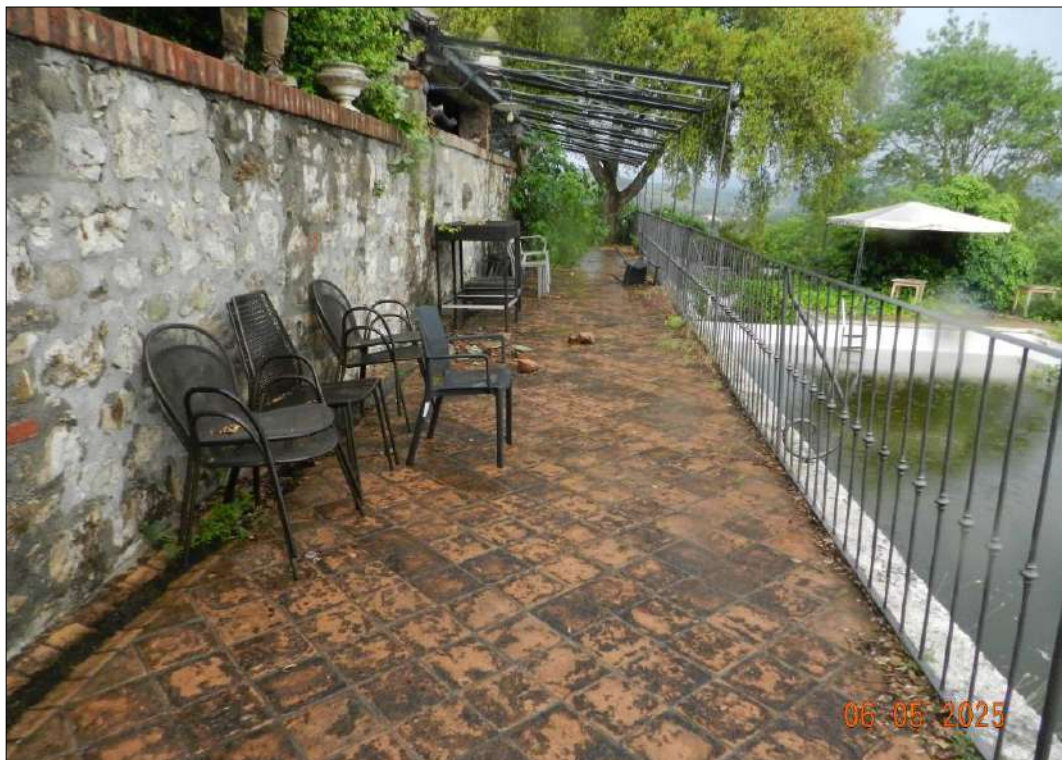
Foto PRIMA DEI LAVORI
