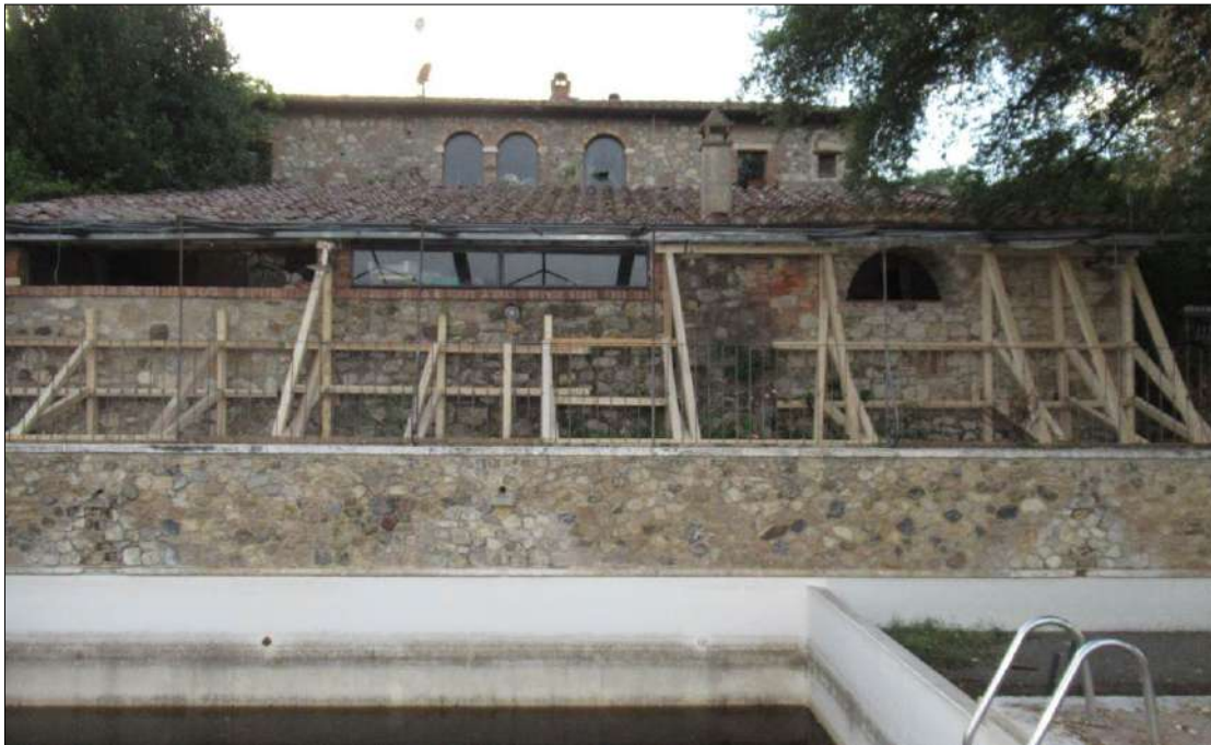
Foto DOPO I LAVORI
