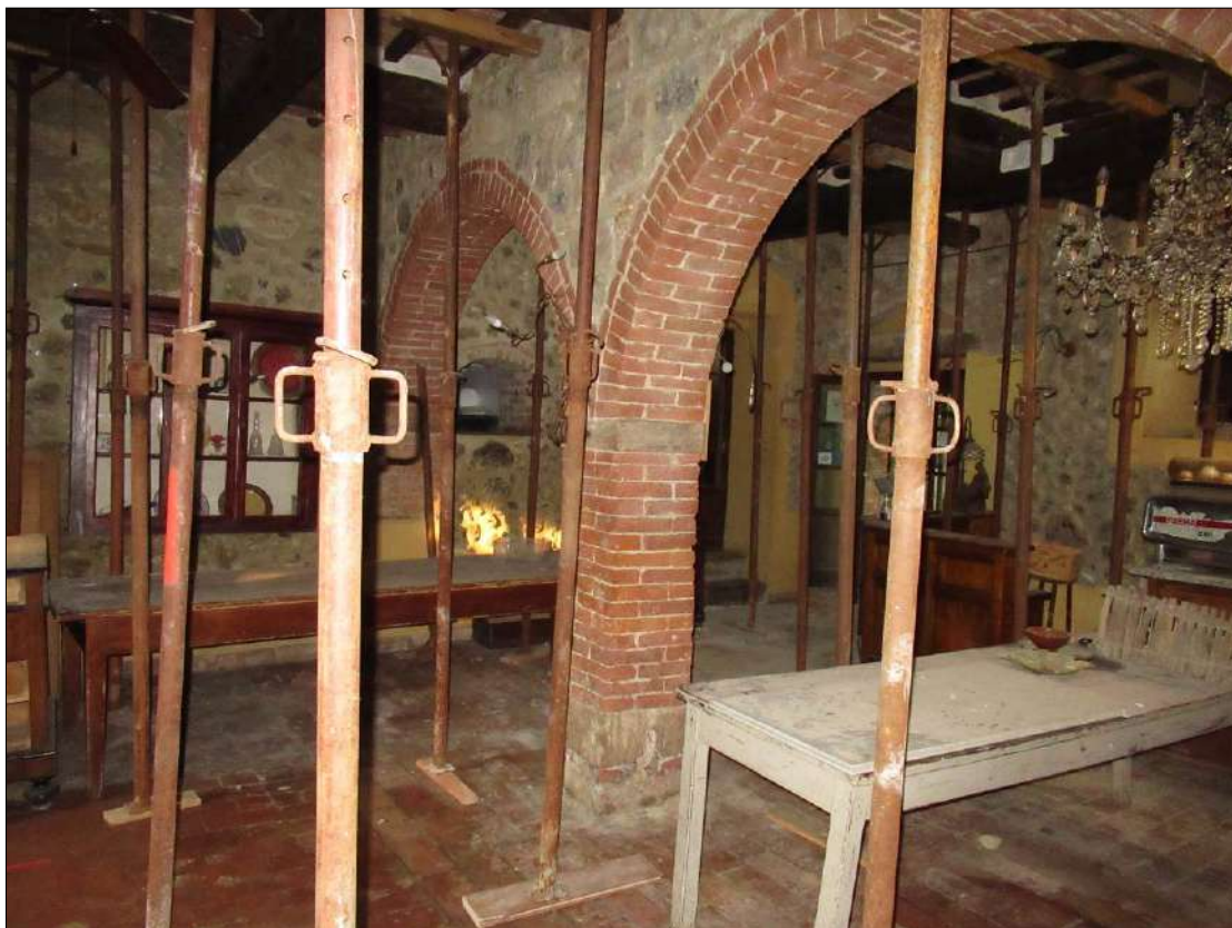
Foto DOPO I LAVORI
