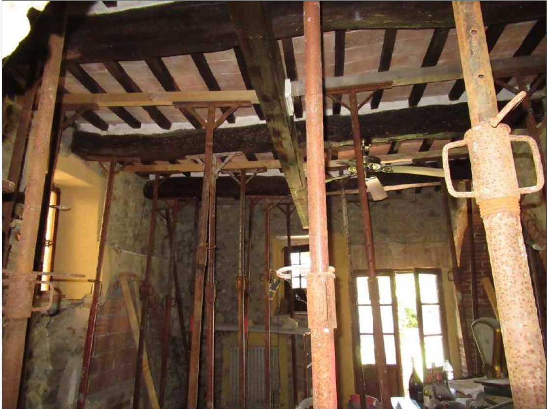
Foto DOPO I LAVORI
