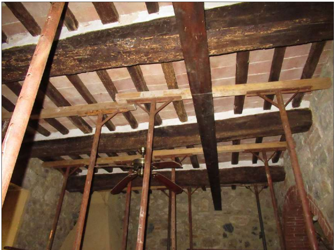
Foto DOPO I LAVORI
