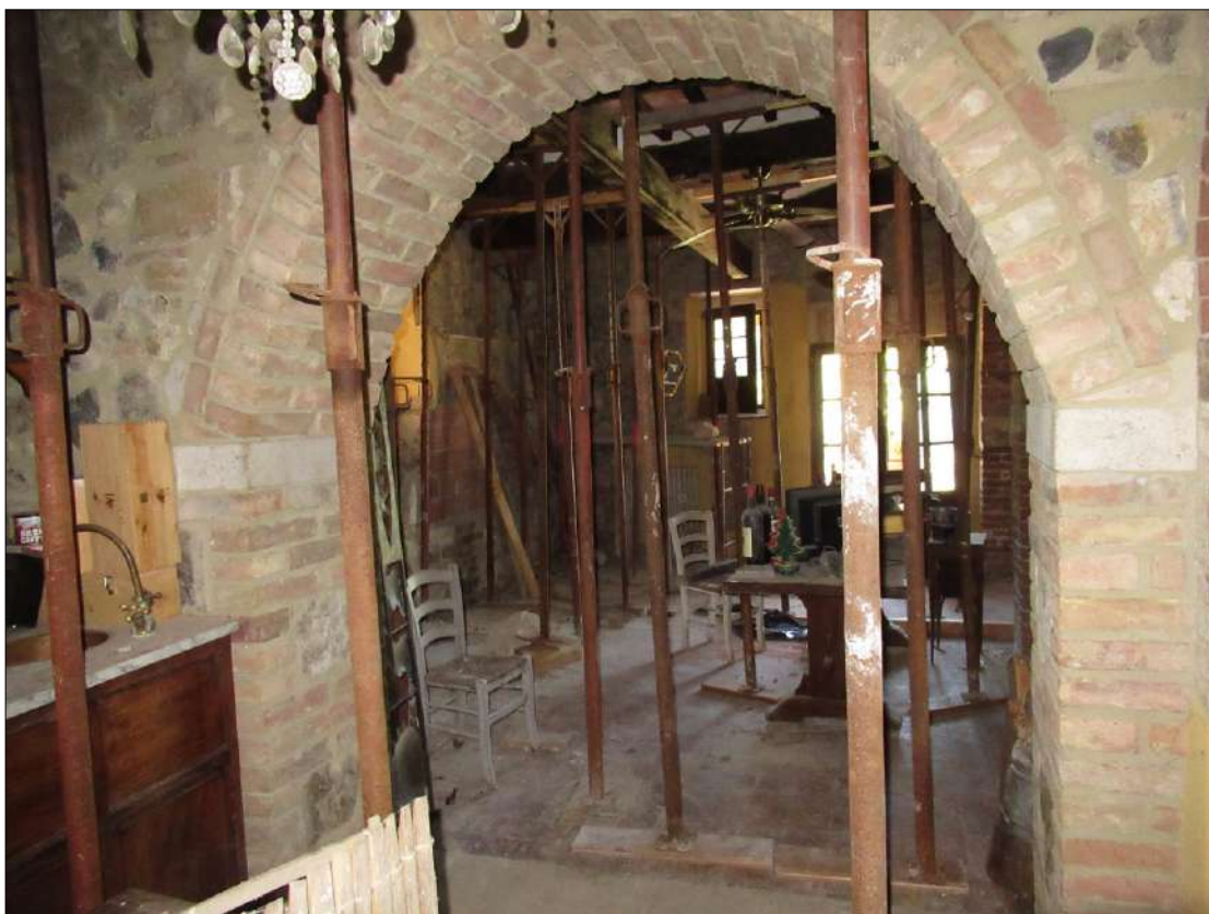
Foto DOPO I LAVORI
