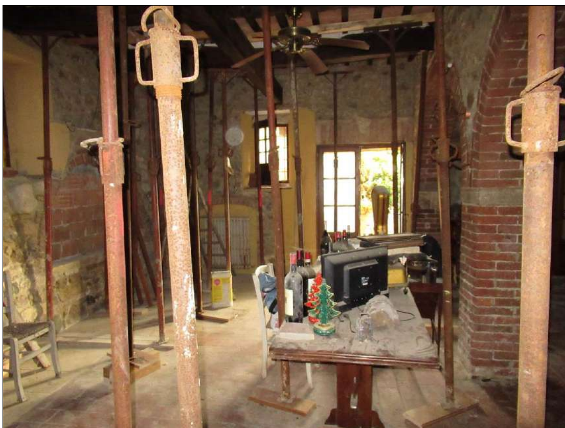
Foto DOPO I LAVORI
