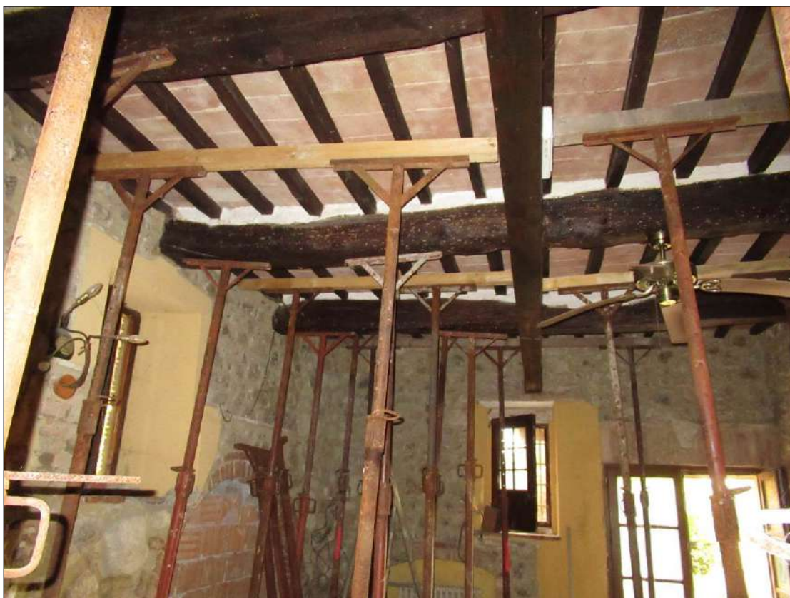
Foto DOPO I LAVORI
