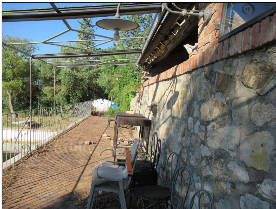
Foto PRIMA DEI LAVORI
