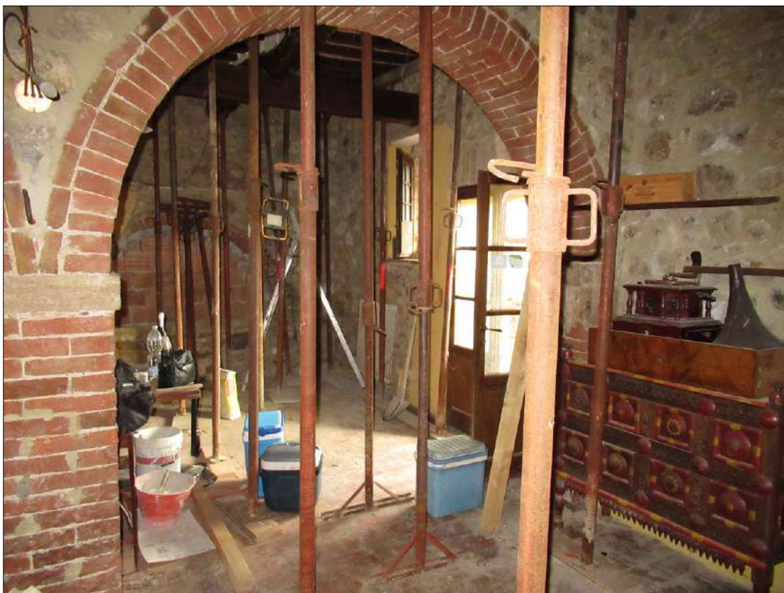
Foto DOPO I LAVORI
