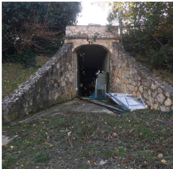
Foto 103 - Piano seminterrato, cavedio di ingresso al locale tecnico
