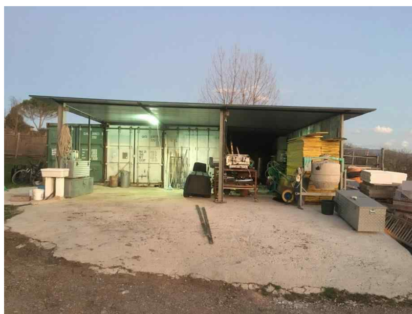
Foto 109 – Tettoia e n. 2 container (risulta all'interno del Foglio 123, Particella 11)
