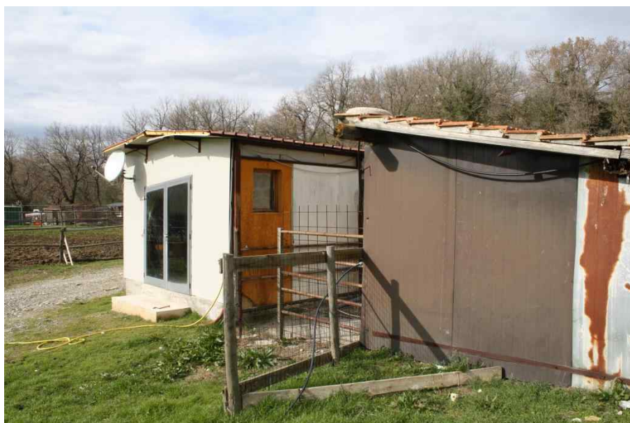
Foto 91 - Piano terra, prospetto Sud del fabbricato
