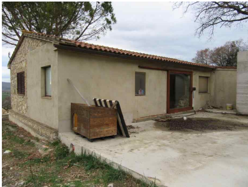
Foto 79 - Piano terra, prospetti Est e Nord del fabbricato
