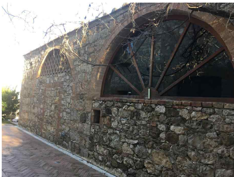
Foto 66 - Piano terra, prospetto Nord-Ovest esterno sala relax/prima colazione e magazzino
