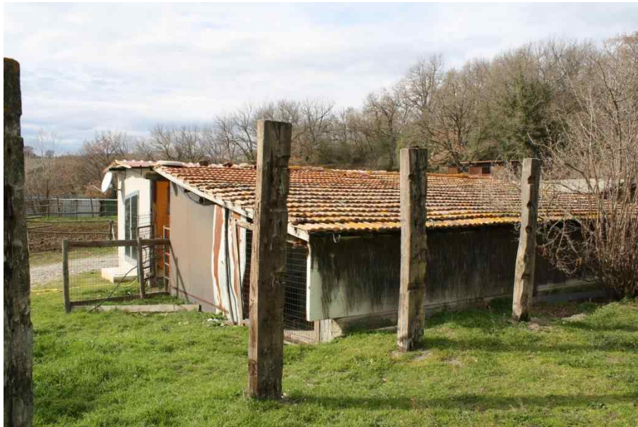
Foto 92 - Piano terra, prospetti Sud ed Est del fabbricato
