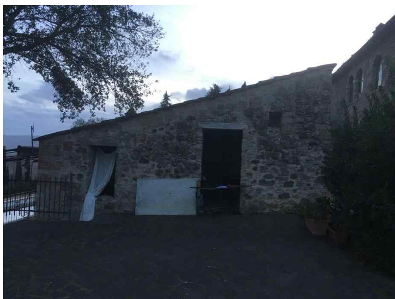
Foto 67 - Piano terra, prospetto Nord-Est esterno magazzino
