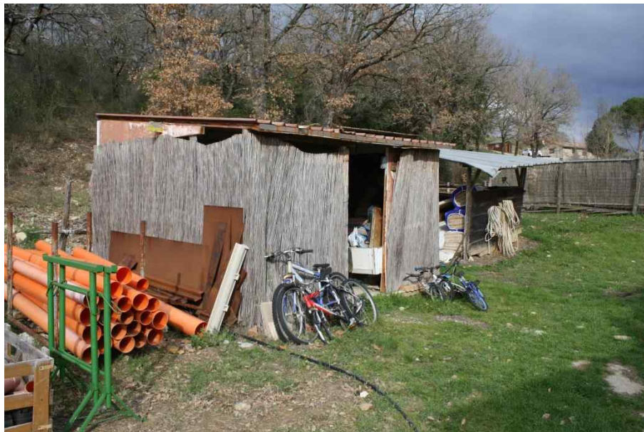
Foto 108 – Annesso e tettoia (risulta all'interno del Foglio 123, Particella 11)
