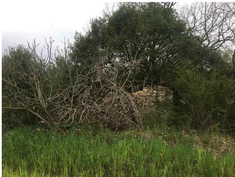
Foto 126 - Terreni Foglio 120, particella 110 - Fabbricato diruto
