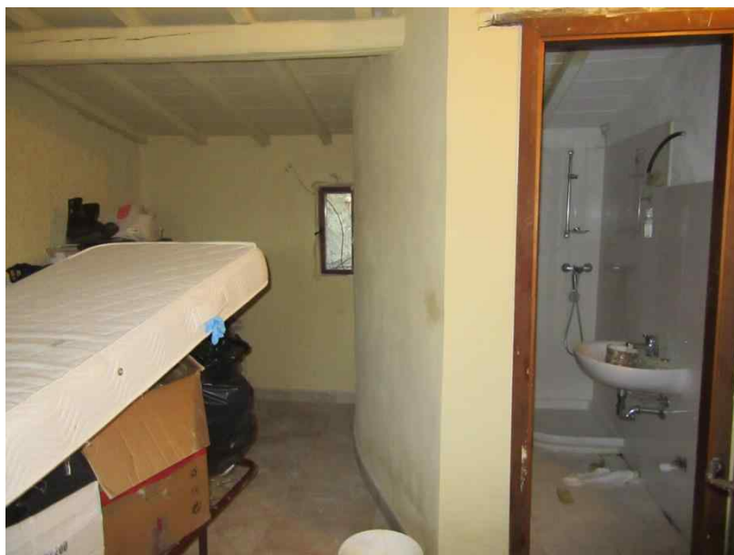
Foto 74 - Piano terra, ufficio
