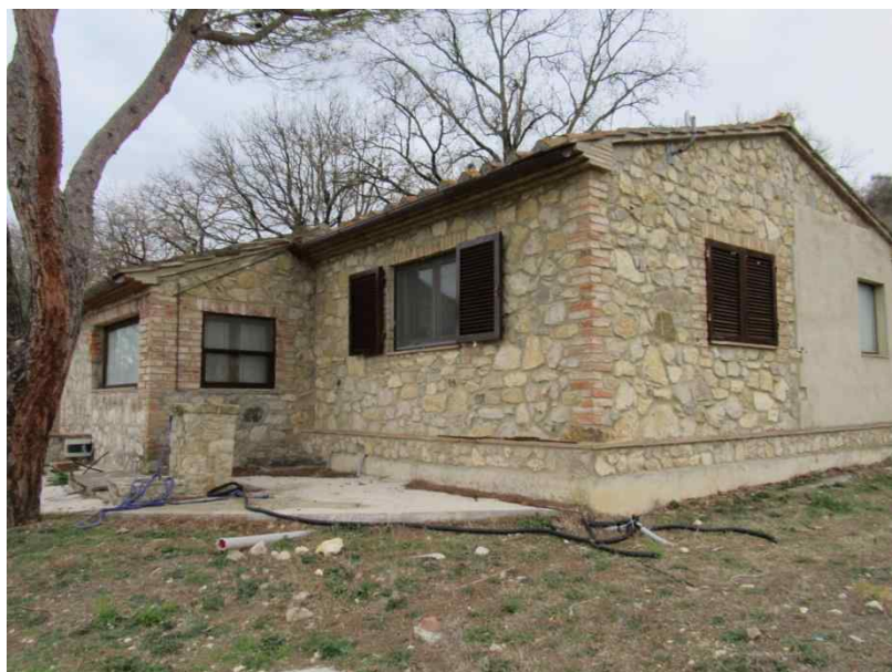
Foto 78 - Piano terra, prospetti Sud ed Est del fabbricato
