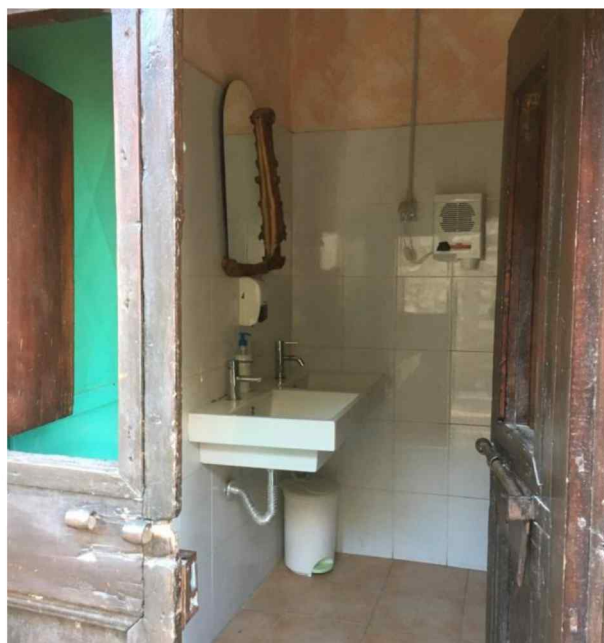
Foto 22 – Piano terra, disimpegno w.c. , prospetto Sud-Est
