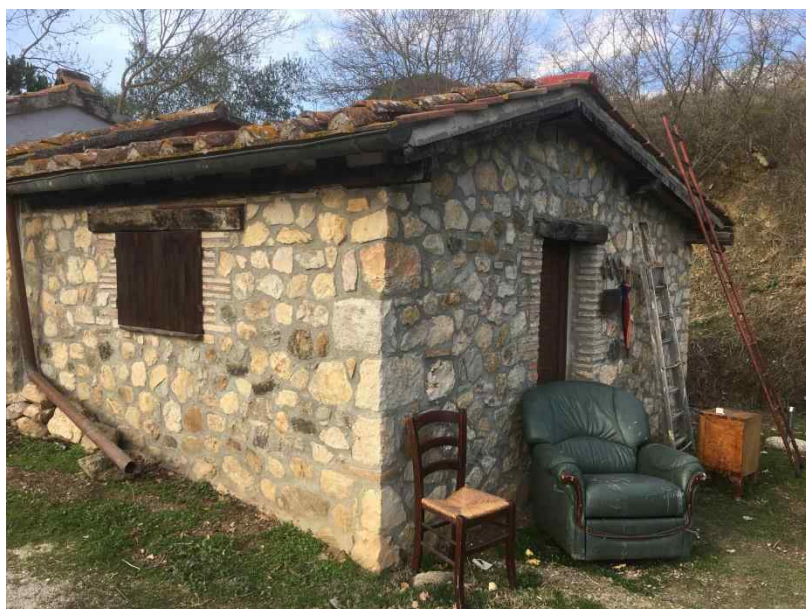
Foto 70 - Piano terra, prospetti Sud-Est e Nord-Est del fabbricato
