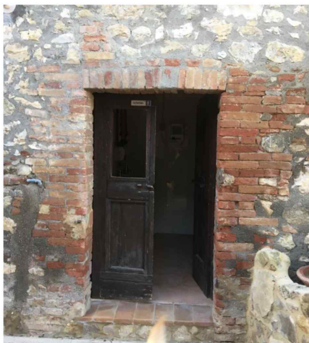
Foto 21 – Piano terra, ingresso w.c. e vano tecnico dall'esterno del fabbricato, prospetto Sud-Est
