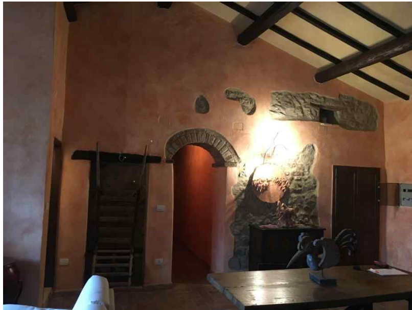
Foto 38 - Piano primo, Salone comune (Subalterno 3)
