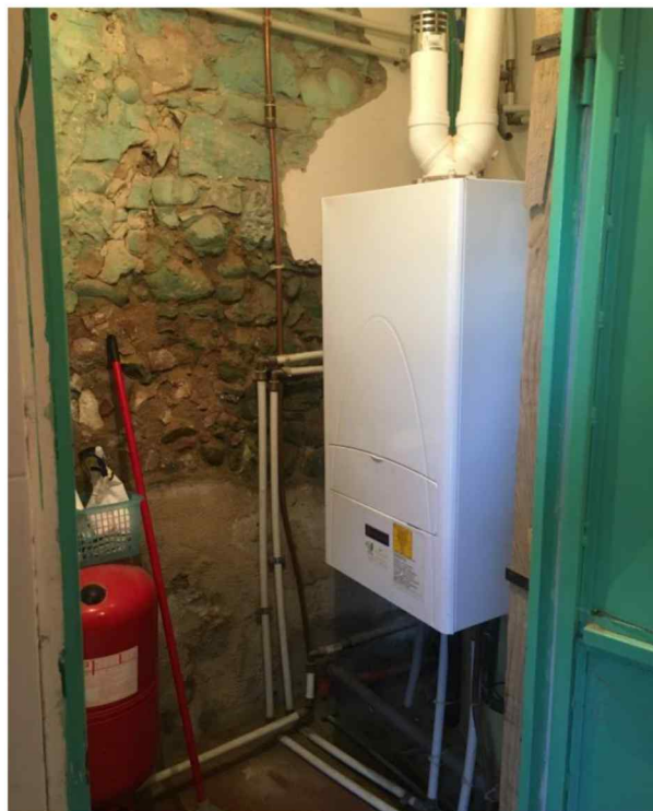
Foto 25 - Piano terra, vano tecnico, prospetto Sud-Est
