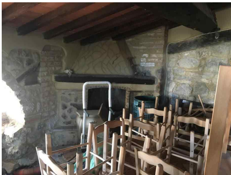
Foto 68 - Piano terra, magazzino
