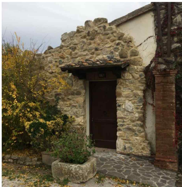
Foto 26 - Piano terra, ingresso camera "Margherita"
