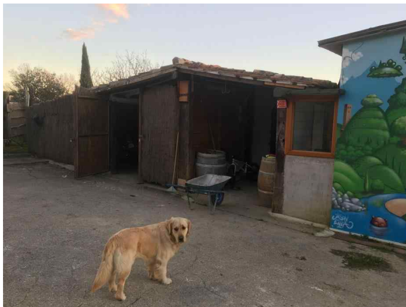
Foto 89 - Piano terra, prospetto Nord del fabbricato
