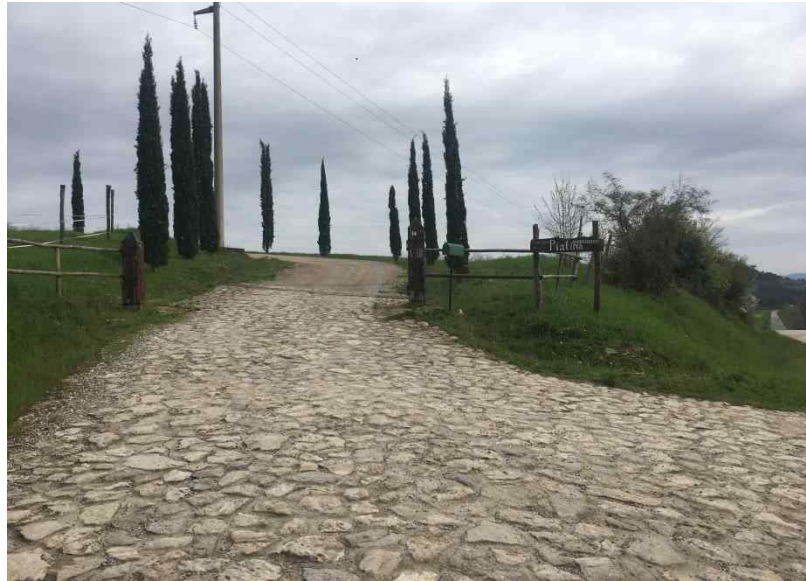
Foto 0 – Accesso dalla Strada Provinciale Leopoldina al numero civico 14
