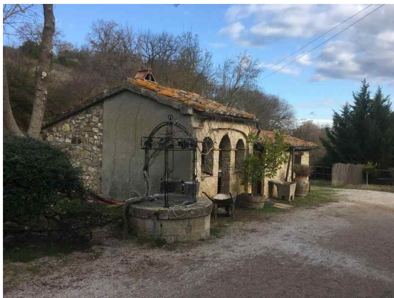
Foto 69 - Piano terra, prospetti Sud-Ovest e Sud-Est del fabbricato
