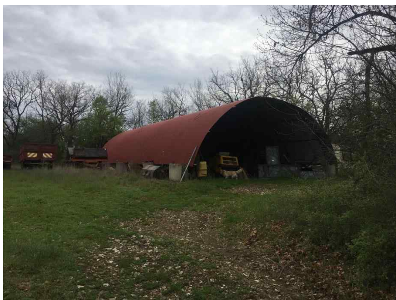
Foto 111 - Capannone (risulta all'interno del Foglio 123, Particella 7)
