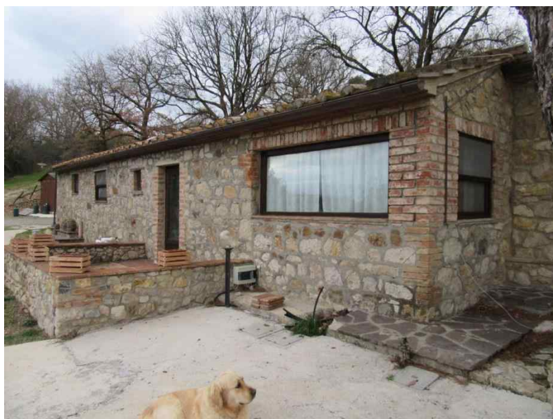
Foto 77 - Piano terra, prospetto Sud del fabbricato
