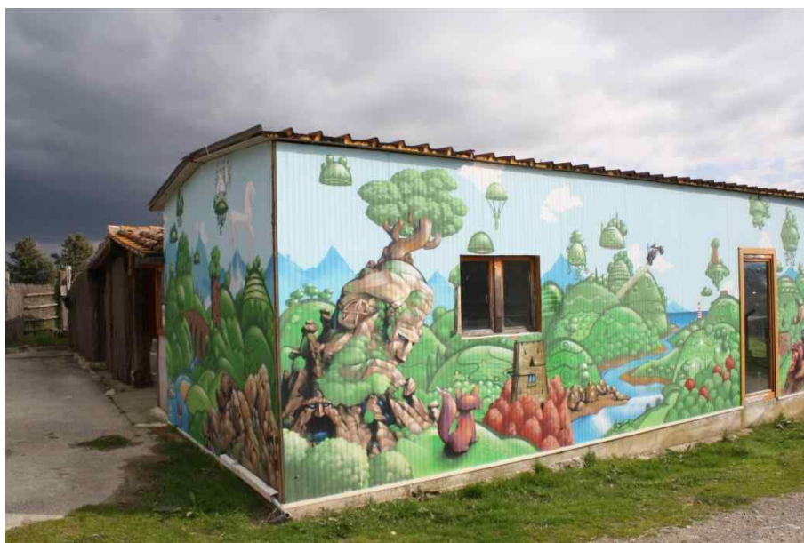
Foto 90 - Piano terra, prospetti Nord ed Ovest del fabbricato
