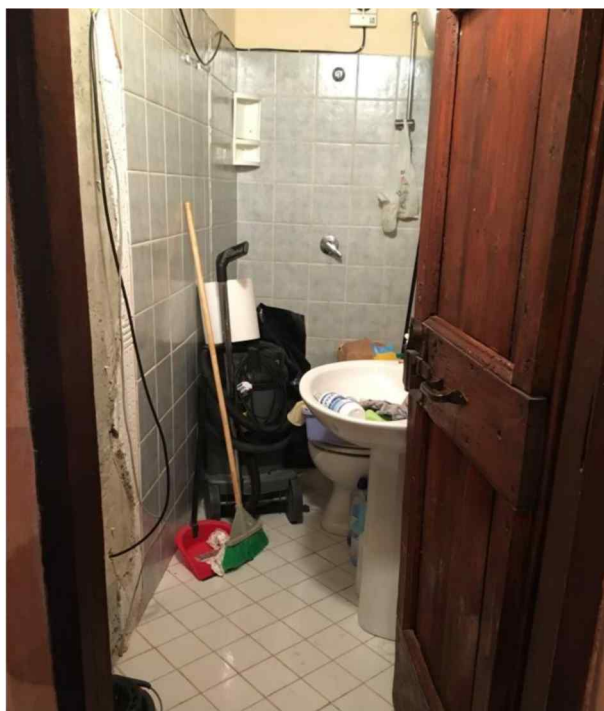
Foto 40 - Piano primo, bagno del salone comune (Subalterno 3)
