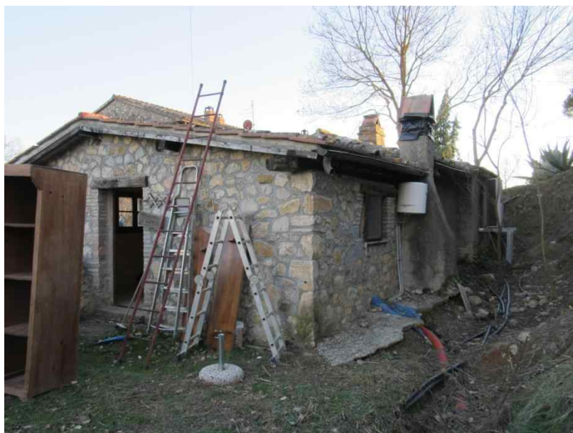
Foto 71 - Piano terra, prospetti Sud-Est e Nord-Ovest del fabbricato
