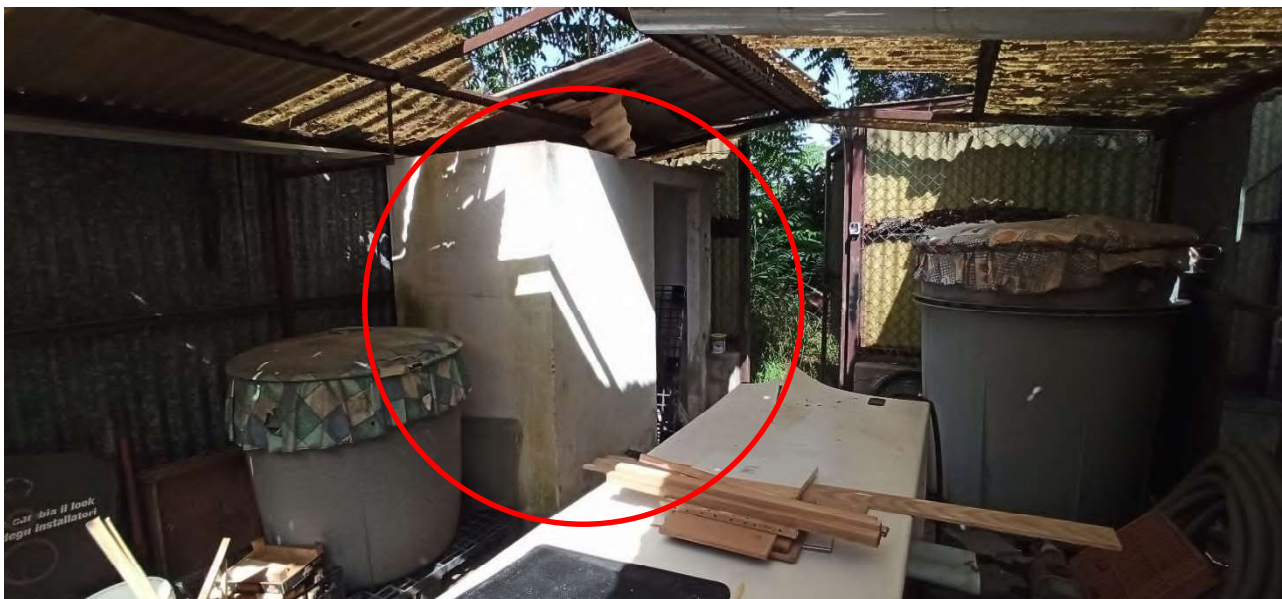
Figura 11 -Cortile lato nord-est - Tettoia e ripostiglio aperto realizzato all'interno
