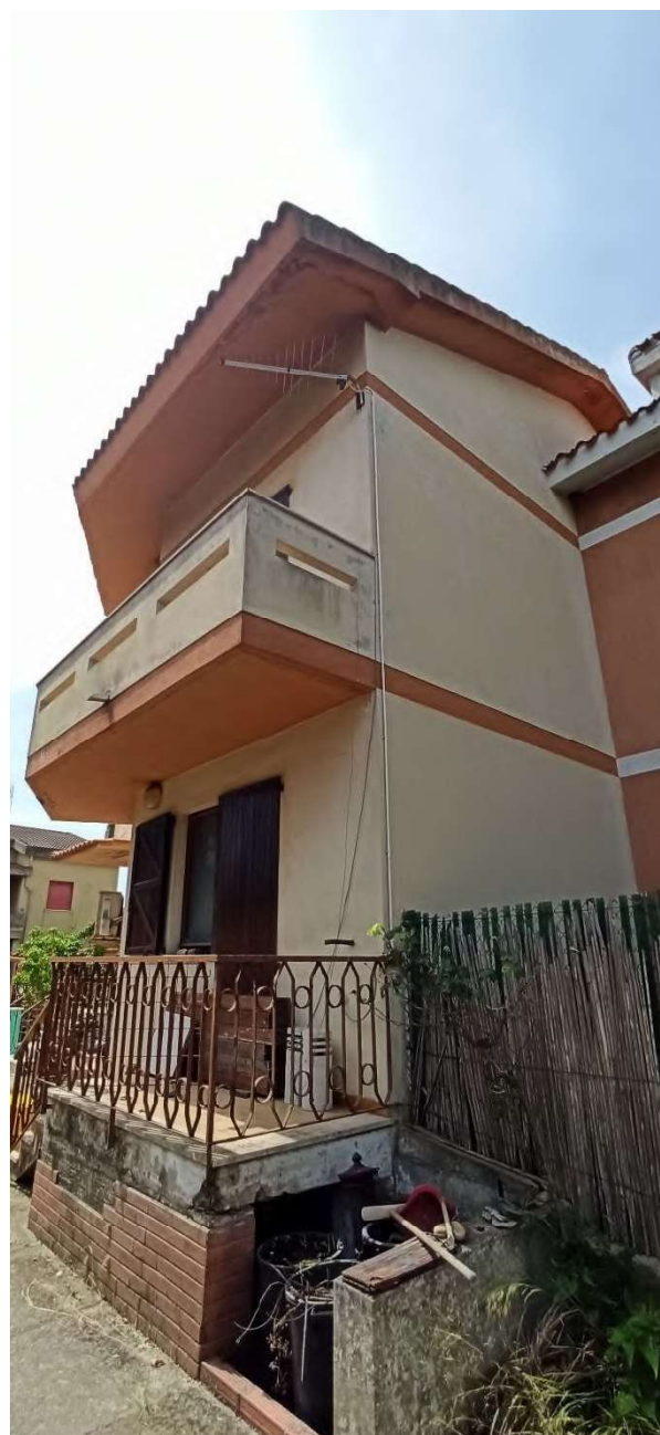
Figura 14 - Ingresso secondario e facciate nord-ovest e nord-est
