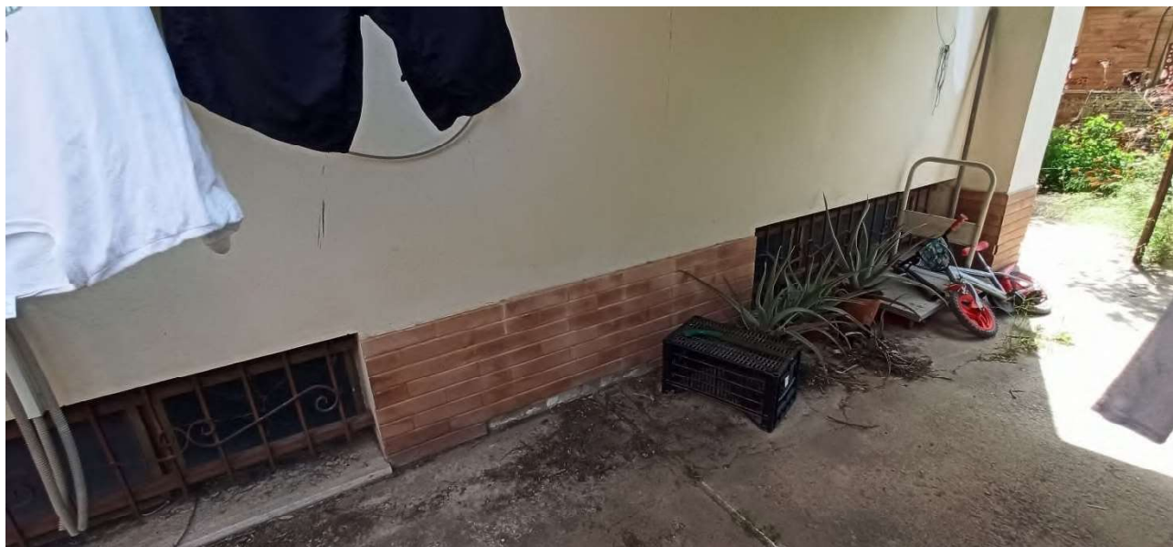
Figura 7 - Cortile lato sud-ovest - Finestre piano seminterrato
