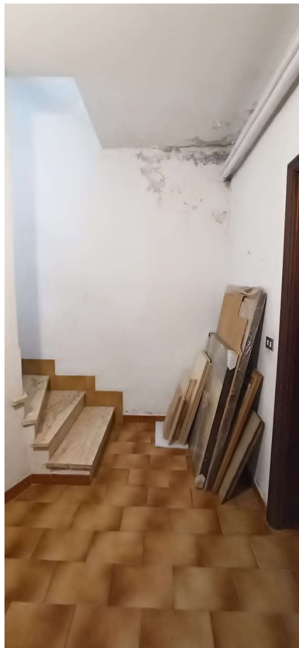
Figura 41 - Piano seminterrato - Disimpegno e scala di collegamento al piano terra
