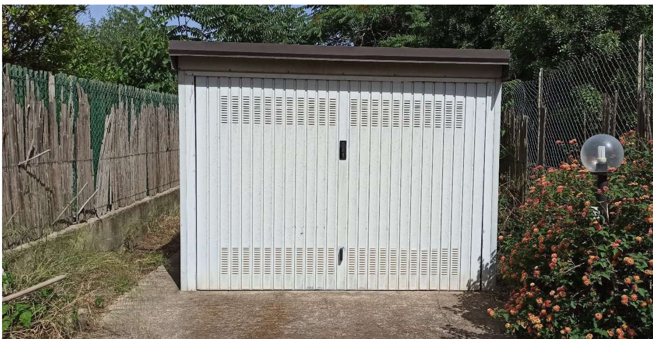
Figura 12 - Cortile lato nord-est - Box auto prefabbricato
