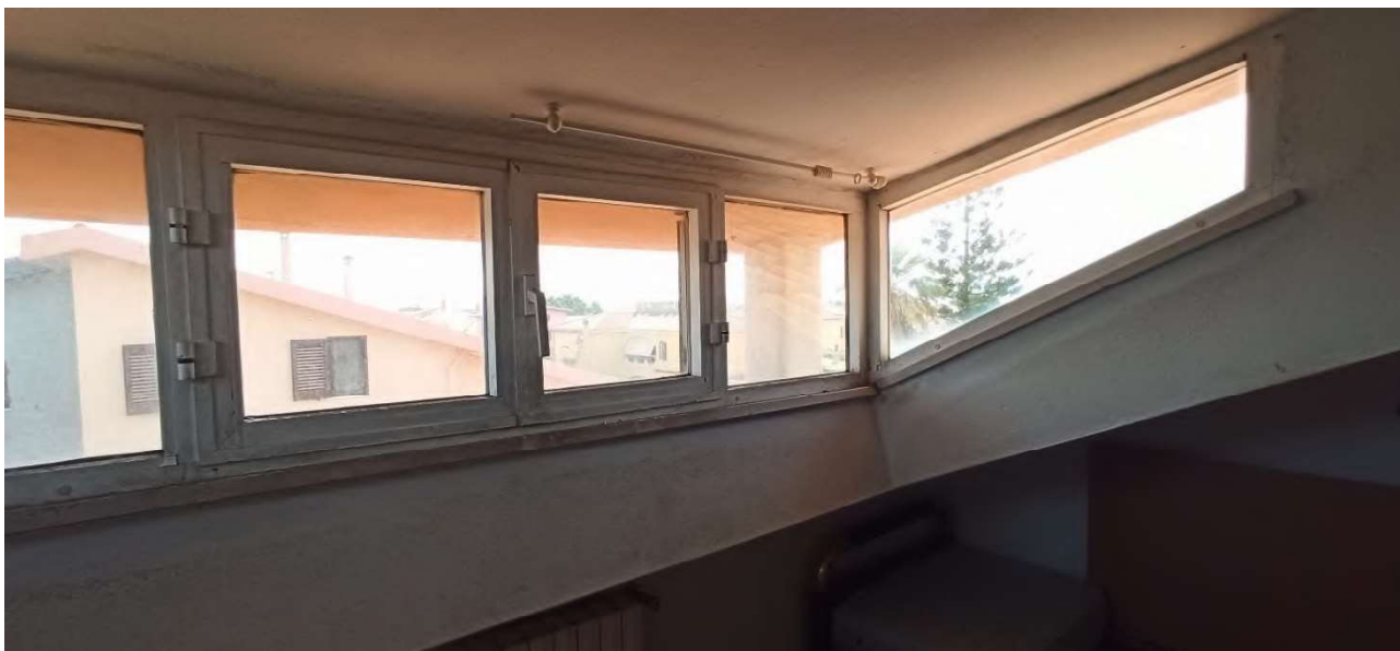
Figura 32 - Piano sottotetto - Particolare finestra locale di sgombero 1
