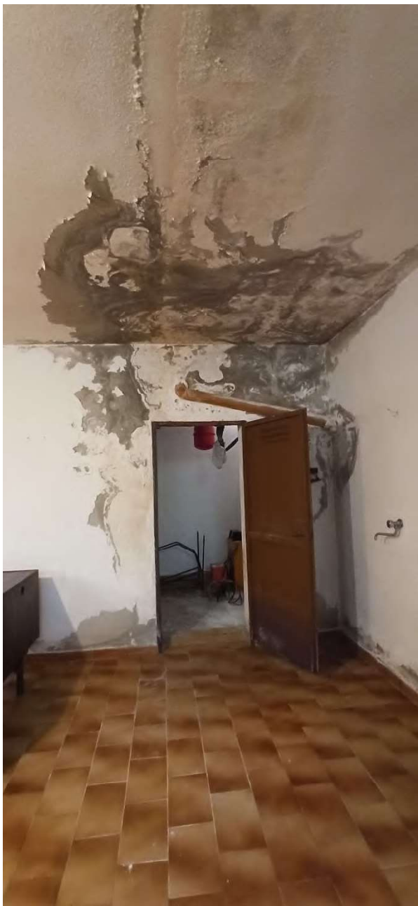
Figura 44 - Piano seminterrato - Porta centrale termica
