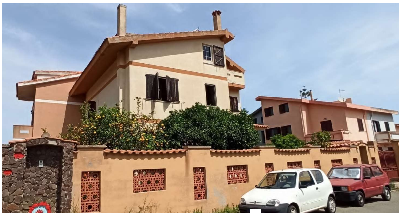
Figura 2 - Vista esterna da sud-est
