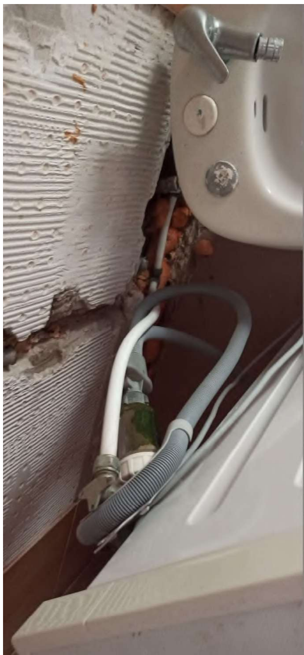
Figura 38 - Piano sottotetto - Bagno - Particolare
