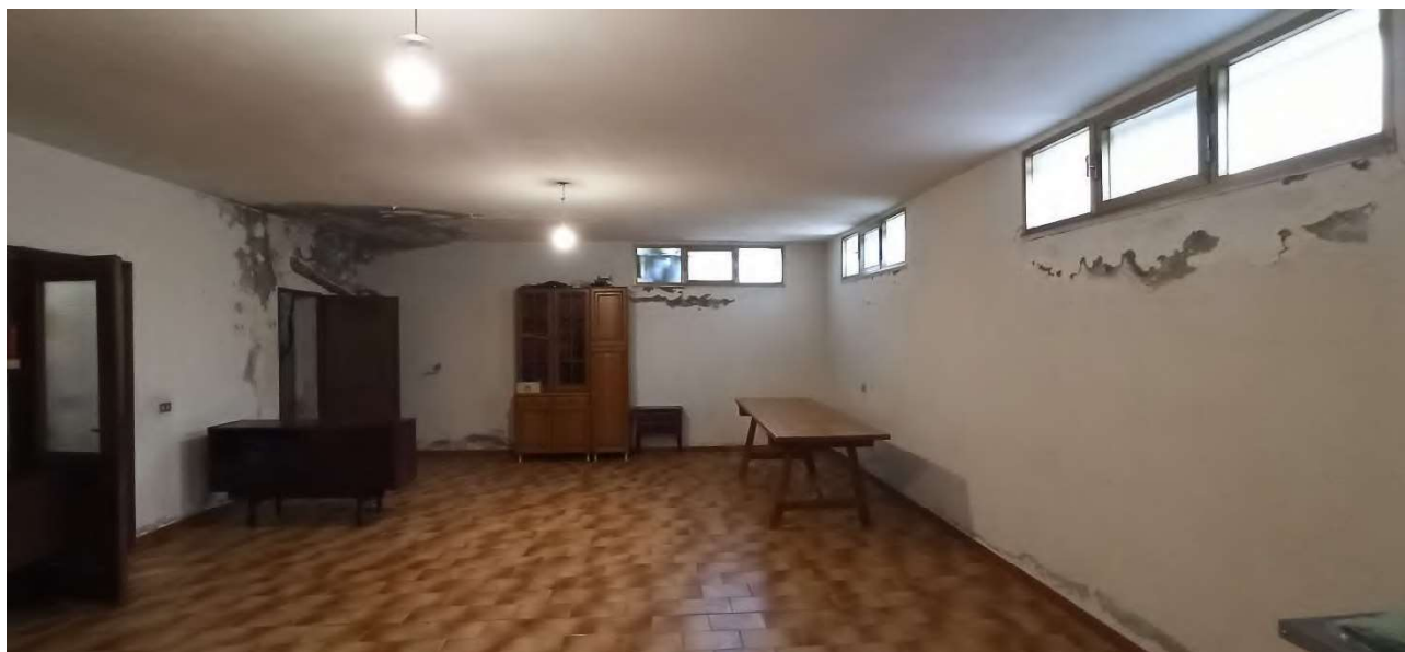
Figura 42 - Piano seminterrato – Cantina 1
