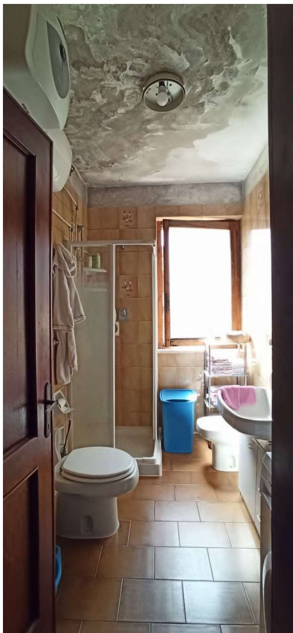
Figura 21- Piano terra - Bagno
