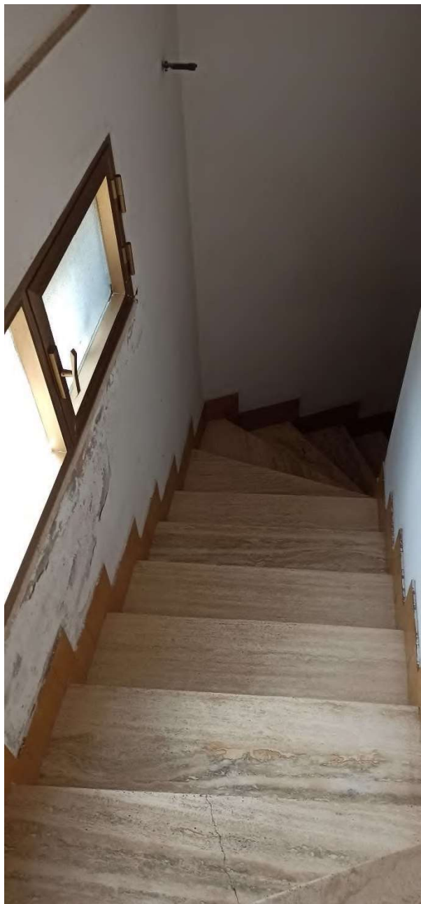
Figura 40 - Scala di collegamento dal piano terra al piano seminterrato
