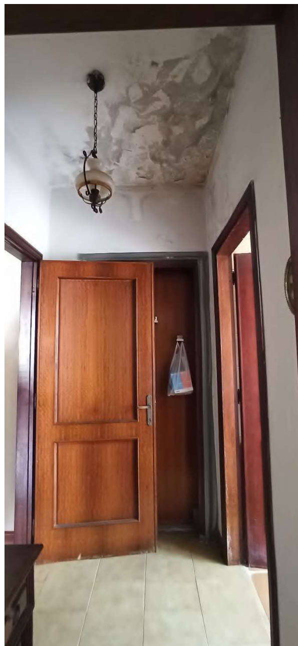
Figura 22 - Piano terra - Disimpegno
