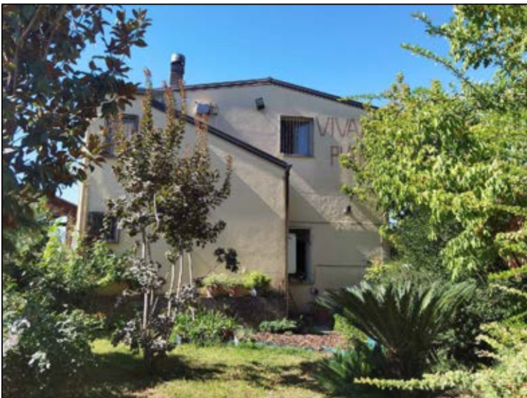
FOTO 38 - Lotto 2 - Corpo C - Esterni
