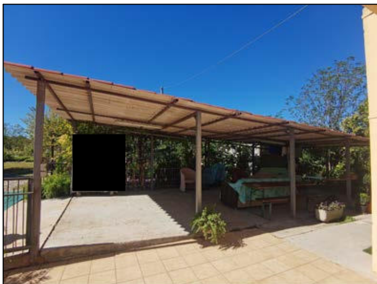
FOTO 35 - Lotto 2 - Corpo B - Tettoia
