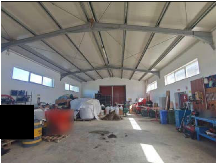
FOTO 22 - Lotto 2 - Corpo A - Interni Capannone Agricolo
