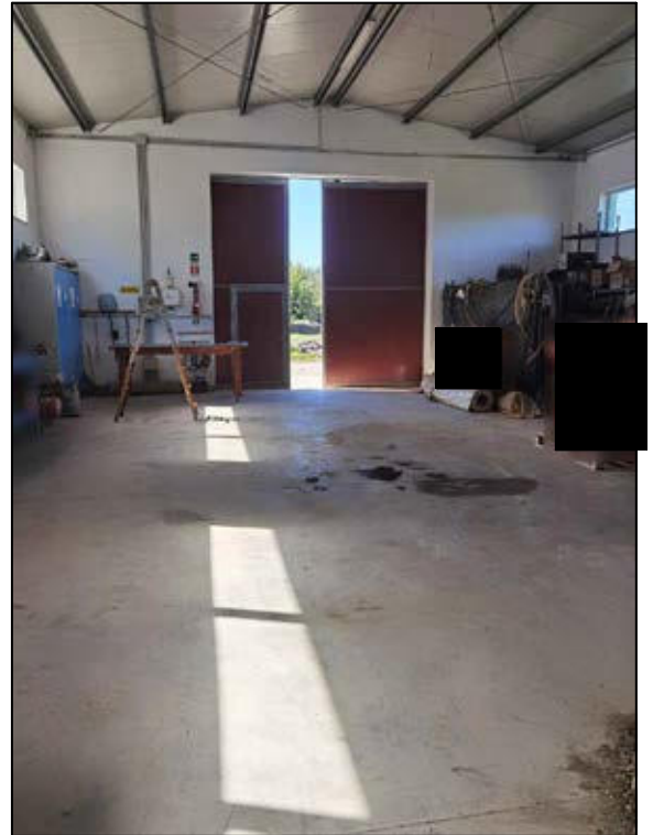
FOTO 21 - Lotto 2 - Corpo A - Interni Capannone Agricolo
