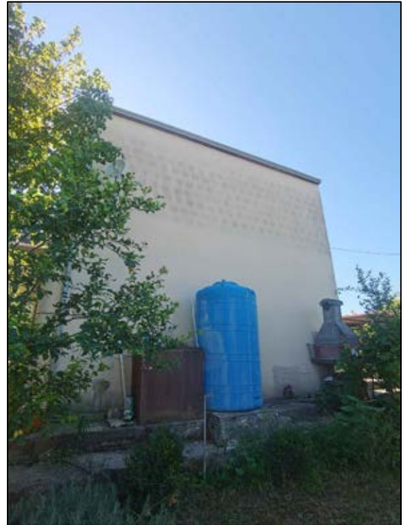
FOTO 37 - Lotto 2 - Corpo C - Esterni
