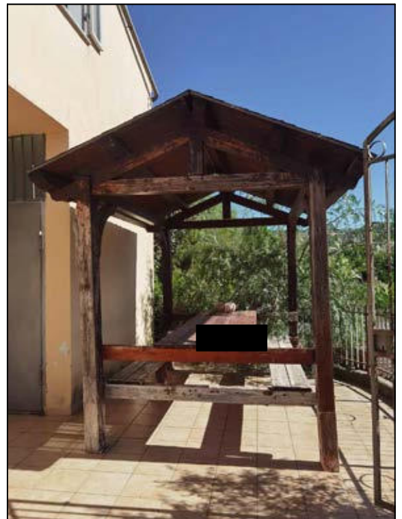
FOTO 39 - Lotto 2 - Corpo C - Gazebo sul lato Sud-Ovest
