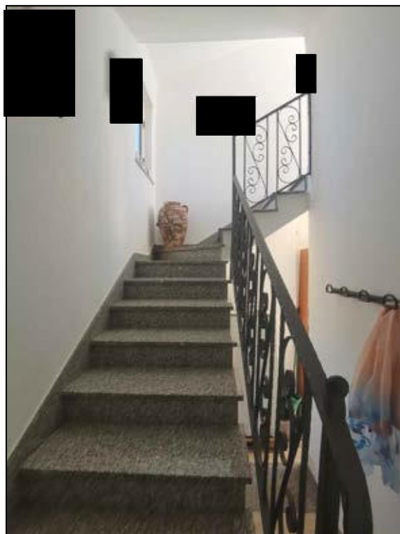
FOTO 49 - Lotto 2 - Corpo C - Interni (Scala interna)
