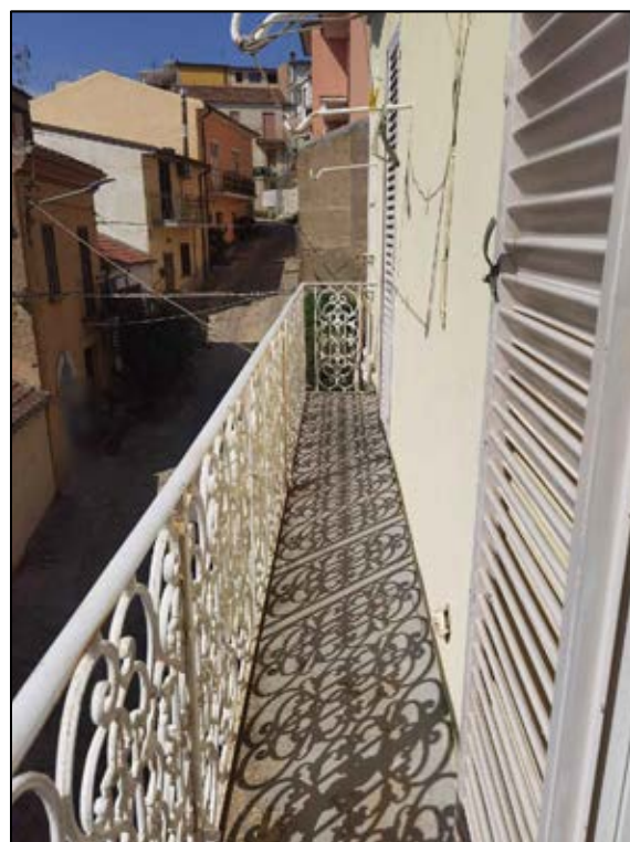
FOTO 18 - Lotto 1 - Balcone al piano secondo
