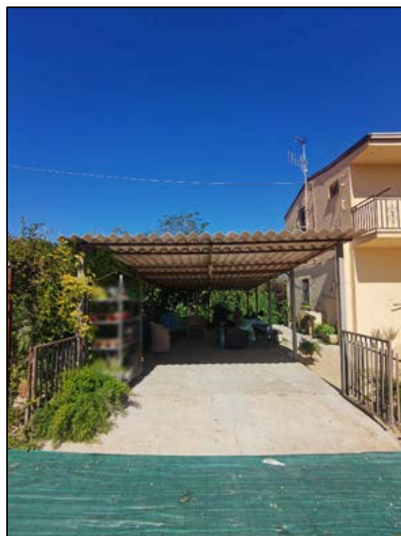
FOTO 34 - Lotto 2 - Corpo B - Tettoia
