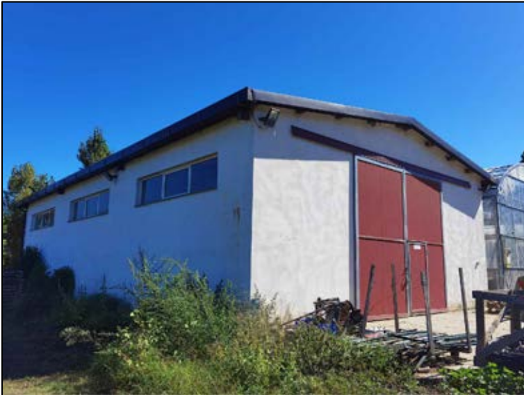
FOTO 20 - Lotto 2 - Corpo A - Esterni Capannone Agricolo
