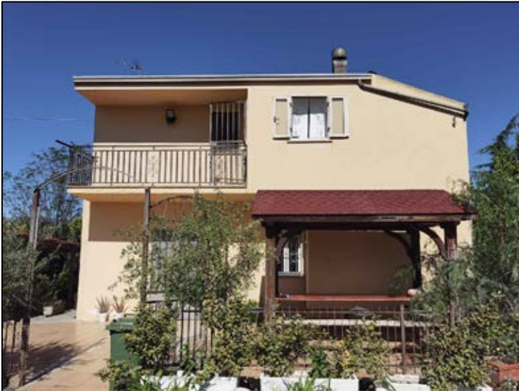
FOTO 36 - Lotto 2 - Corpo C - Esterni
