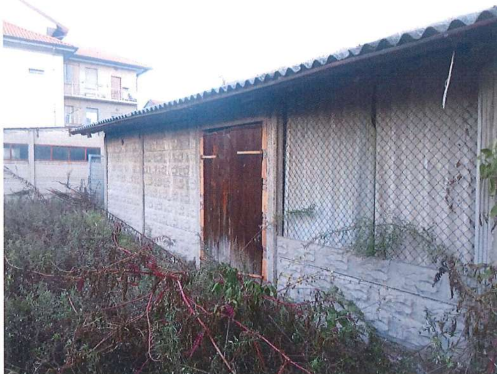
FOTO 7 - PIANO OTTAVO – vista esterna – locale deposito
