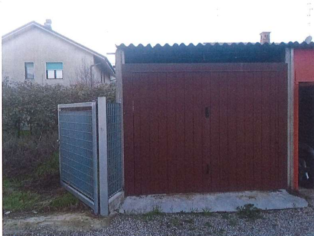
FOTO 3 - PIANO TERRENO – vista esterna – Box
