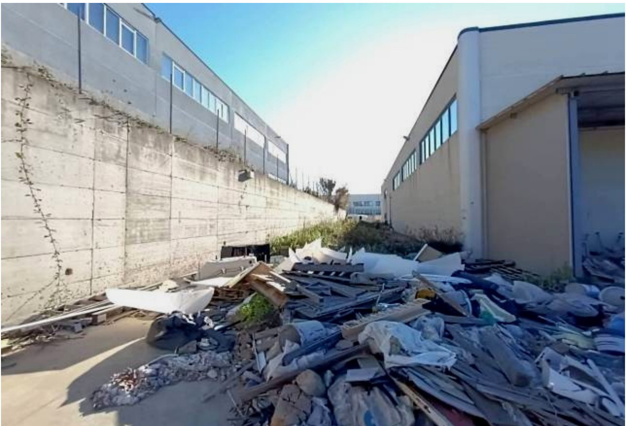
Figg.12-14 Via A. Molinari (già Via Vigne Turci) Civitavecchia (RM) Fg. 13 P.Ila 640 - Il fabbricato industriale e l'area esterna pertinenziale (sopra) prospetto laterale NordOvest con tettoia 9x5m priva di titolo; (sotto) prospetto posteriore NordEst
