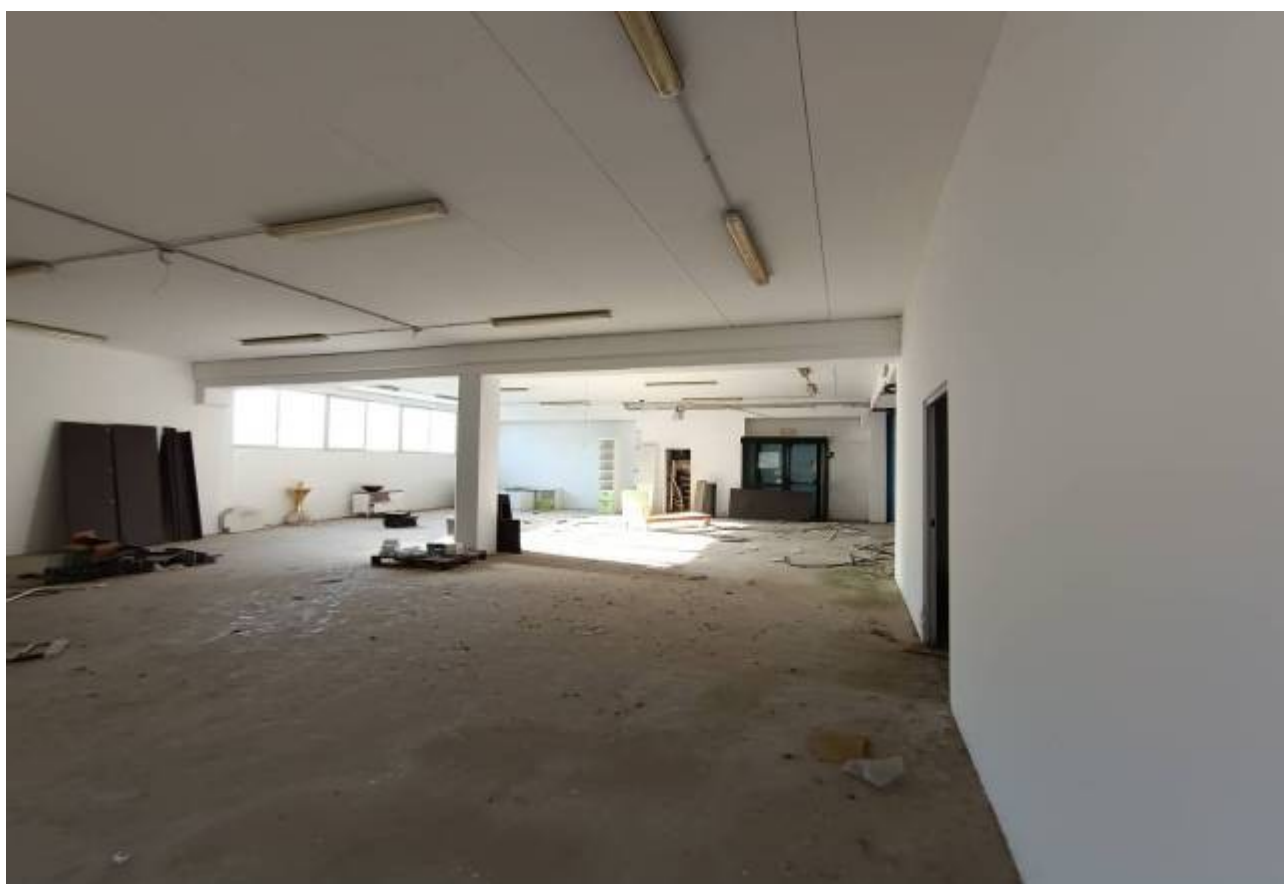
Figg.29-30 Via A. Molinari (già Via Vigne Turci) Civitavecchia (RM) Fg. 13 P.Ila 640 Sub. 2 - Il fabbricato industriale: interno dell'area espositiva al PT sul lato SUDest, in parte sottostante l'abitazione del custode posta al P1
