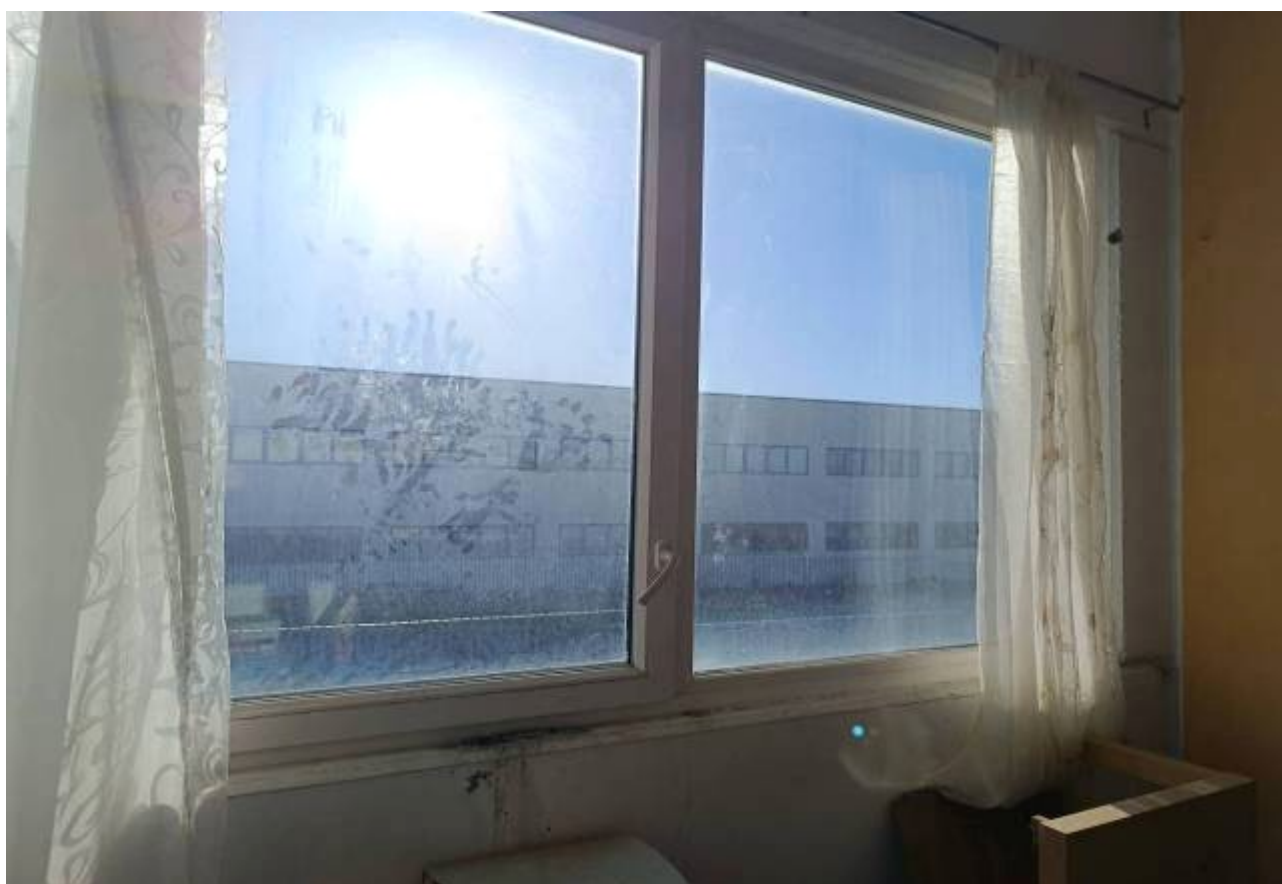
Figg.60-61 Via A. Molinari (già Via Vigne Turci) Civitavecchia (RM) Fg. 13 P.Ila 640 Sub. 1 - Il fabbricato industriale: abitazione custode al P1 – camera 1 con affaccio a SudEst su Via Molinari
