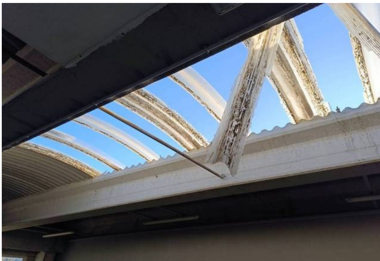
Figg.48-49 Via A. Molinari (già Via Vigne Turci) Civitavecchia (RM) Fg. 13 P.IIa 640 Subb. 1-2 - Il fabbricato industriale: interno dell'area magazzino al P1 ad uso magazzino, in parte soppalcato, con accesso pedonale dalla scala; particolari della copertura composta da pannelli ondulati in pvc lesionati e divelti sotto l'azione degli agenti atmosferici
