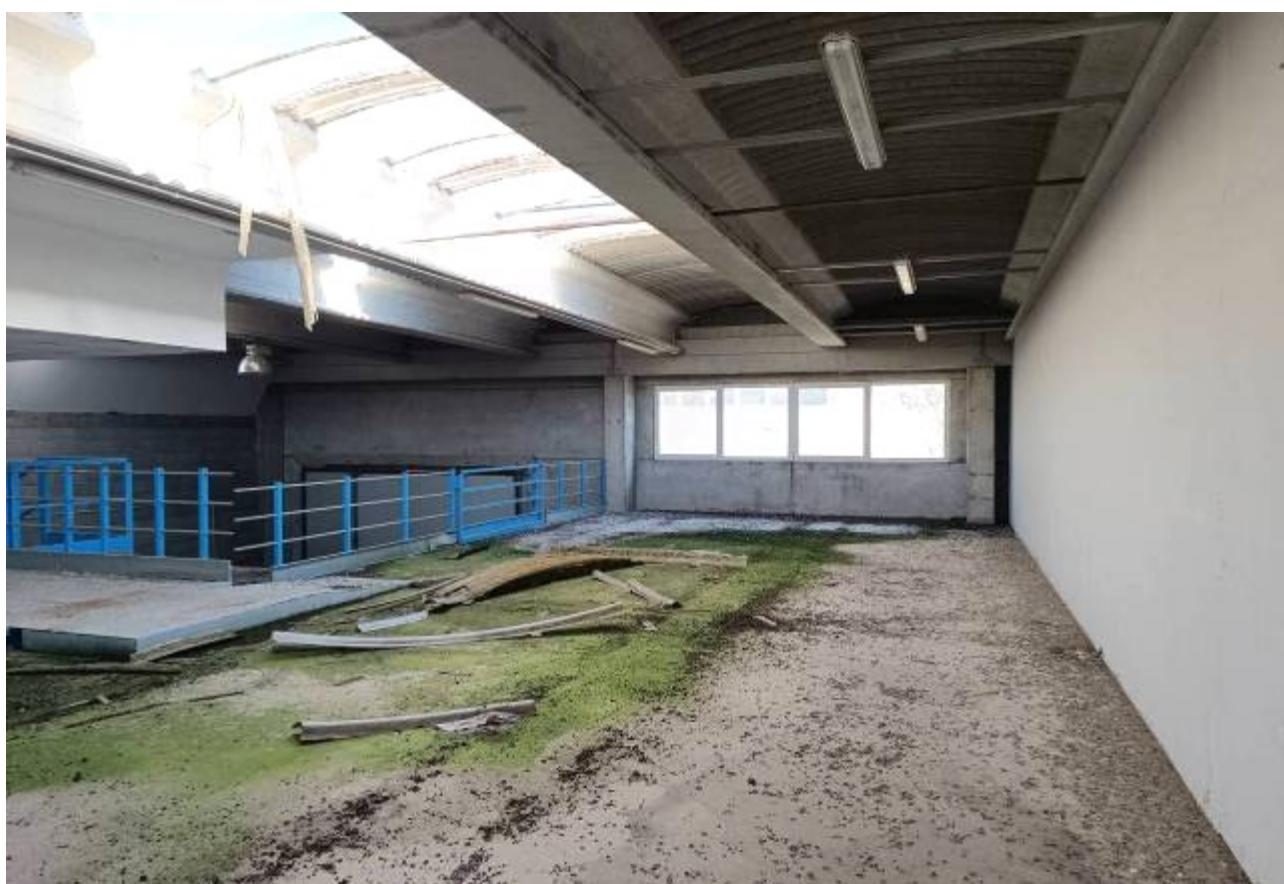
Figg.42-43 Via A. Molinari (già Via Vigne Turci) Civitavecchia (RM) Fg. 13 P.Ila 640 Sub. 2 - Il fabbricato industriale: interno dell'area magazzino al P1 ad uso magazzino, in parte soppalcato, con accesso pedonale dalla scala
