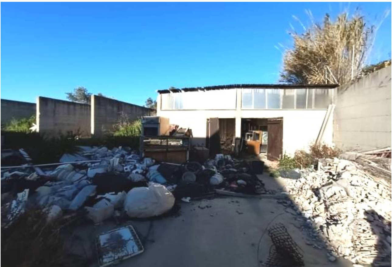
Figg.12-14 Via A. Molinari (già Via Vigne Turci) Civitavecchia (RM) Fg. 13 P.lla 640 - Il fabbricato industriale e l'area esterna pertinenziale - vista NordOvest con i n. 5 setti in c.a. realizzati per lo stoccaggio dei materiali all'aperto: due campate sono state coperte con copertura in legno e lamiera e tamponate frontalmente con muratura intonacata, a costituire volumetria con ampliamento di sup. utile di \approx 70\text{mq}
