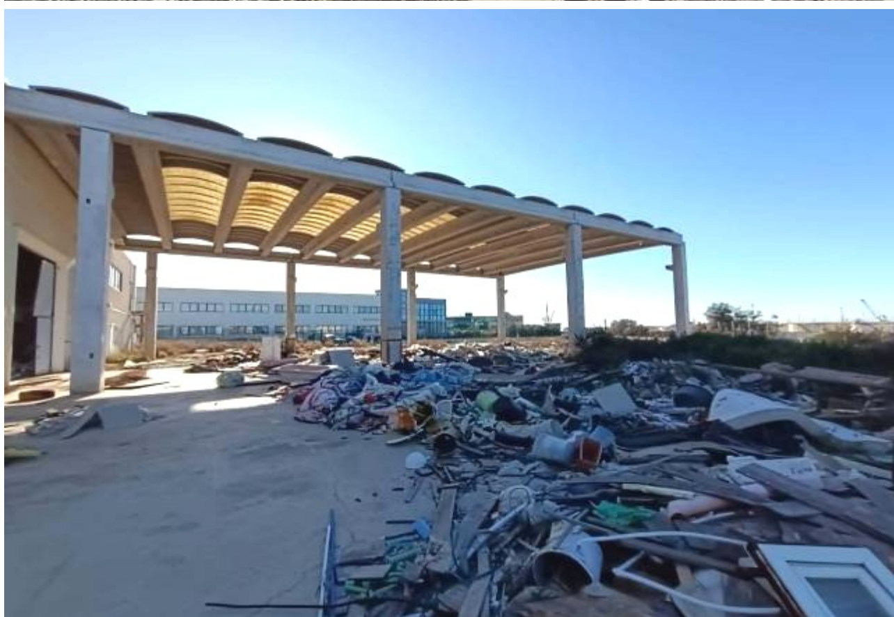
Figg. 9-10 Via A. Molinari (già Via Vigne Turci) Civitavecchia (RM) Fg. 13 P.Ila 640 - Il fabbricato industriale e l'area esterna pertinenziale la tettoia \approx 30 \times 18\text{m} in c.a. realizzata come struttura per carro-ponte (assente) quale ampliamento del fabbricato principale, oggetto di DIA 2006 ma non accatastata
