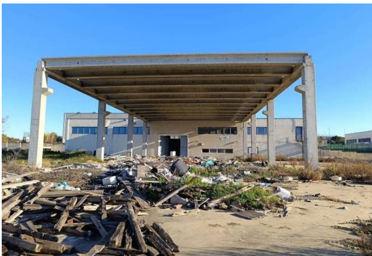
Figg. 1-2 Via A. Molinari (già V. Vigne Turci) - P.Ila 640 Il fabbricato \approx 45 \times 18 m la tettoia \approx 30 \times 18 m e l'area pertinenziale da SudOvest
