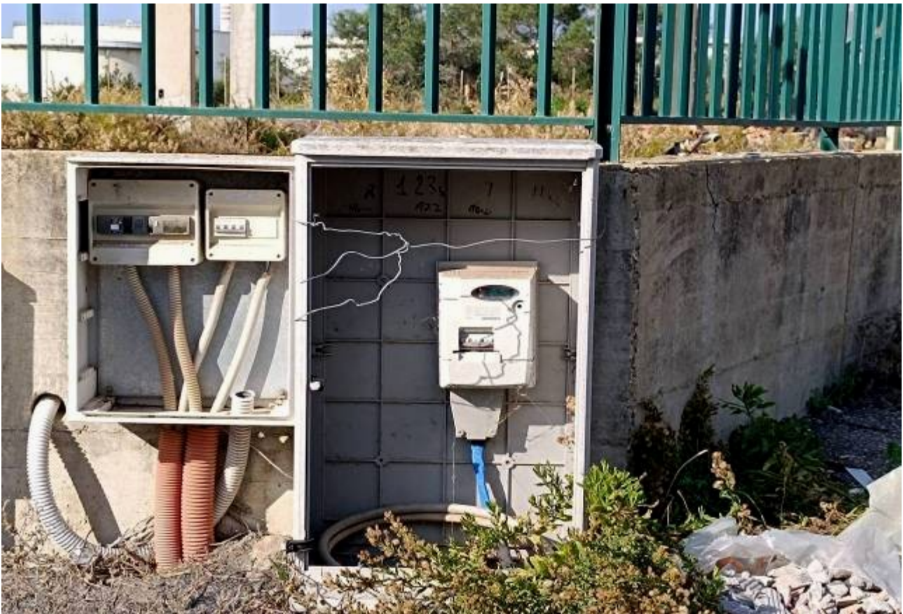
Figg.67-68 Via A. Molinari (già Via Vigne Turci) Civitavecchia (RM) Fg. 13 P.Ila 640 Sub. 1 - Il fabbricato industriale: cancello carrabile su strada e contatore di utenza elettrica
