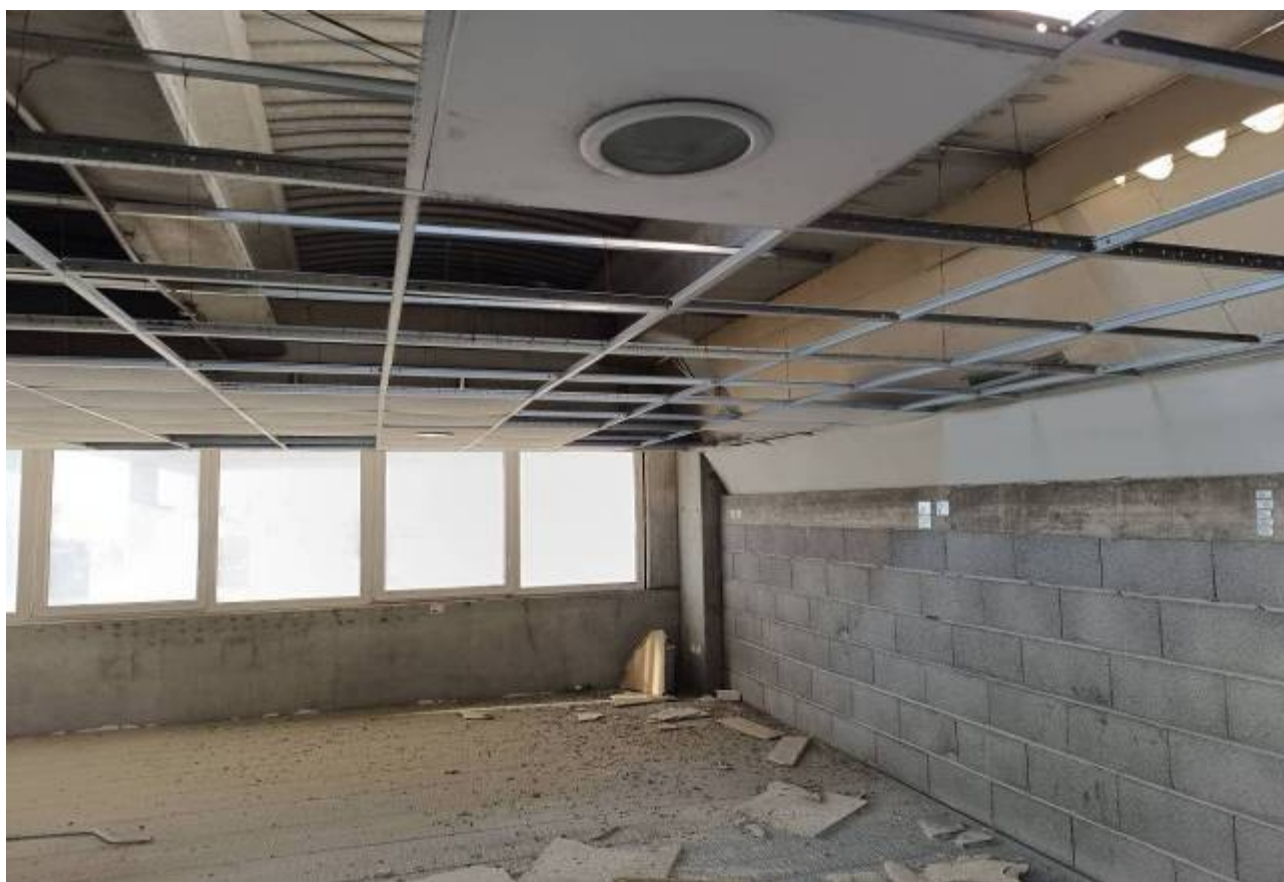
Figg.46-47 Via A. Molinari (già Via Vigne Turci) Civitavecchia (RM) Fg. 13 P.Ila 640 Sub. 2 - Il fabbricato industriale: interno dell'area magazzino al P1 ad uso magazzino, in parte soppalcato, con accesso pedonale dalla scala; particolari della copertura composta da pannelli ondulati in pvc lesionati e divelti sotto l'azione degli agenti atmosferici e del controsoffitto privo di pannellature
