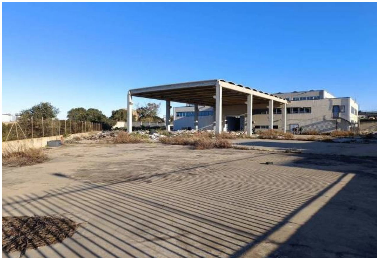
Fig. 13 P.Ila 640 Subb. 1-2 PT-1 - Esterni
