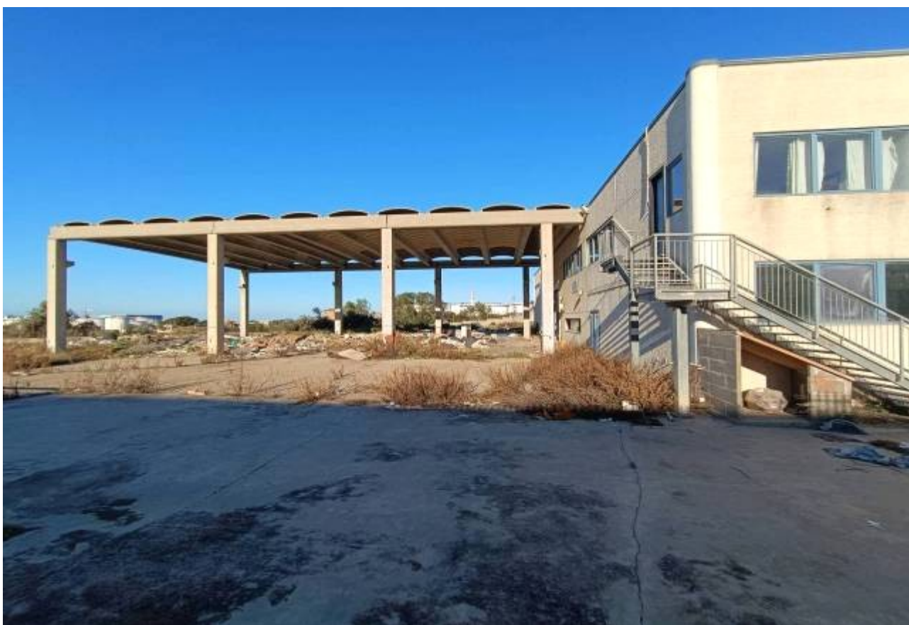
Figg. 3-4 Via A. Molinari (già Via Vigne Turci) Civitavecchia (RM) Fg. 13 P.Ila 640 - Il fabbricato industriale e l'area esterna pertinenziale (sopra) tratto di recinzione oltre cui c'è la P.Ila 639 e poi la P.Ila 573 a SudOvest; (sotto) vista da SudEst la tettoia \approx 30 \times 18 m in c.a. realizzata come struttura per carro-ponte (assente) quale ampliamento del fabbricato principale, oggetto di DIA 2006 ma non accatastata
