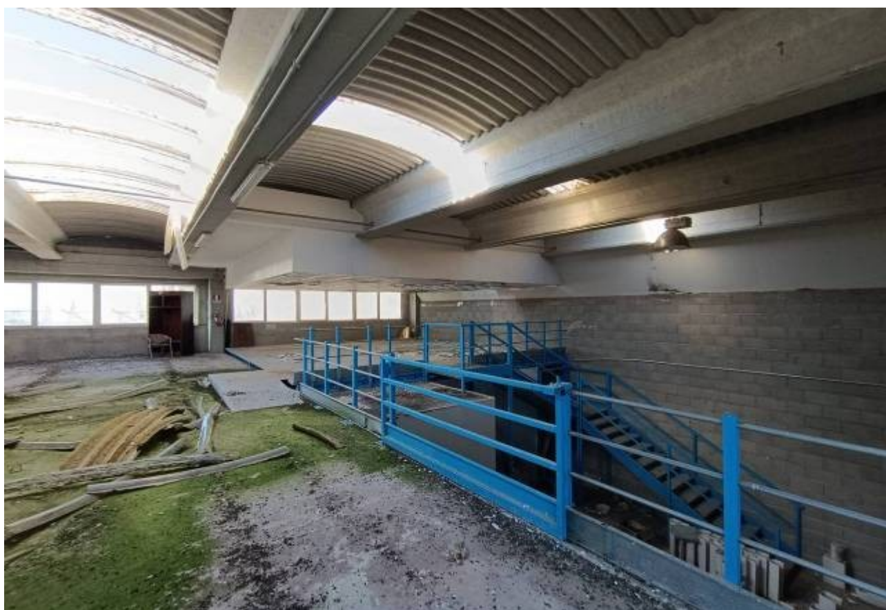
Figg.44-45 Via A. Molinari (già Via Vigne Turci) Civitavecchia (RM) Fg. 13 P.Ila 640 Sub. 2 - Il fabbricato industriale: interno dell'area magazzino al P1 ad uso magazzino, in parte soppalcato, con accesso pedonale dalla scala
