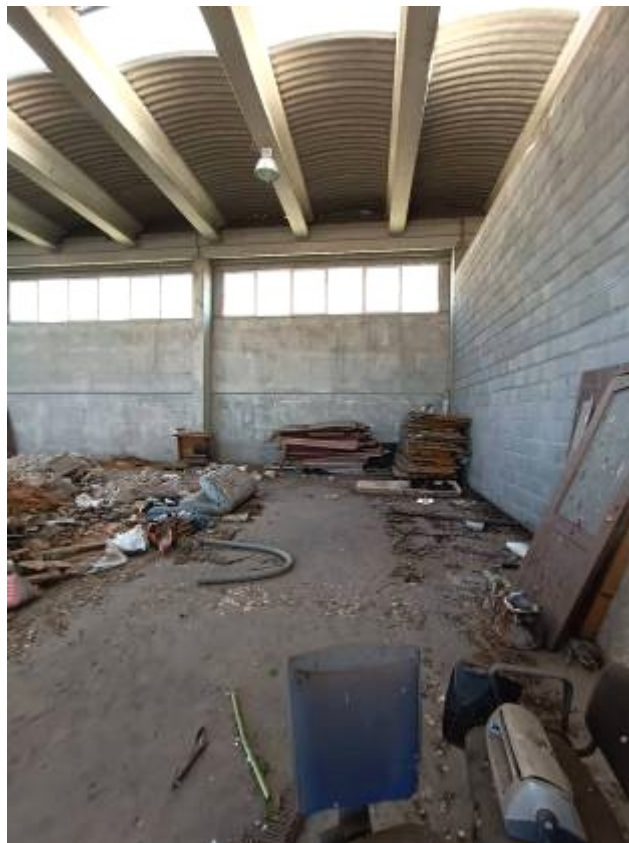
Figg.23-26 Via A. Molinari (già Via Vigne Turci) Civitavecchia (RM) Fg. 13 P.Ila 640 Sub. 2 - Il fabbricato industriale: interno dell'area principale a doppia altezza al PT, con H \approx 8,00m e campata di \approx 18,00m con travi in c.a. prefabbricate, vista da SudEst a NordOvest
