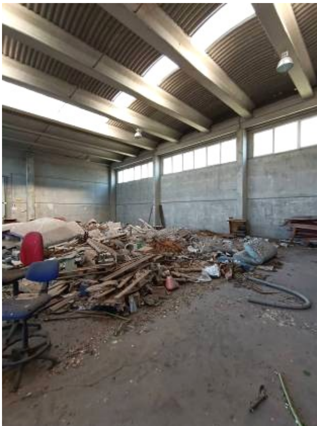
Figg.23-26 Via A. Molinari (già Via Vigne Turci) Civitavecchia (RM) Fg. 13 P.Ila 640 Sub. 2 - Il fabbricato industriale: interno dell'area principale a doppia altezza al PT, con H \approx 8,00m e campata di \approx 18,00m con travi in c.a. prefabbricate, vista da SudEst a NordOvest
