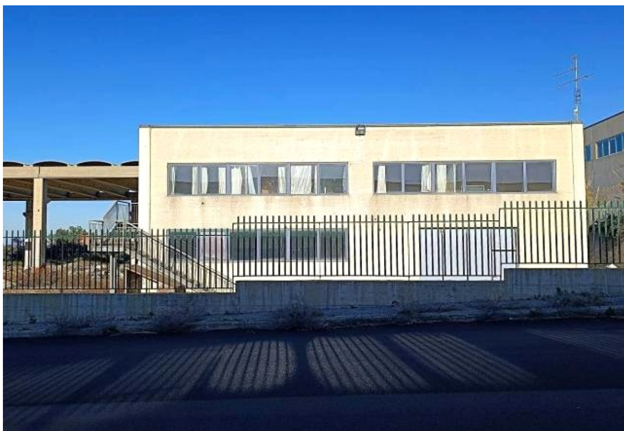
Figg. 5-6 Via A. Molinari (già Via Vigne Turci) Civitavecchia (RM) Fg. 13 P.Ila 640 - Il fabbricato industriale e l'area esterna pertinenziale (sopra) scala di accesso all'abitazione Sub. 1 P1; (sotto) vista da strada del prospetto laterale SudEst con gli affacci dell'abitazione Sub 1 P1
