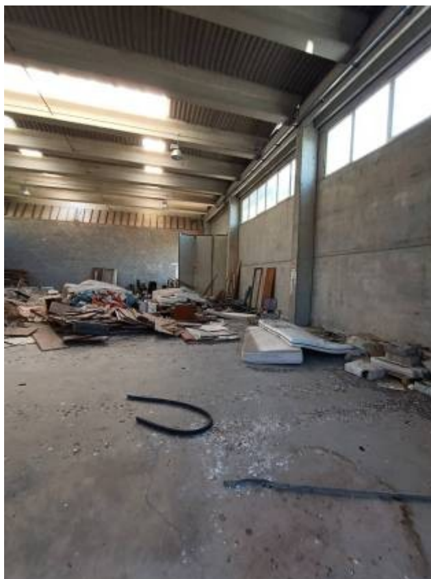
Figg.19-22 Via A. Molinari (già Via Vigne Turci) Civitavecchia (RM) Fig. 13 P.Ila 640 Sub. 2 - Il fabbricato industriale: interno dell'area principale a doppia altezza con H \approx 8,00m e campata di \approx 18,00m con travi in c.a. prefabbricate, vista da NordOvest a SudEst
