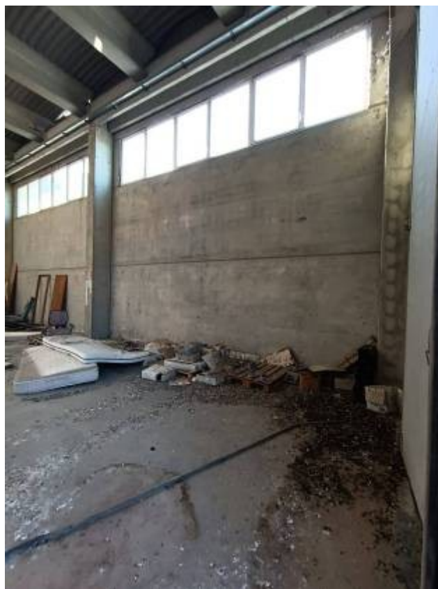
Figg.19-22 Via A. Molinari (già Via Vigne Turci) Civitavecchia (RM) Fig. 13 P.Ila 640 Sub. 2 - Il fabbricato industriale: interno dell'area principale a doppia altezza con H \approx 8,00m e campata di \approx 18,00m con travi in c.a. prefabbricate, vista da NordOvest a SudEst
