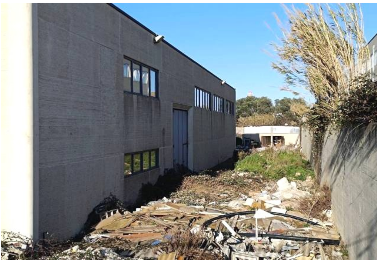
Figg. 7-8 Via A. Molinari (già Via Vigne Turci) Civitavecchia (RM) Fg. 13 P.Ila 640 - Il fabbricato industriale e l'area esterna pertinenziale (sopra) prospetto laterale SudEst; (sotto) prospetto posteriore NordEst
