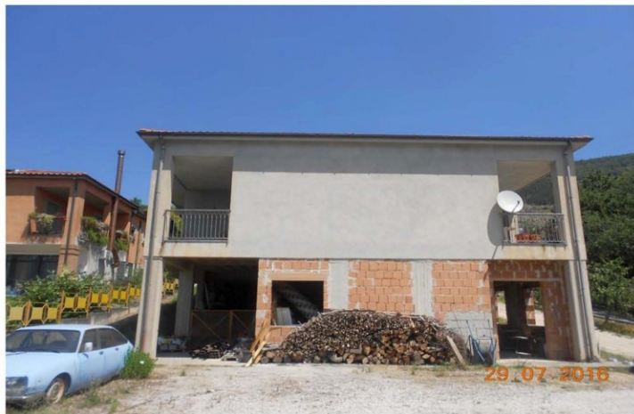
Foto n° 8 “Prospetto Sud Ingresso Seminterrato”
