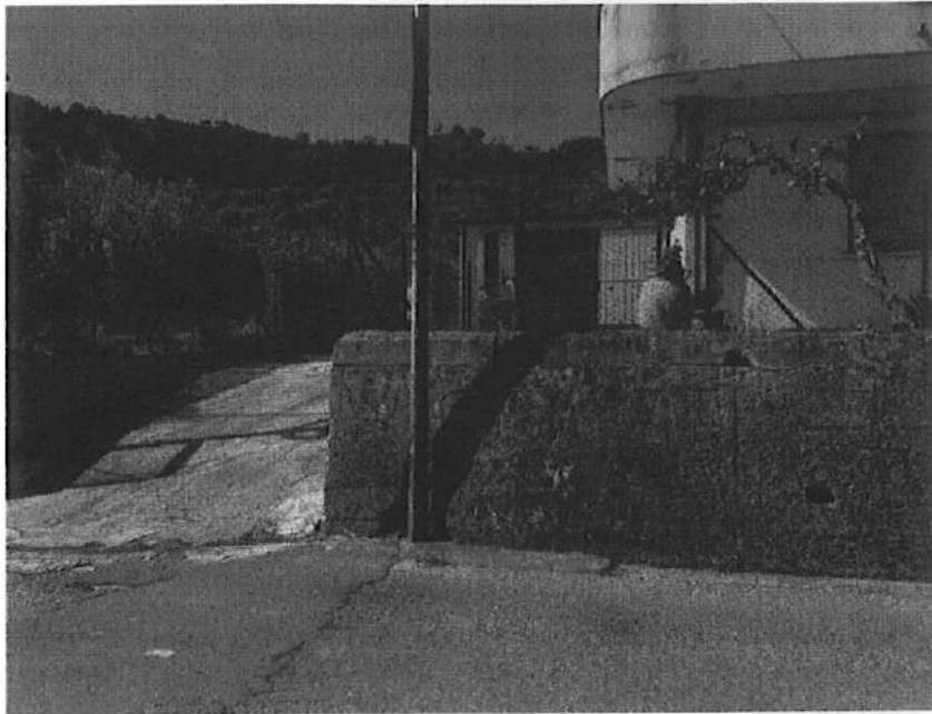
Particolare fotografico immobile a PT – Rampa di accesso all'immobile dalla strada
