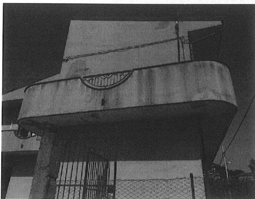
Particolare fotografico immobile a PT – Ingresso
