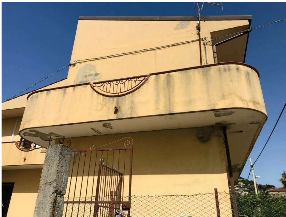
Particolare fotografico immobile a PT – Ingresso
