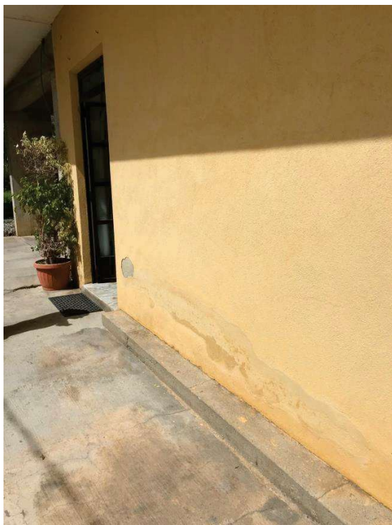
Particolare fotografico immobile a PT – Ingresso
