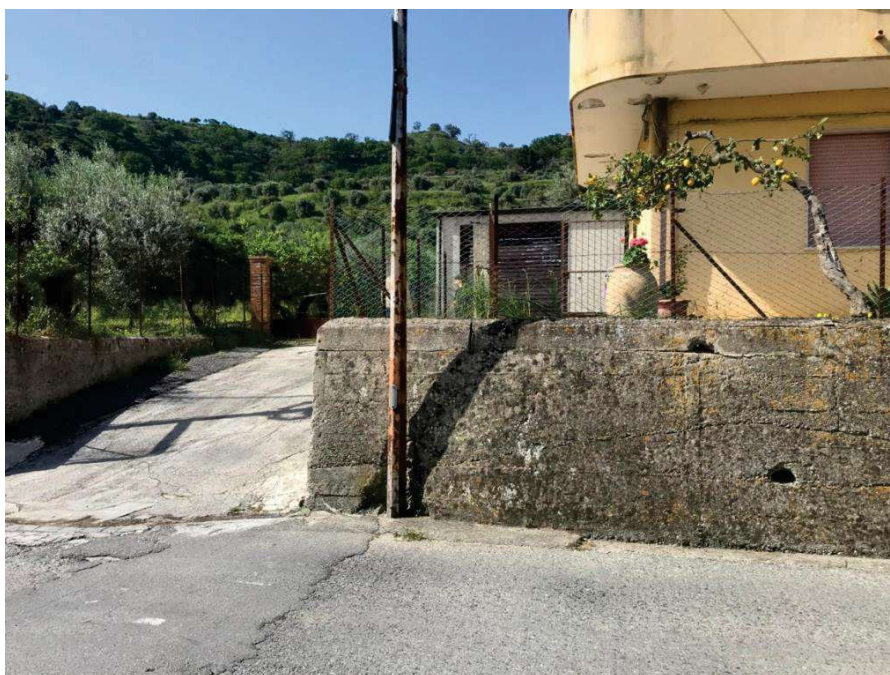
Particolare fotografico immobile a PT – Rampa di accesso all'immobile dalla strada
