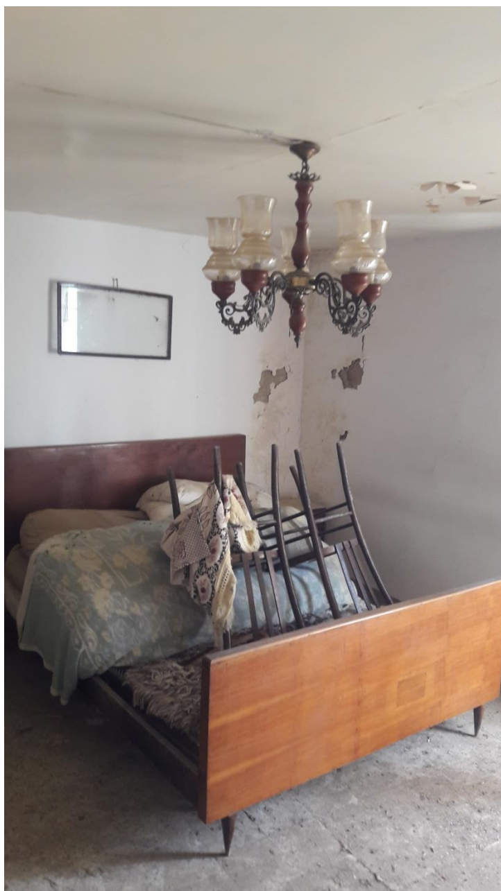
FOTO N. 8 – INTERNO PIANO PRIMO
