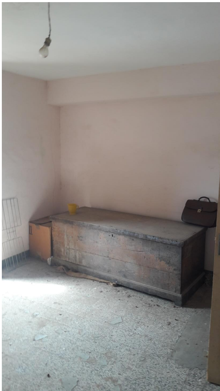
FOTO N. 13 – ALTRO ANGOLO CAMERA A PIANO SECONDO
