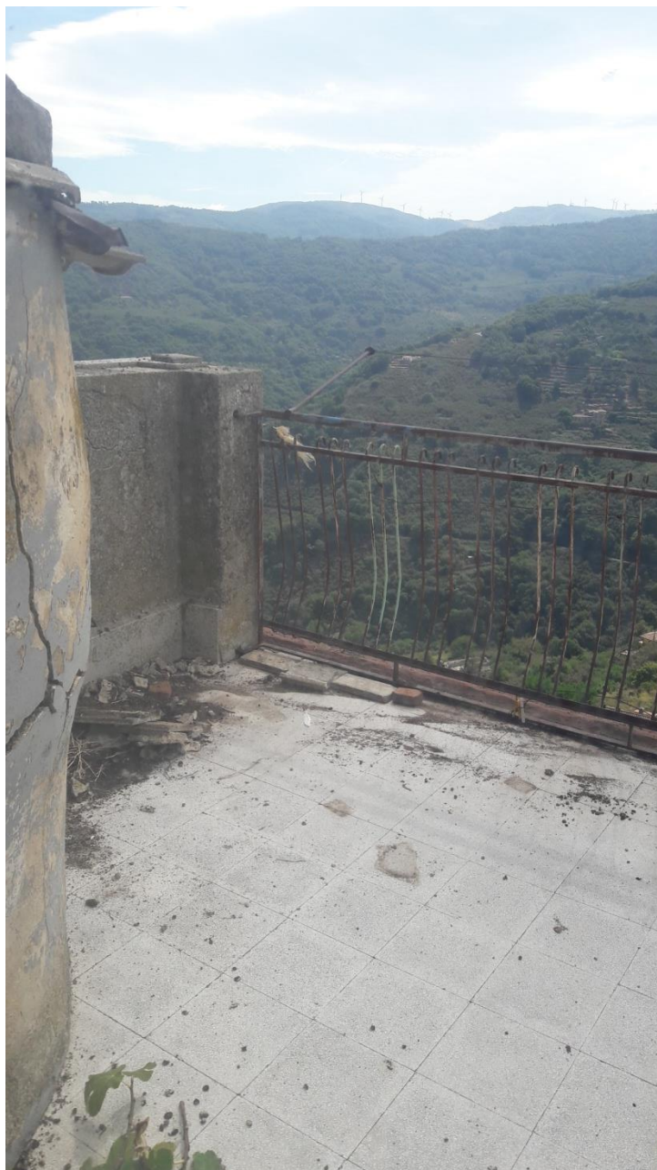
FOTO N. 20 – PARTICOLARE TERRAZZO A PIANO QUARTO
