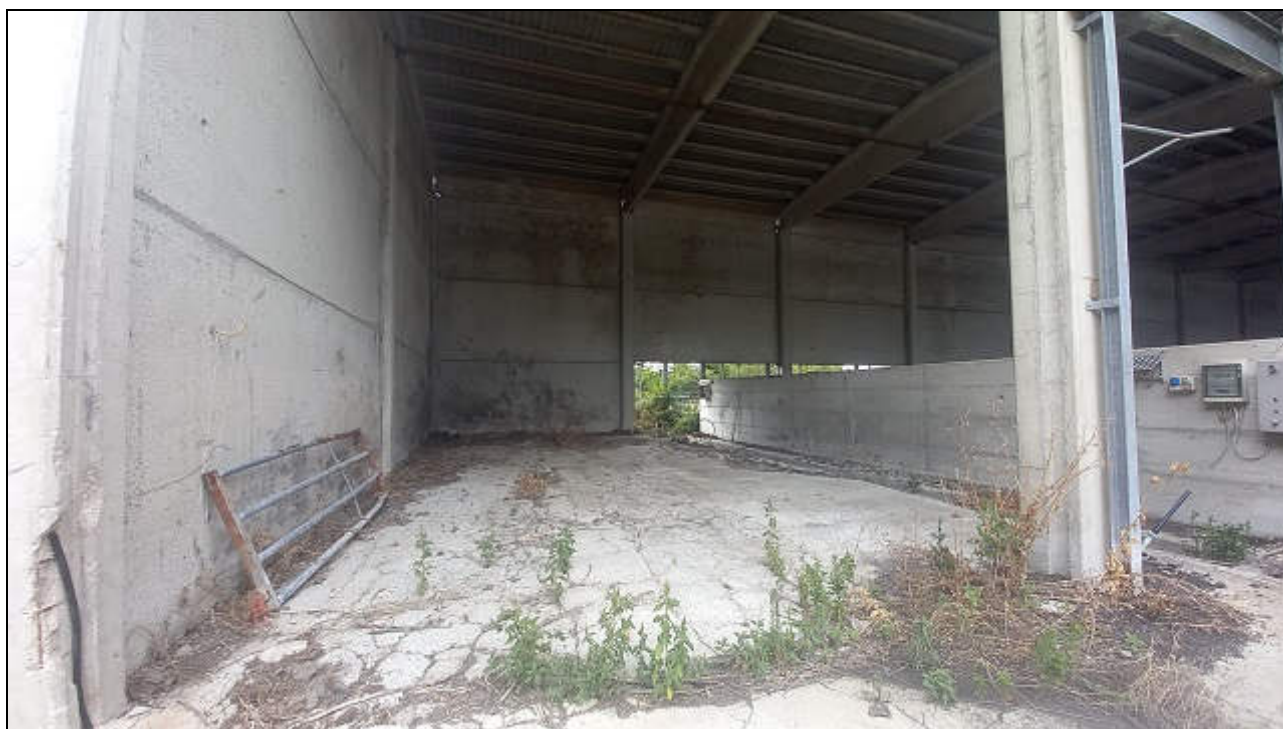
Foto 30: Stalla (Deposito), porzione in c.a. - Interno
