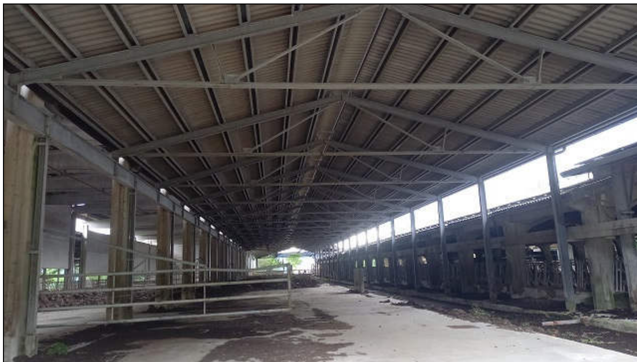
Foto 32: Stalla, porzione a struttura metallica – Interno
