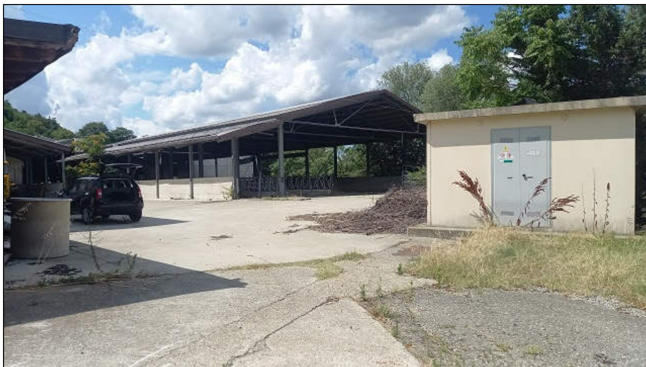
Foto 19: Ingresso con corte comune, stalla e cabina elettrica
