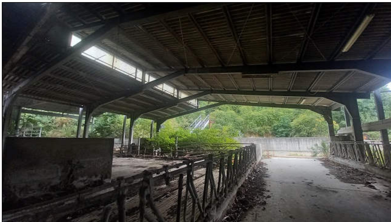
Foto 31: Stalla, porzione in c.a. - Interno
