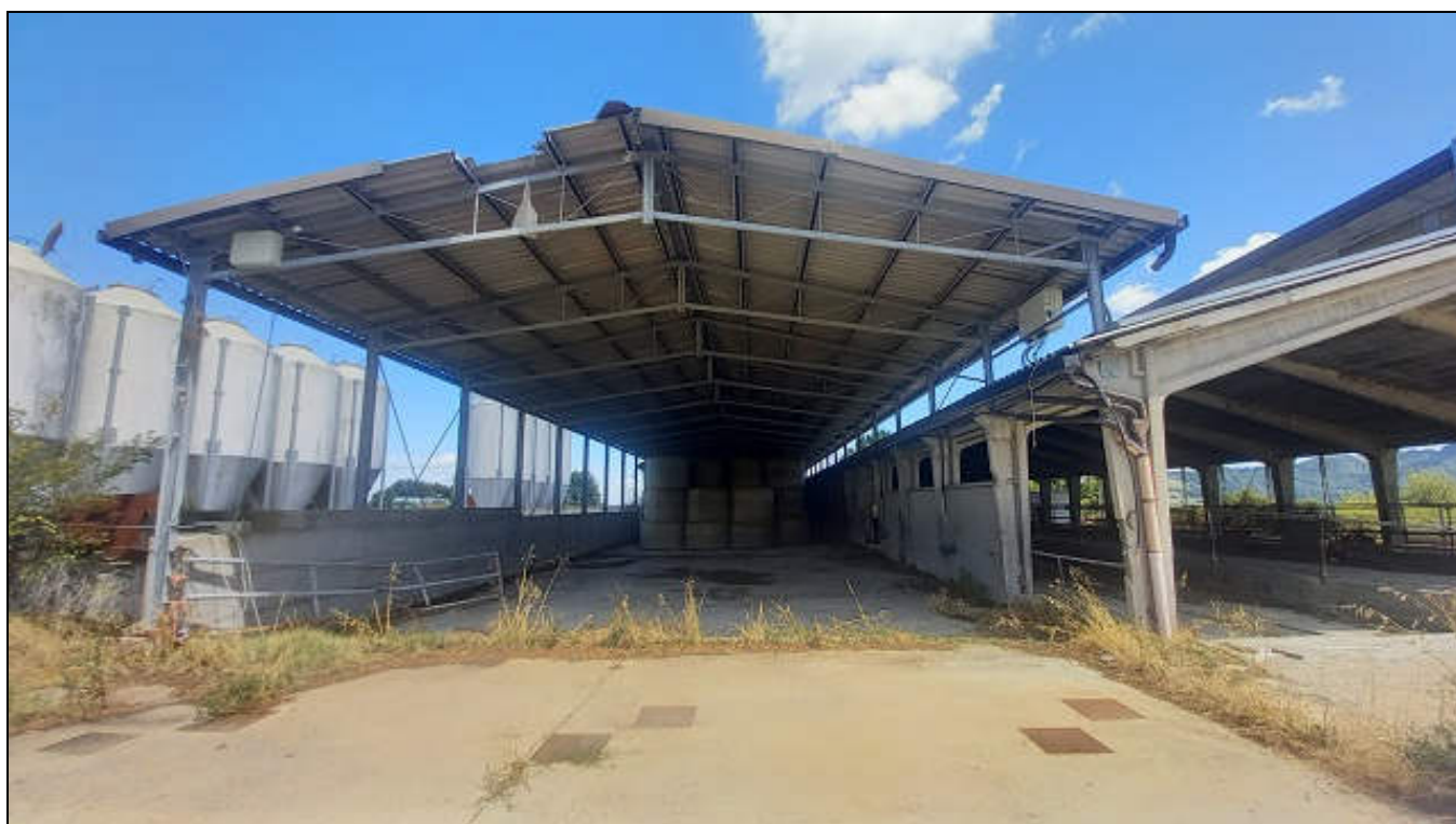
Foto 4: Prospetto Sud della Stalla e concimaia (Foglio 60 map.160 sub. 3) con area cortiliva esclusiva
