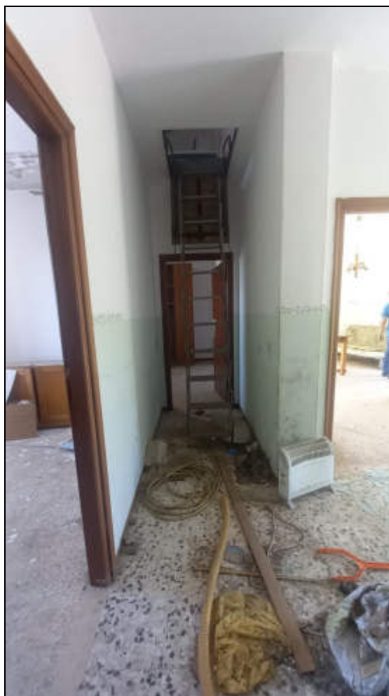
Foto 47: Appartamento (P.2° sub. 7) – Accesso al Sottotetto con botola e scala retrattile
