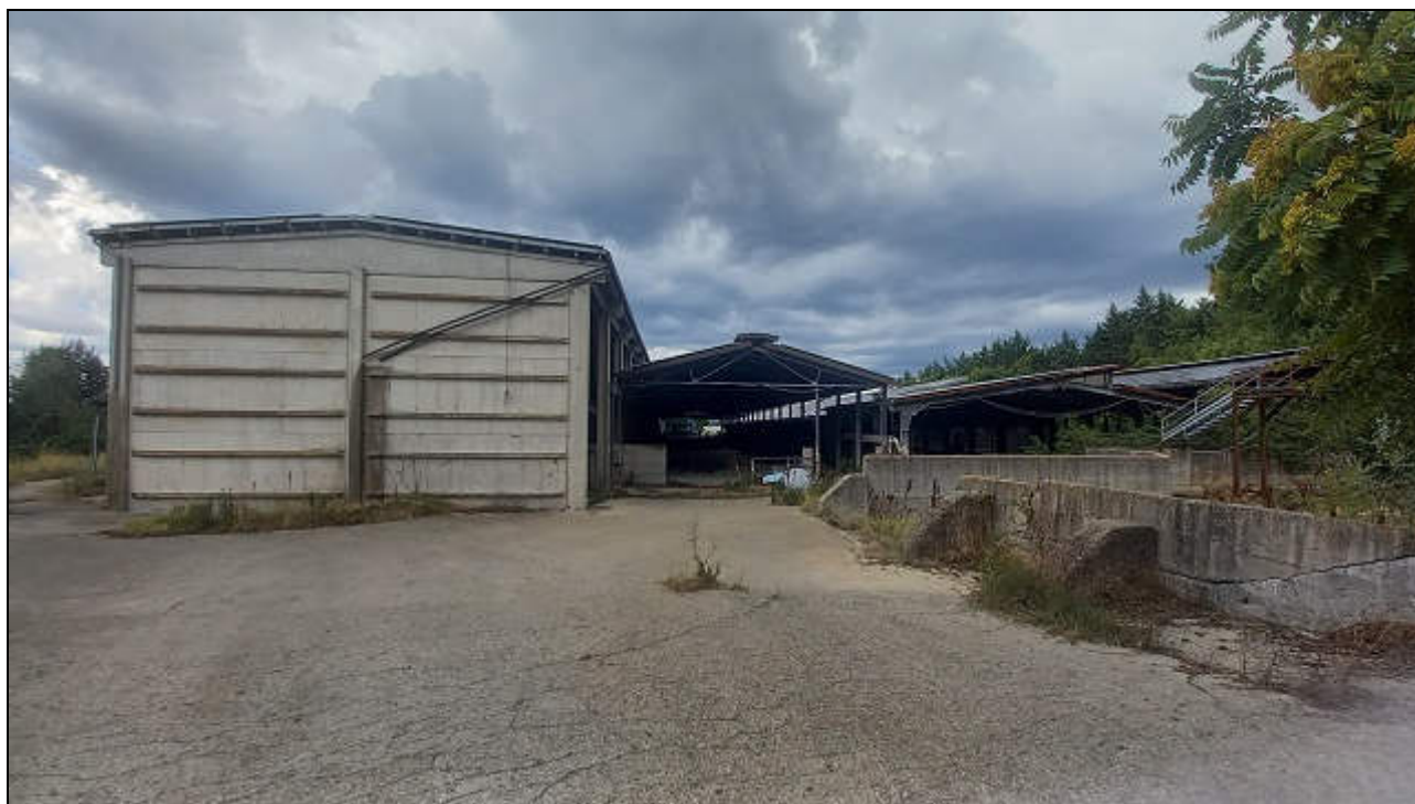
Foto 28: Prospetto Ovest della Stalla (Deposito), porzione in c.a.
