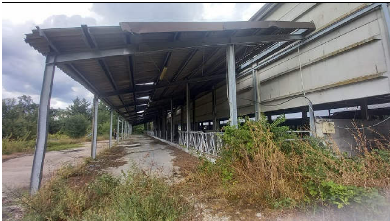
Foto 29: Prospetto Ovest della Stalla, Tettoia metallica
