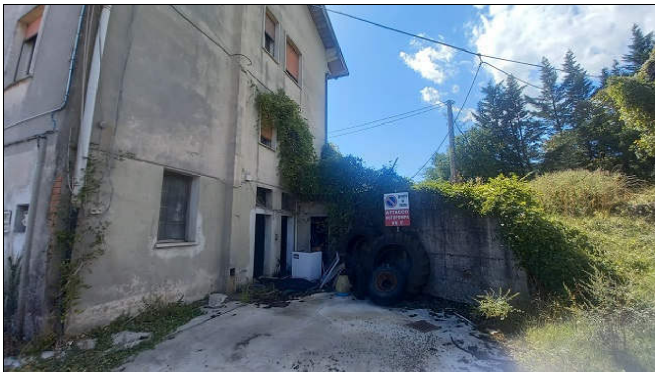
Foto 39: Prospetti laterale Ovest e muro controterra
