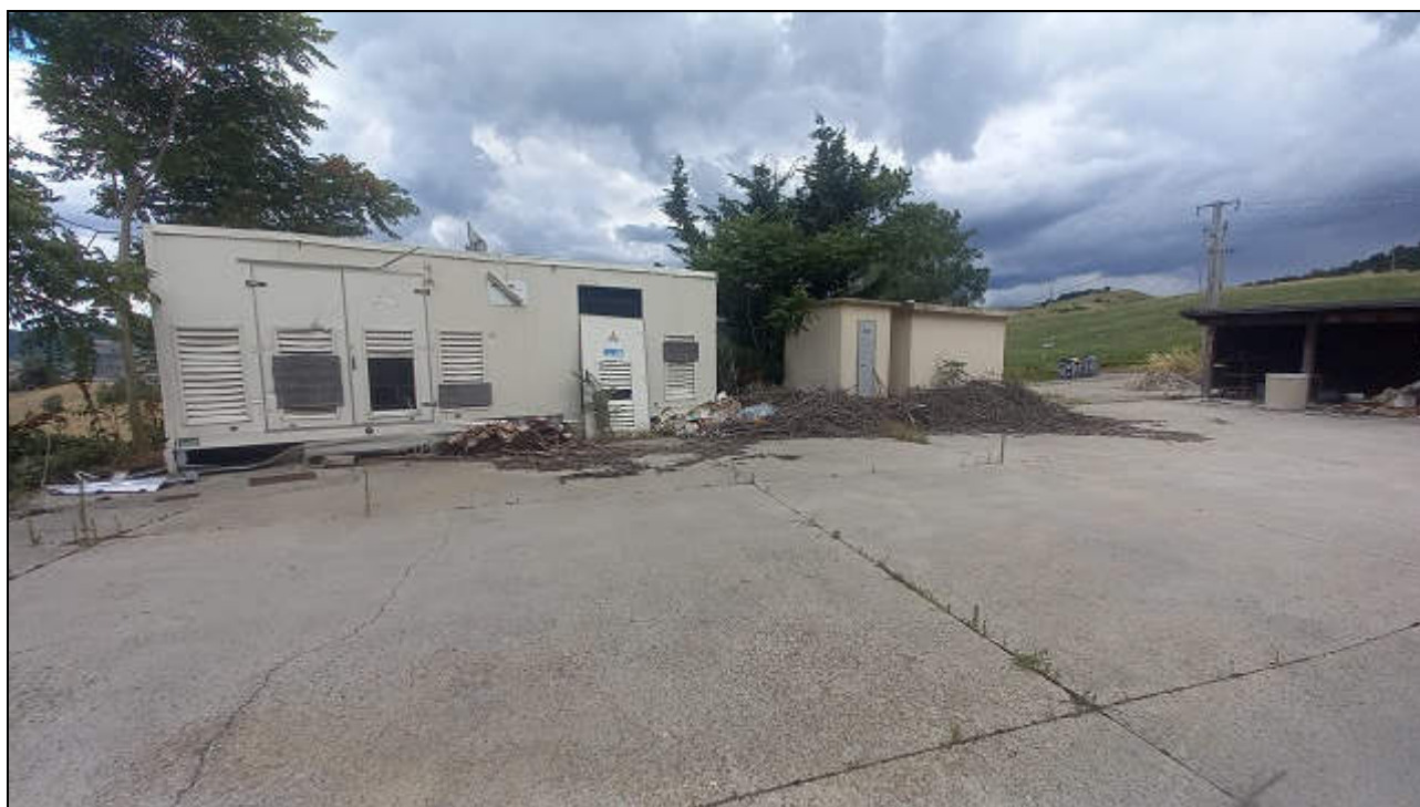
Foto 34: locali tecnici (P.T.), particella 221 parte sub 11 e cabina elettrica (P.T.), particella 221 sub 12
