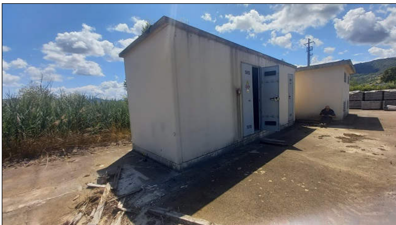
Foto 12: Locale tecnico (foglio 60 particella 160 parte sub. 4) e Cabina elettrica (sub. 5)
