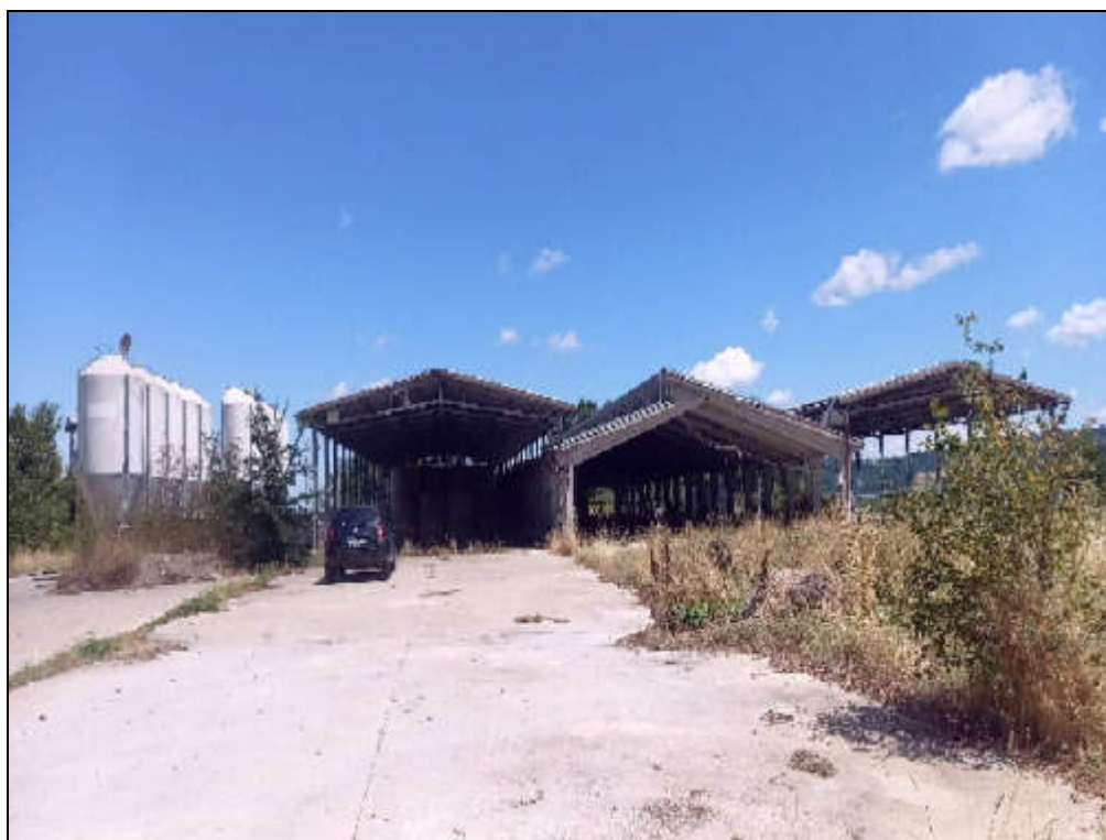
Foto 2: Vista dall'accesso della stalla e della concimaia con area cortiliva esclusiva
