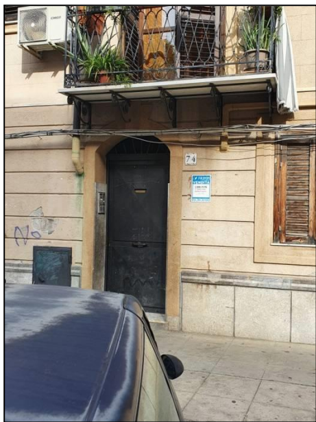
Foto 3 – ingresso da via Brancaccio n. 74
