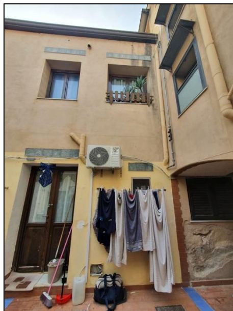
Foto 7 –ingresso all'unità immobiliare
