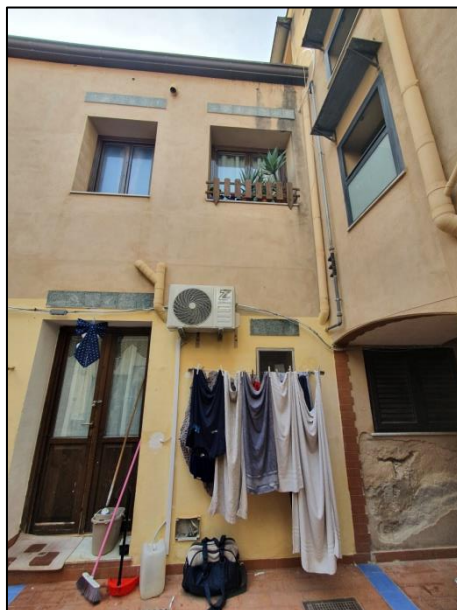
Foto 7 –ingresso all'unità immobiliare
