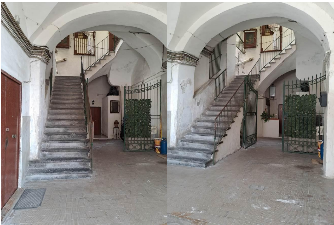
Foto n° 3 Zona ingresso Fabbricato - Androne.
