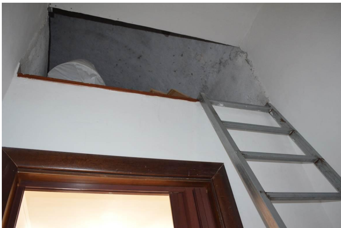
Foto n° 21 Ripostiglio e mezzanino
