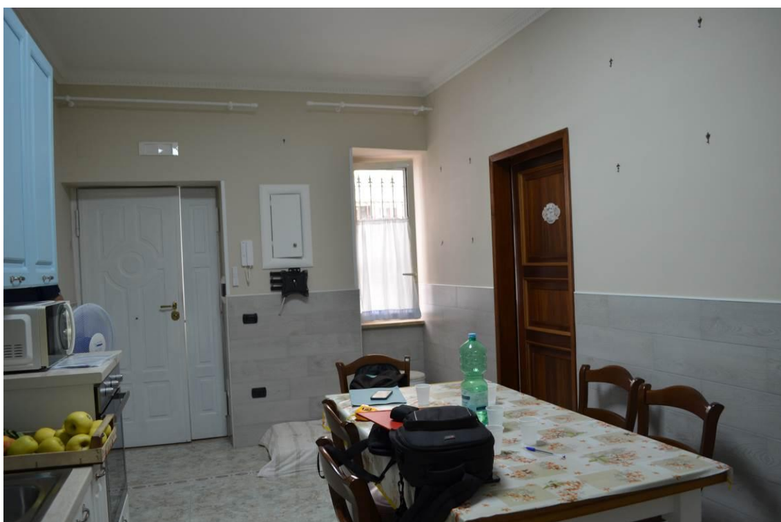
Foto n° 7 Zona ingresso e Cucina.
