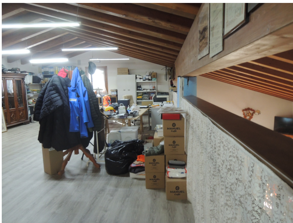
Foto 8 – soppalco su sala ristorante p.1
