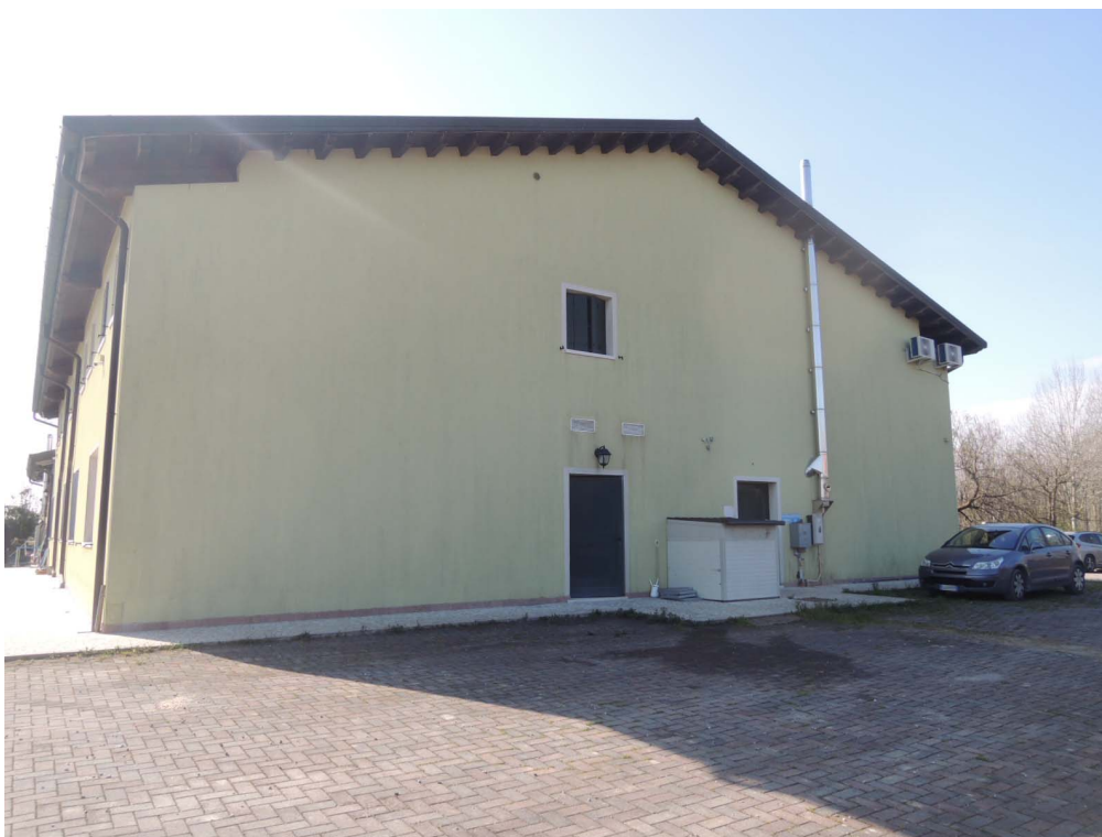
Foto 4 - veduta esterna dell'immobile e dello scoperto circostante
