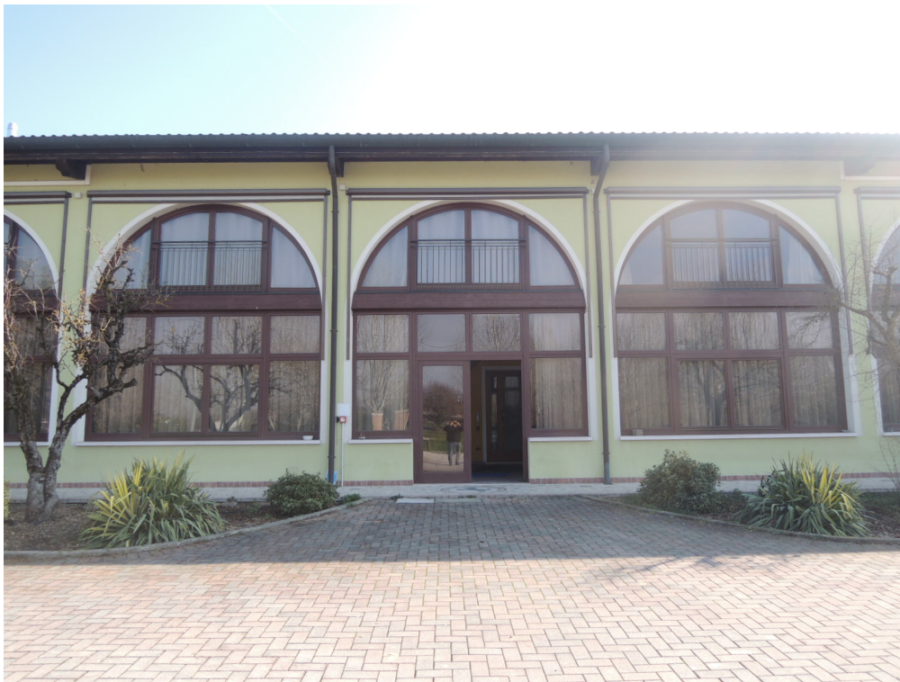
Foto 1 - veduta esterna dell'immobile
