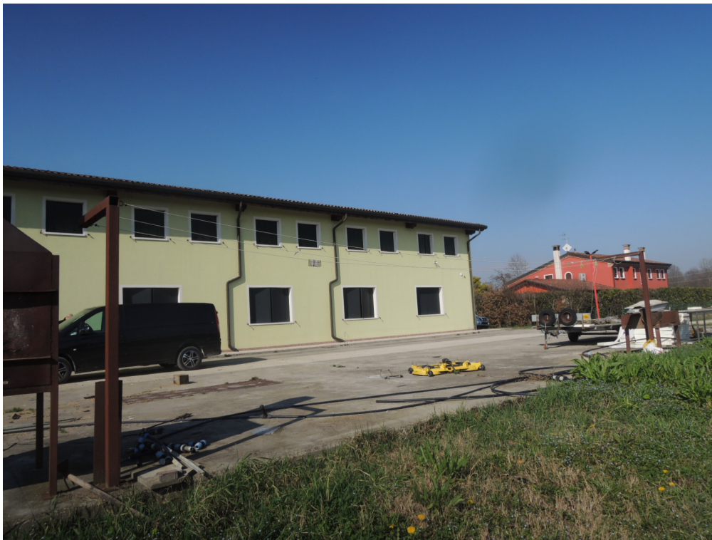
Foto 5 – veduta esterna dell’immobile e dello scoperto circostante
