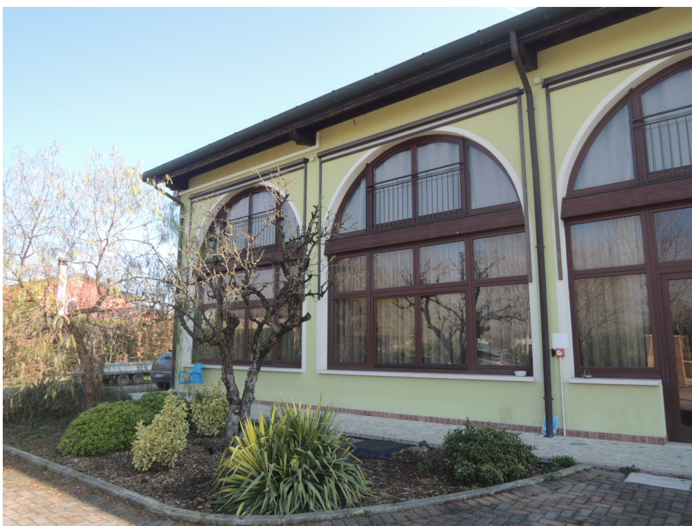
Foto 2 - veduta esterna dell'immobile
