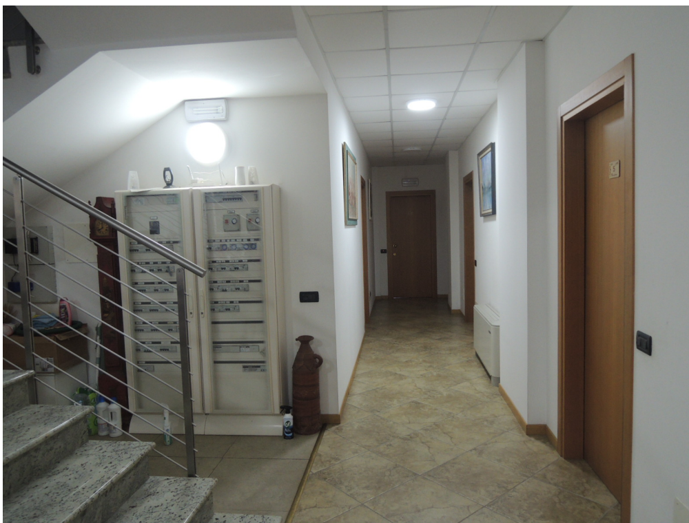
Foto 11 – ingresso zona albergo p.t.
