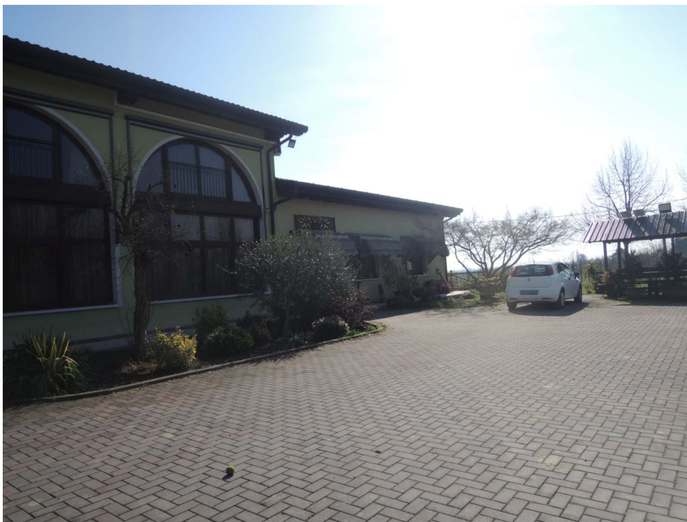
Foto 3 - veduta esterna dell'immobile e dello scoperto circostante
