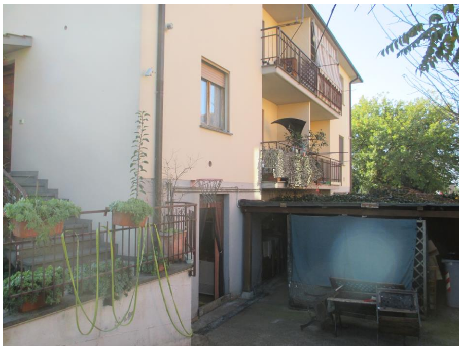
Foto n.18: Particolare della tettoia in legno autorizzata. Sulla sinistra è visibile l'ingresso ai locali del seminterrato.
