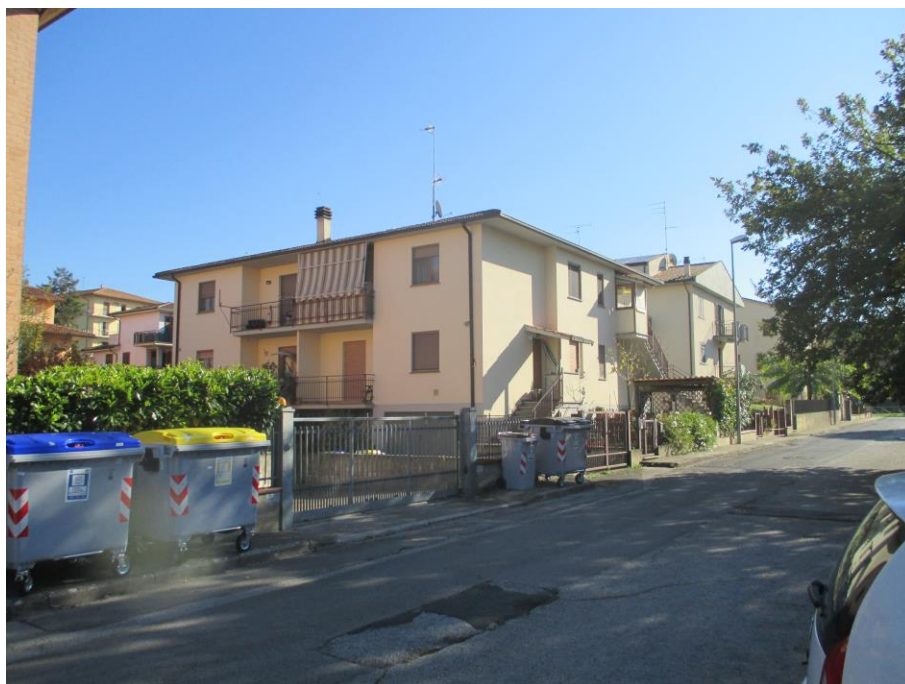
Foto n. 1: Veduta panoramica dell'intero fabbricato in via Aldo Moro n.10 cui appartengono i beni pignorati.
