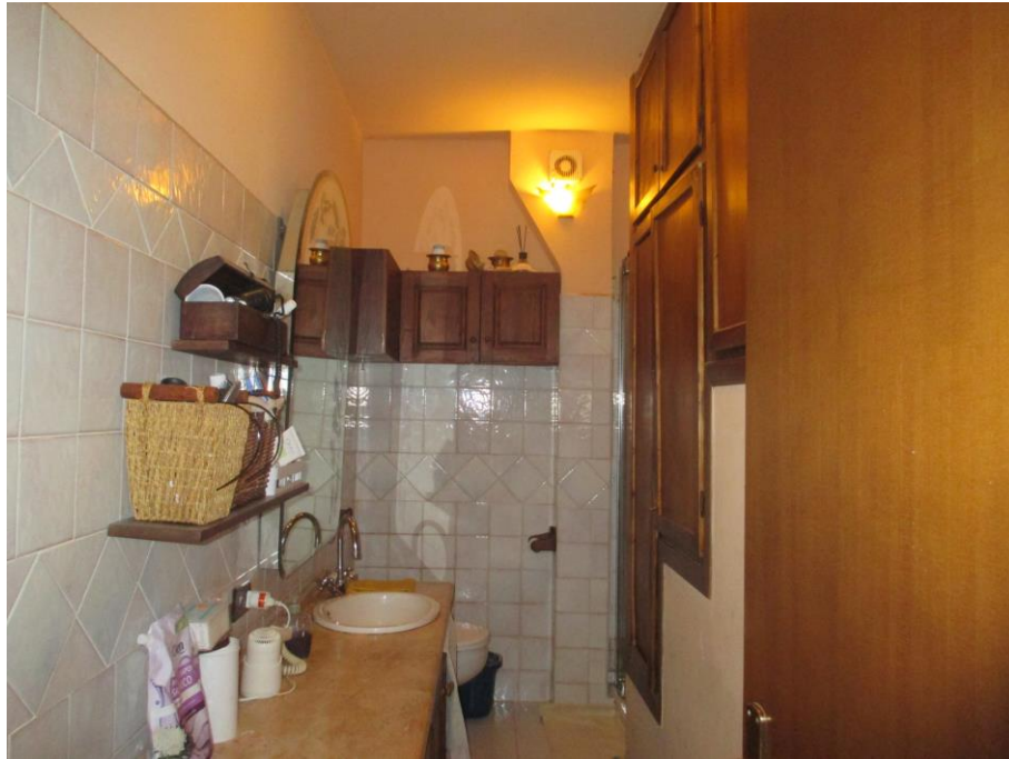
Foto n.13: Particolare del secondo bagno dotato di doccia, con pareti rivestite con mattonelle di ceramica, privo di illuminazione diretta e con aereatore meccanico.
