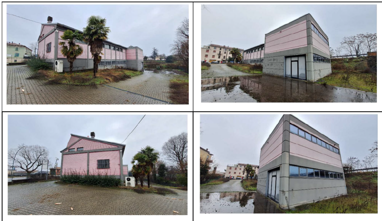
Figura 7: riprese fotografiche eseguite esternamente alla struttura
