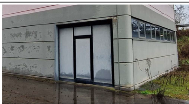
Figura 13: vista dall'esterno del portone carraio
