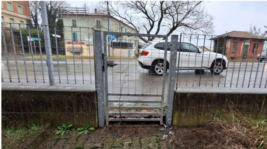
Figura 10: ingresso pedonale che affaccia su via Europa
