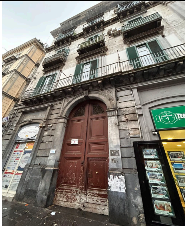
FOTO 2 Accesso all'edificio dal civ. 151 di Via C. Rosaroll
