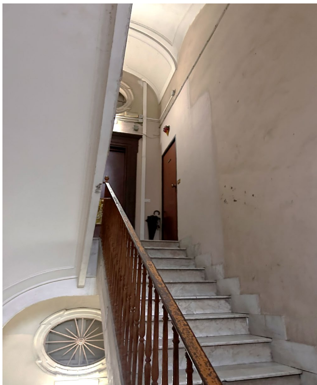
FOTO 5 Vano scala - Portoncino d'ingresso all'u.i. al P.3° int.7
