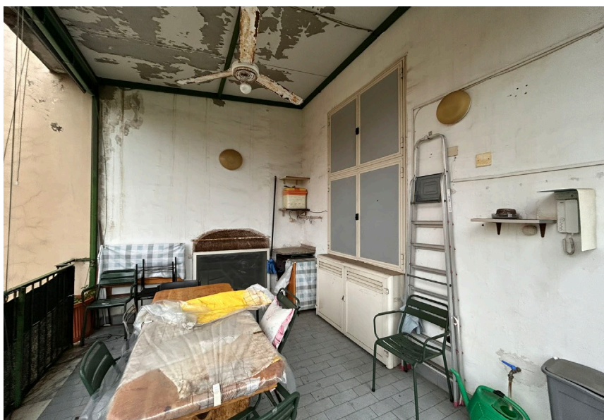
FOTO 20 Appartamento P.3° int.7 - SUB 13: terrazzo in ampliamento su preesistente balcone
