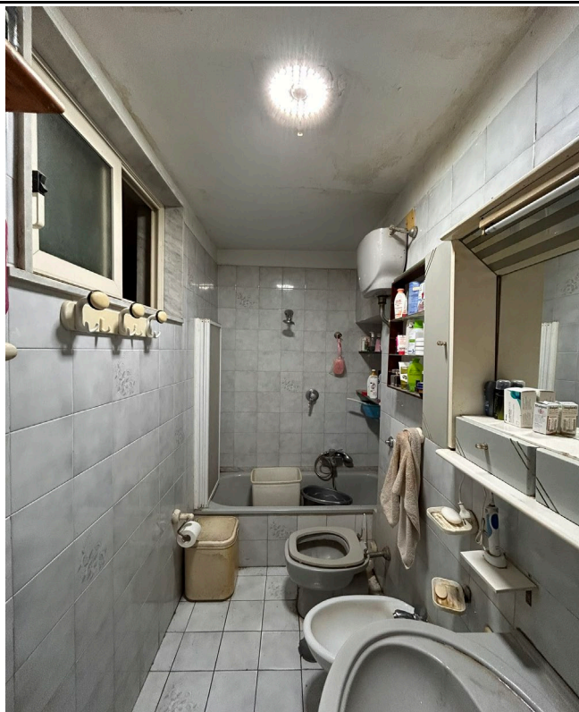
FOTO 12 Appartamento P.3° int.7 - SUB 13: bagno n°1
