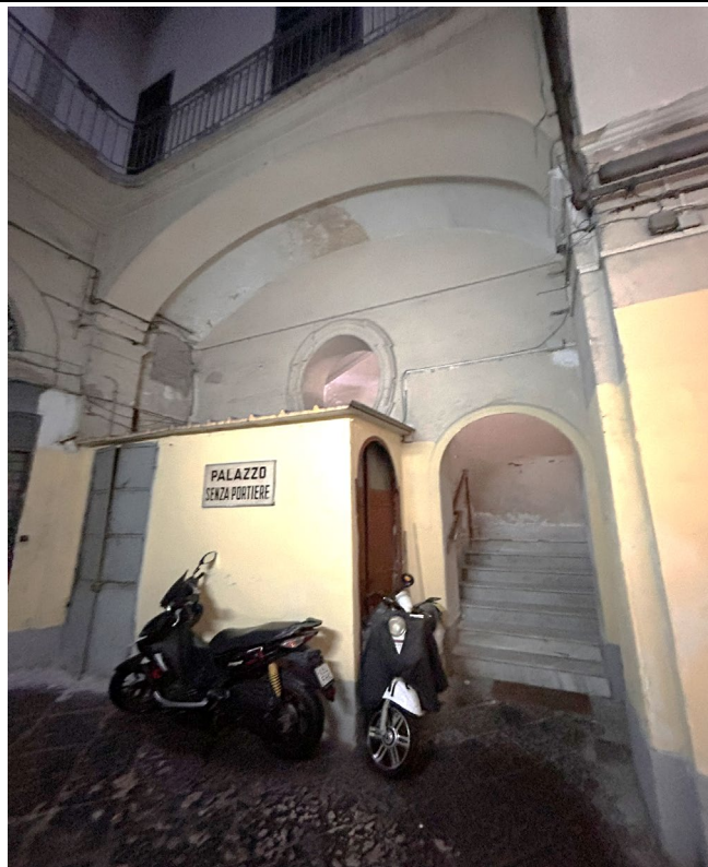
FOTO 4 Corte del fabbricato e vano scala
