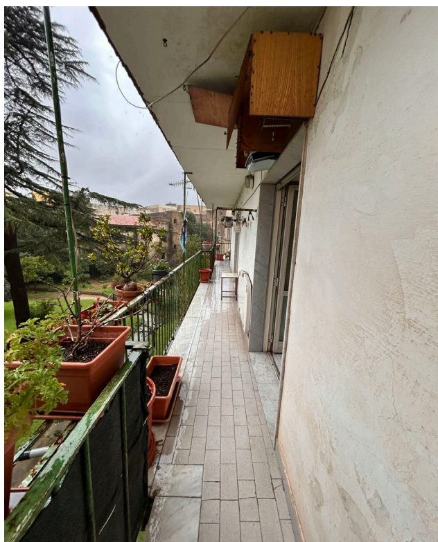
FOTO 19 Appartamento P.3° int.7 - SUB 13: balcone
