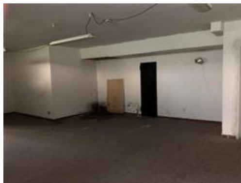
vista interna con porta da chiudere
