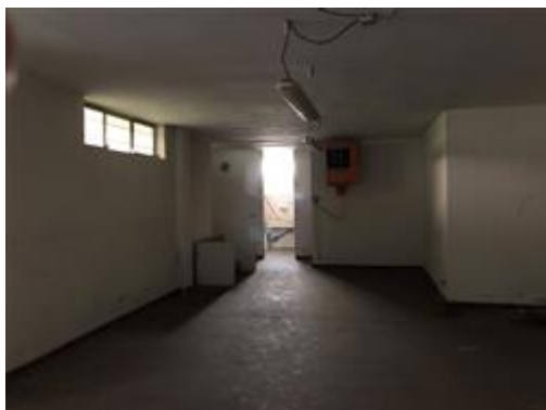
vista interna verso bagno
