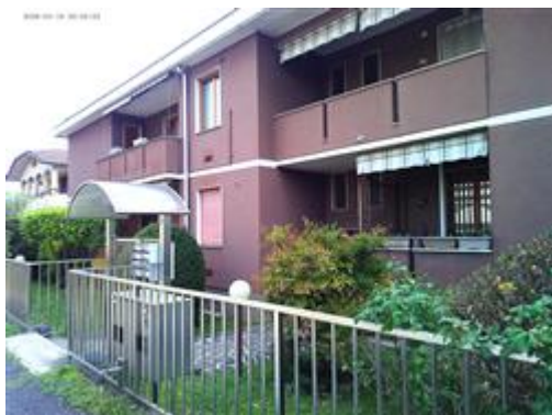
vista edificio esterna
