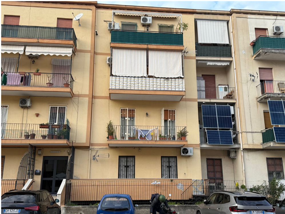
Foto n. 1 – L'edificio visto dalla via Cammarano
