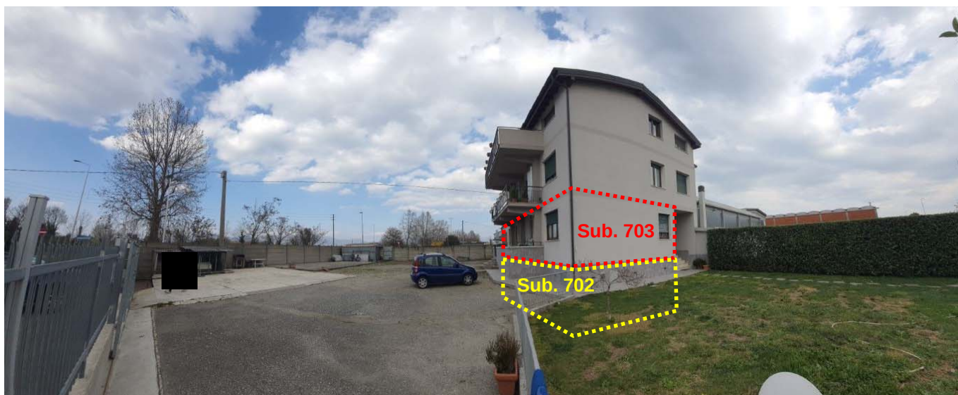
RILIEVO ESTERNO – Foto 5.
