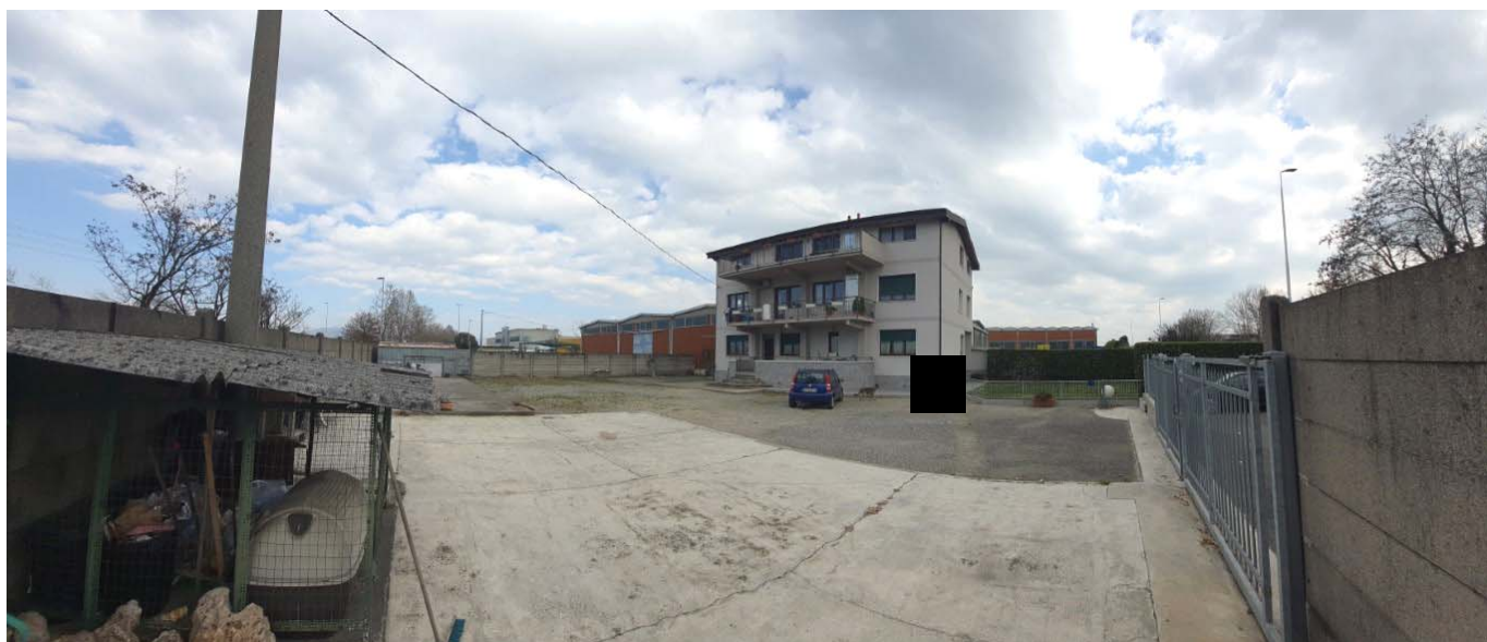
RILIEVO ESTERNO – Foto 2.
