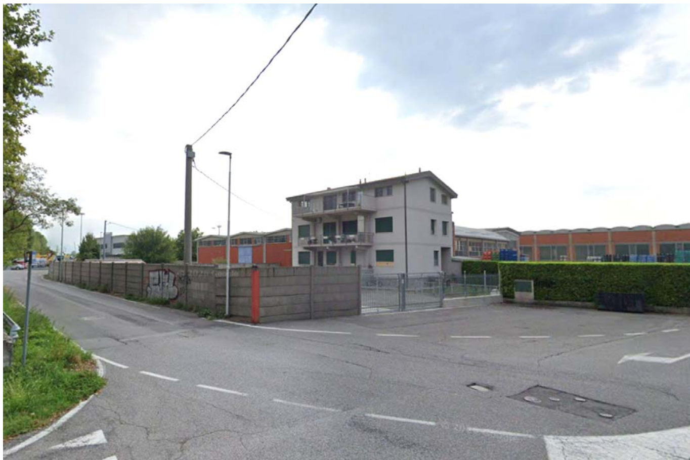
RILIEVO ESTERNO – Foto 1.
