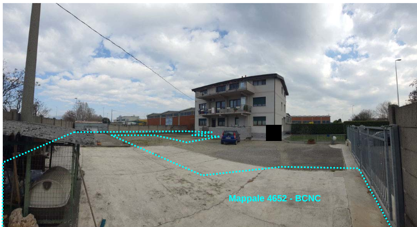
RILIEVO ESTERNO – Foto 6.
