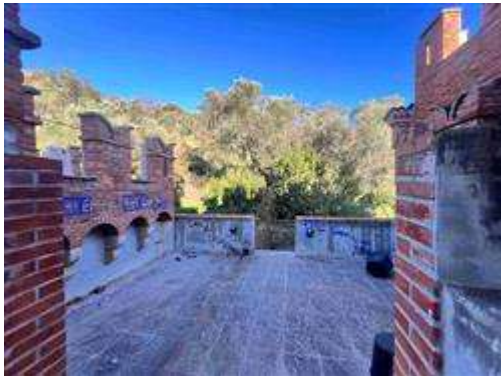
Castello Vuillermin Piano 2 L 47 Terrazzo - Pdc2022 - Appartamento 8 Terrazzo A
