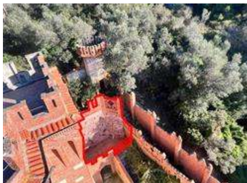
Castello di Vuillermin - Piano 0 Terra-Rialzato Esterno - Pdc2022 Appartamento3 Terrazzo pertinenziale - vista dall'alto
