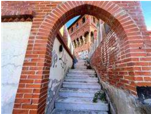
Castello Vuillermín Piano 2 L 46 Terrazzo Scalinata accesso Piano 3 - Pdc2022 Appartamento 8 Scalinata da Piano 2 Terrazzo B
