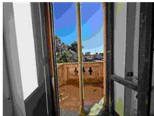
Castello di Vuillermin - Piano 1 Balcone L 42 lato sud-est Edificio - Pdc27.05.2022prot5503 ALLOGGIO6 Balcone - vista da Soggiorno
