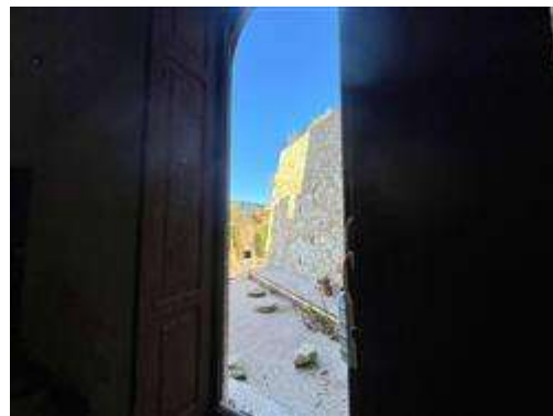
Piano-0Terra-RialzatoTerrazzo - Pdc27.05.2022prot5503 ALLOGGIO5 Terrazzo pertinenziale che da accesso a Ingresso secondario - vista dall'interno
