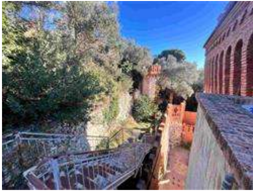
Finale Ligure via Generale Enrico Caviglia 46 Castello Vuillermin Piano 2 scala accesso secondario lato nord - Pdc2022 Appartamento 8 esterni lato nord
