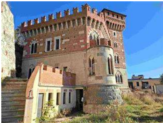
Castello di Vuillermin - Piano -1 Seminterrato Esterno - Pdc2022 Appartamento1 Giardino di pertinenza - Ingresso
