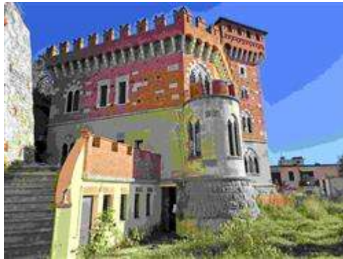
Finale Ligure via Generale Enrico Caviglia 46 Castello di Vuillermin - Fg 40 part 10 Piano0Terra-Rialzato- Esterni - Pdc2022 Appartamento5 Esterno - Scala e Terrazza di Ingresso- vista da sud-ovest
