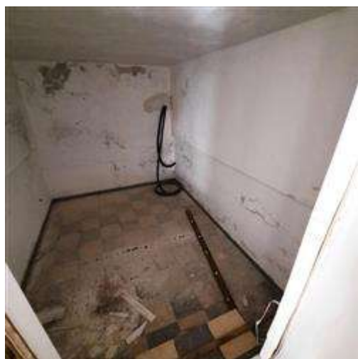
Castello di Vuillermin - Piano -1 Seminterrato Locale 12 - Pdc2022 Appartamento2 Ripostiglio
