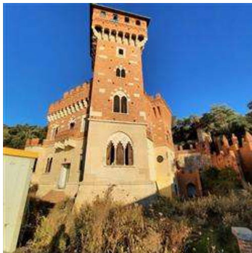
Finale Ligure via Generale Enrico Caviglia 46 Castello di Vuillermine - Fg 40 part 10 Piano0Terra-Rialzato- Esterni - Pdc2022 Appartamento4 Esterno - vista da sud
