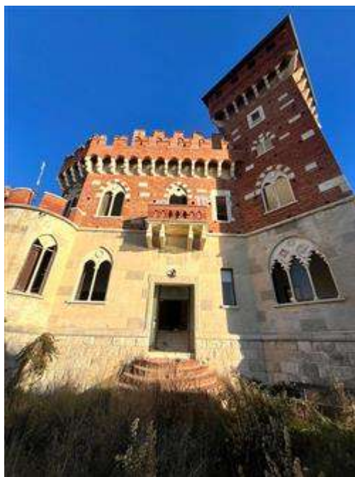
Finale Ligure via Generale Enrico Caviglia 46 Castello di Vuillermis - Fg 40 part 10 Piano1- Esterni - Pdc2022 Appartamento6 Esterno da area condominiale verso destra - vista da sud
