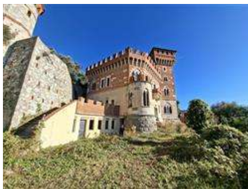
Finale Ligure via Generale Enrico Caviglia 46 Castello di Vuillermin - Fg 40 part 10 Piano1- Esterni - Pdc2022 Appartamento7 Esterno da area condominiale - vista da sud-ovest
