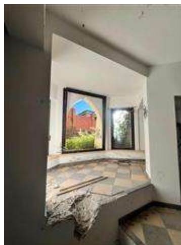
Castello di Vuillermin - Piano -1 Seminterrato Locale 3 - Pdc2022 Appartamento2 Soggiorno
