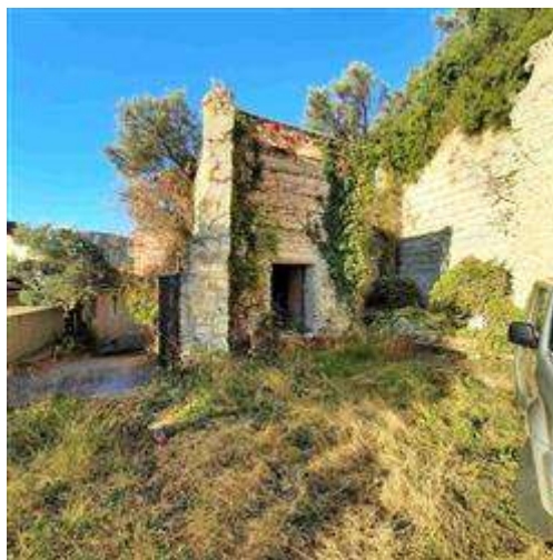
Finale Ligure via Generale Enrico Caviglia 46 Castello Vuillermín Area Esterna sud-ovest a destra muro di contenimento - Pdc2022 a destra muro e terrapieno in cui prevista Autorimessa
