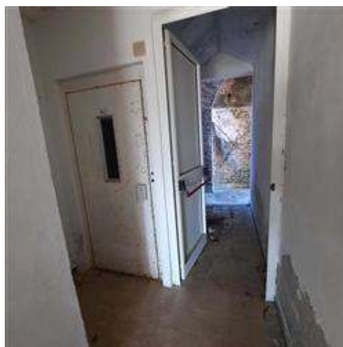
Castello di Vuillermine - Piano 0 Terra-Rialzato Locale 21 - Pdc2022 Area Condominiale Corridoio-Scala
