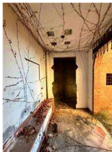
Castello di Vuillermin - Piano -1 Seminterrato Locale 9-10 - Pdc2022 Appartamento2 Vano Tecnico
