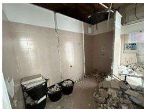
Castello di Vuillermín - Piano Terra-Rialzato Locale 22 - Pdc2022 Appartamento3 Bagno
