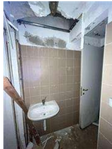
Castello di Vuillermin - Piano -1 Seminterrato Locale 6 - Pdc2022 Appartamento1 Bagno 1
