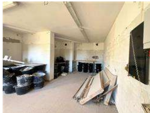
Castello di Vuillermin - Piano -1 Seminterrato Locale 2 - Pdc2022 Appartamento1 Soggiorno-Cucina
