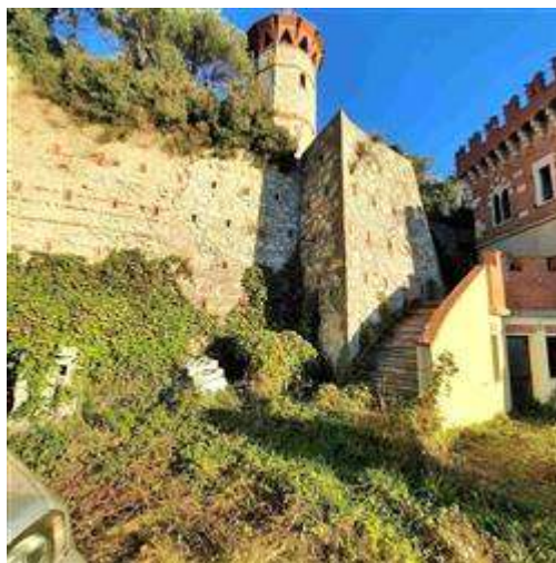
Castello Vuillermine Area Esterna sud-ovest a sinistra muro di contenimento - Pdc2022 a sinistra muro e terrapieno in cui prevista Autorimessa con sopra i Locali Pubblici
