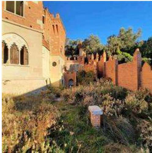
Finale Ligure via Generale Enrico Caviglia 46 Castello di Vuillermín - Fg 40 part 10 Piano -1 Seminterrato - Esterno - Pdc2022 Appartamento2 Giardino di pertinenza Ingresso - vista da area condominiale sud
