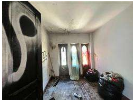
Castello di Vuillermin - Piano 2 locale 54 - Pdc2022 Appartamento 8 Bagno
