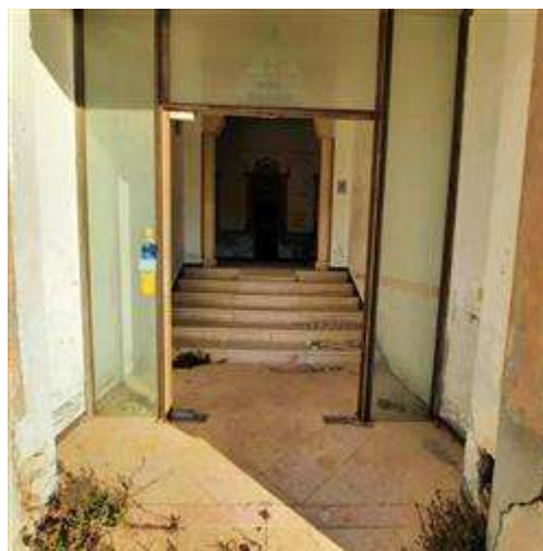
Castello di Vuillermine - Piano 0 Terra-Rialzato Locale 20 Accesso Principale - Pdc2022 Area Condominiale Accesso
