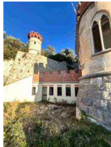
Castello di Vuillermin - Piano -1 Seminterrato Esterno - Pdc2022 Appartamento1 Giardino di pertinenza - Ingresso
