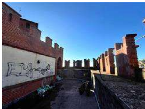
Castello Vuillermin Piano 2 L 46 Terrazzo - Pdc2022 Appartamento 8 Terrazzo B - vista verso scalinata di accesso a Piano 3 Terra
