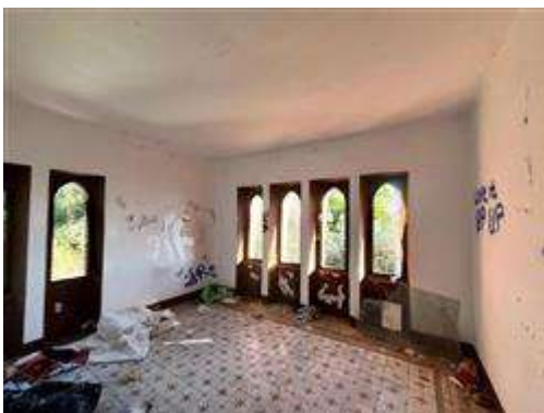
Castello di Vuillermin - Piano 2 locale 55 - Pdc2022 Appartamento 8 Camera 3
