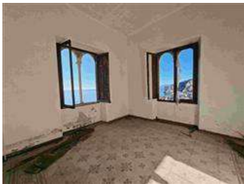
Castello di Vuillermine - Piano 1 Locale 43 - Pdc2022 Appartamento6 Soggiorno
