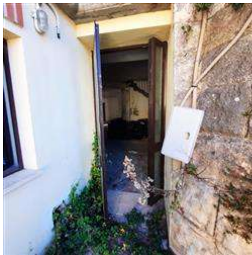
Castello di Vuillermin - Piano -1 Seminterrato Esterno Ingresso - Pcd2022 Appartamento1 Portico
