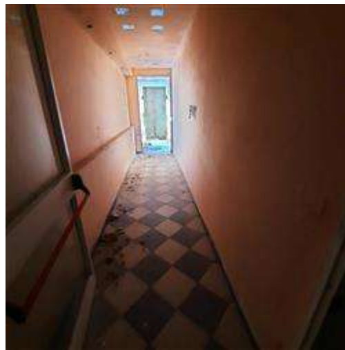
Castello di Vuillermín - Piano -1 Locale 7 - Pdc2022 Area condominiale Vano Tecnico1
