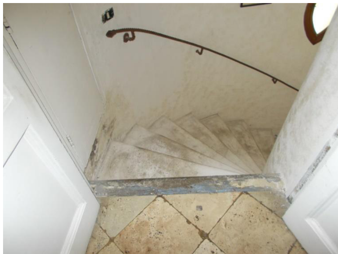
Particolare scala di arrivo al 2° piano
