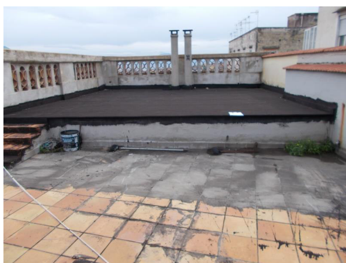
Terrazzo in copertura (3° livello)
