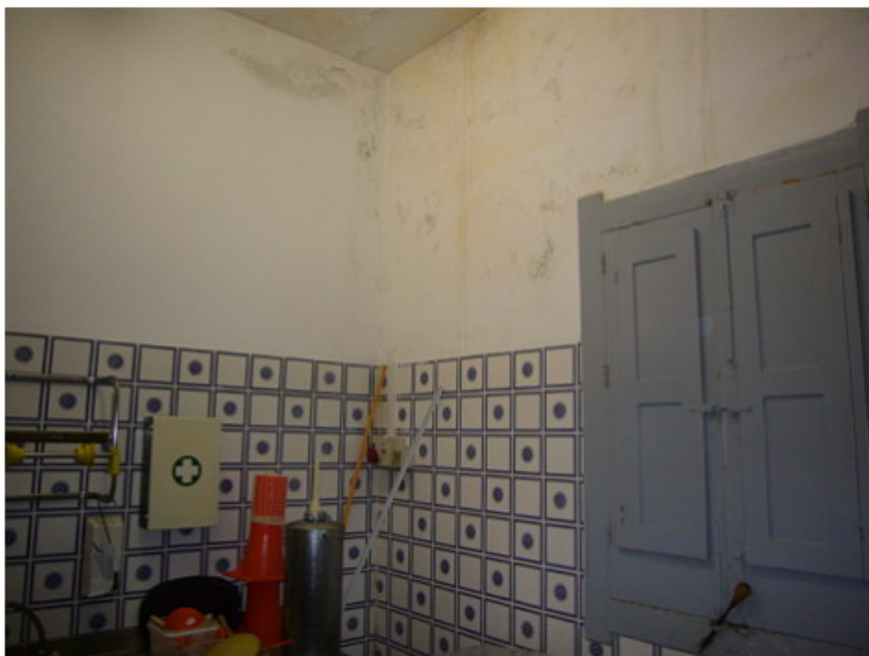
FOTO 17 LOTTO B - Locale preparazione carni.
