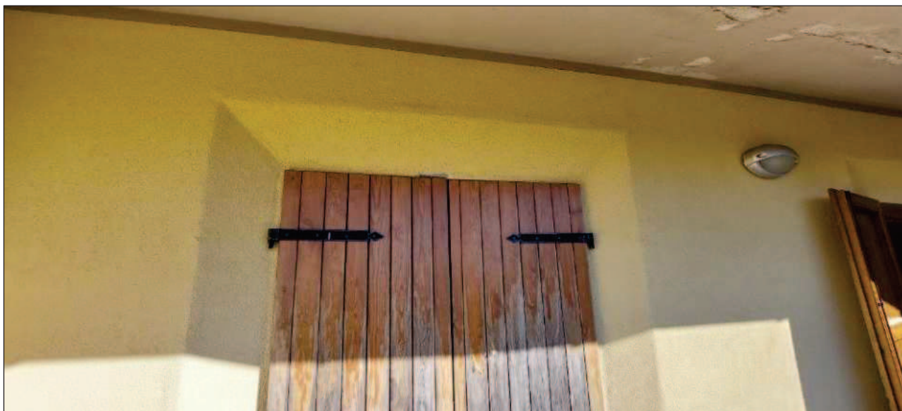
FOTO 25 – particolare della sagomatura del cappotto attorno alle aperture realizzata per consentire la movimentazione degli scuri
