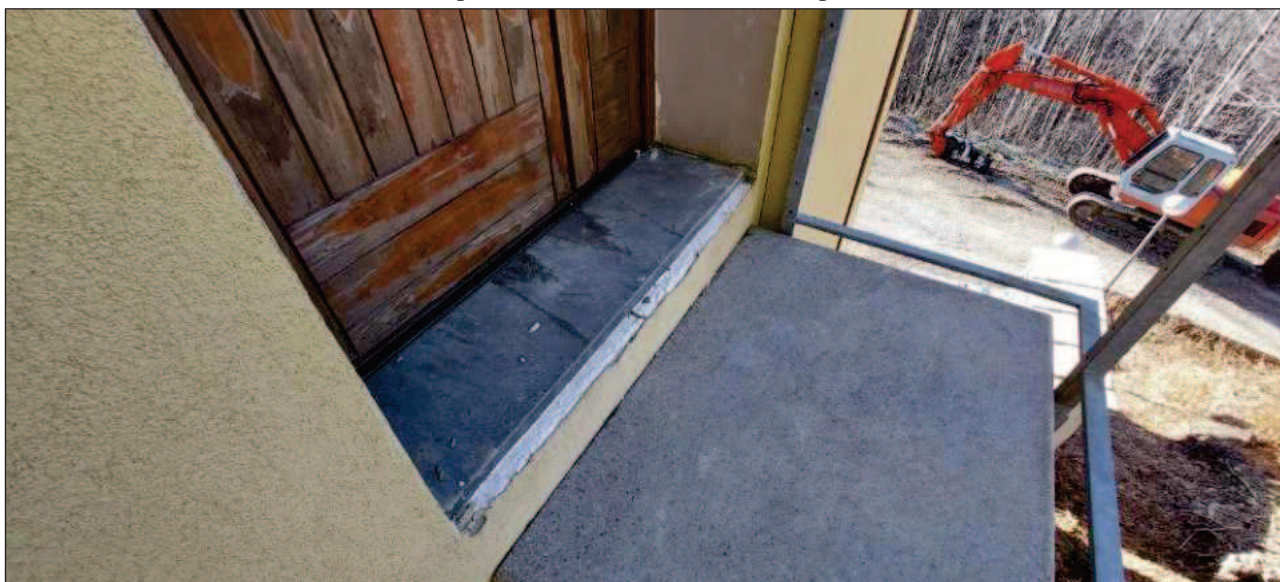
FOTO 2 – pianerottolo di accesso – particolare della soglia in pietra che non sormonta il cappotto termico
