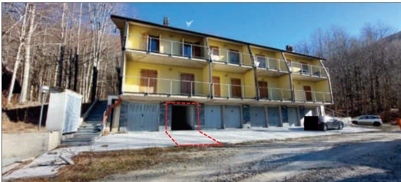
Fronte principale (Sud-Ovest)
