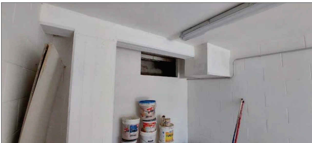
FOTO 3 – part. apertura nel muro verso scannafosso
