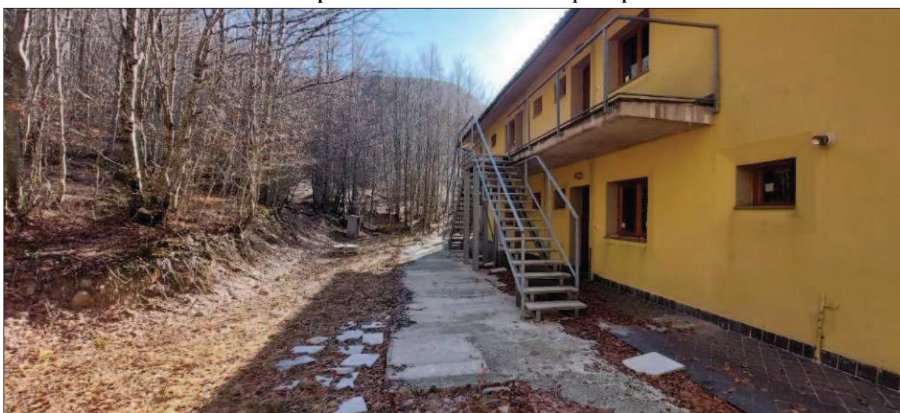
FOTO 6 - Prospetto Nord-Est (parte) del fabbricato censito al mapp. 81
