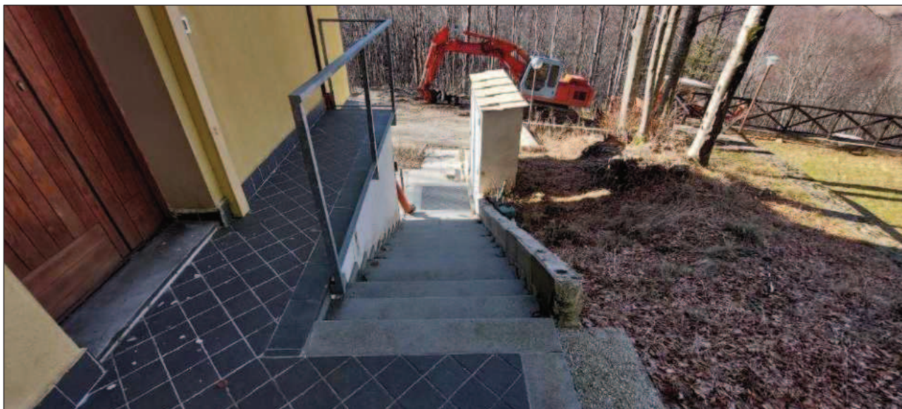
FOTO 4 - scala comune di collegamento tra piano terra e piano seminterrato
