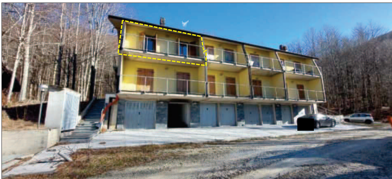
Fronte principale (Sud-Ovest)
