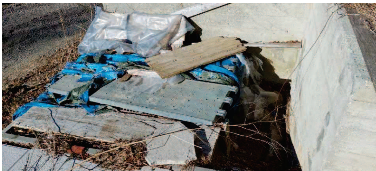
FOTO 14 – vano alloggiamento contatori acqua
