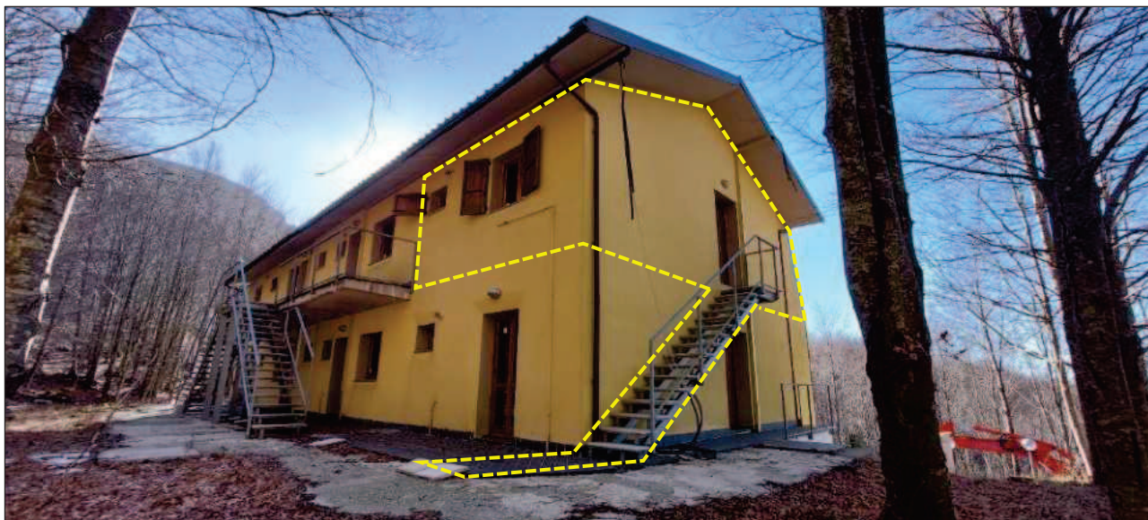
FOTO 7 – Prospetti Nord-Ovest e Nord-Est del fabbricato censito al mapp. 81 con individuazione dell'appartamento, della corte di pertinenza e della scala di accesso censiti al Sub 5
