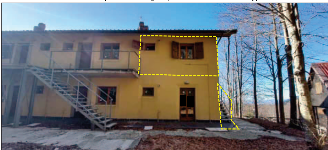
FOTO 8 – Prospetto Nord-Est del fabbricato censito al mapp. 81 con individuazione dell'appartamento della corte di pertinenza e della scala di accesso censiti al Sub 5
