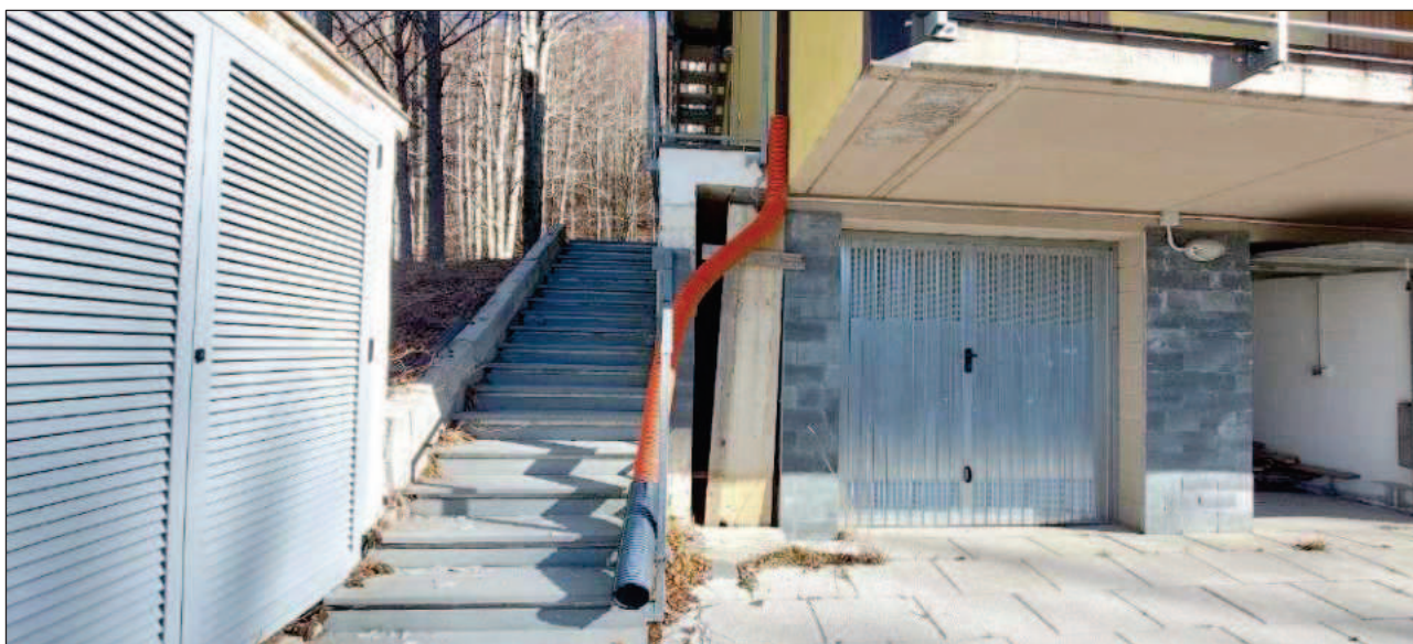
FOTO 2 – scala comune di collegamento tra piano seminterrato e piano terra
