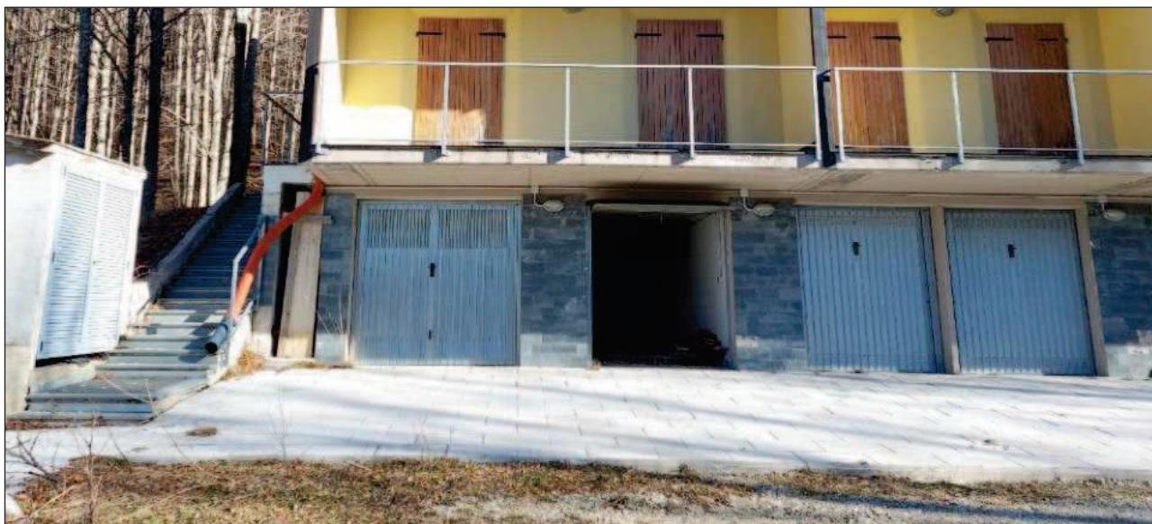
FOTO 1 – ingresso box e corte di pertinenza
