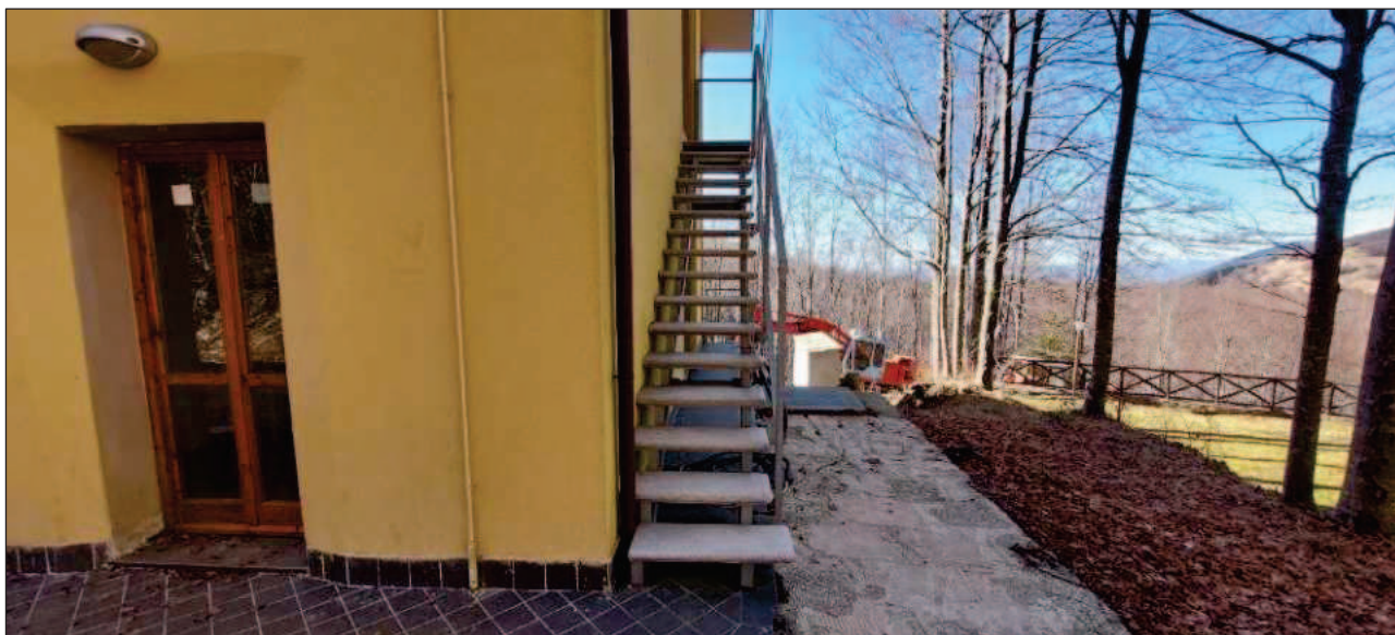
FOTO 1 – Corte a piano terra e scale di accesso di pertinenza al Sub. 5
