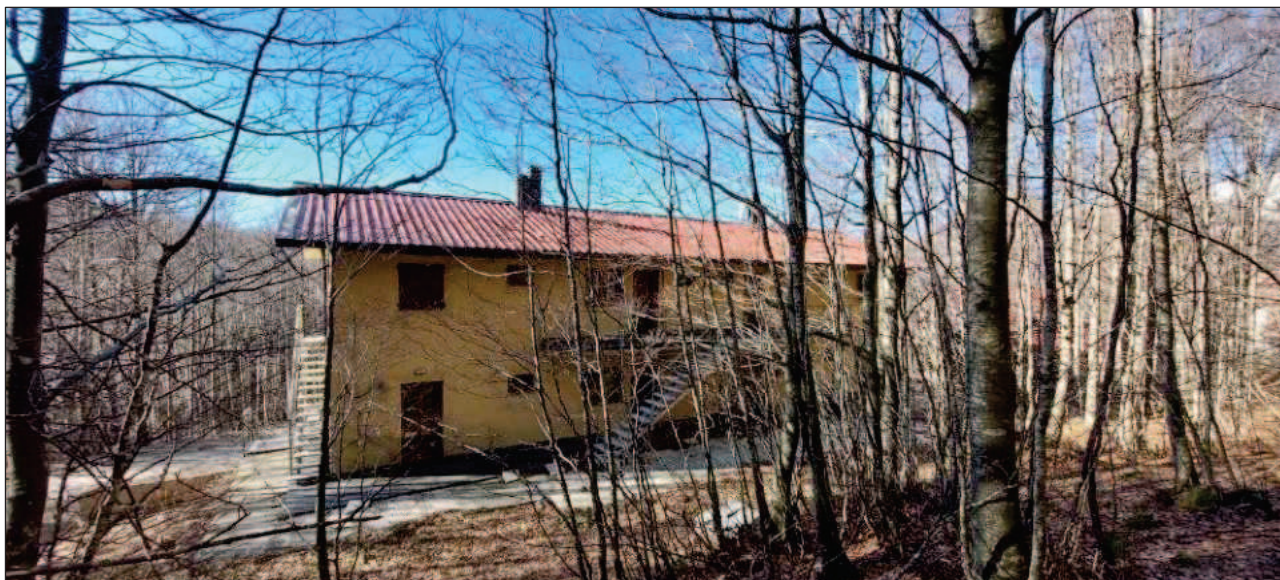
FOTO 10 - Prospetto Nord-Est del fabbricato censito al mapp. 81
