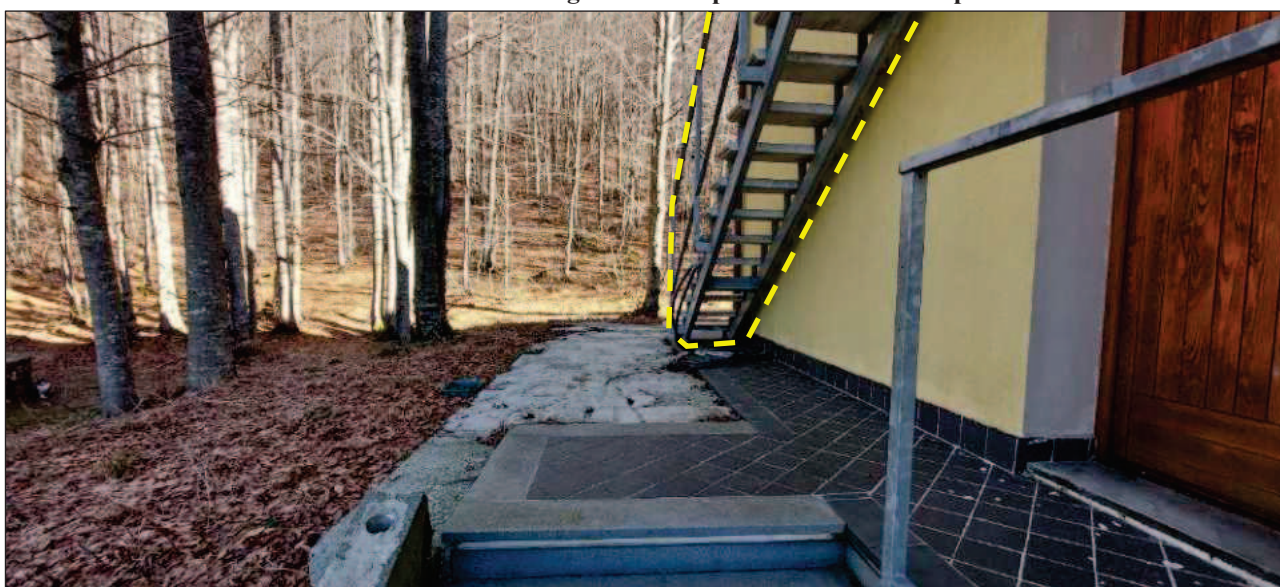
FOTO 3 – marciapiede esterno e scala di accesso all’appartamento staggito (sub. 5)
