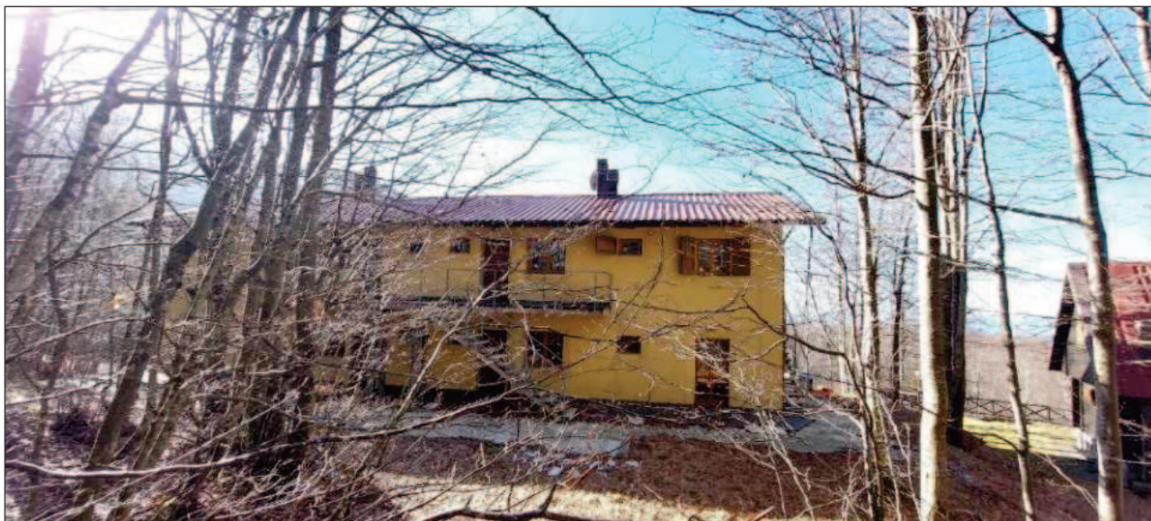
FOTO 8 – Prospetto Nord-Est (parte) del fabbricato censito al mapp. 81
