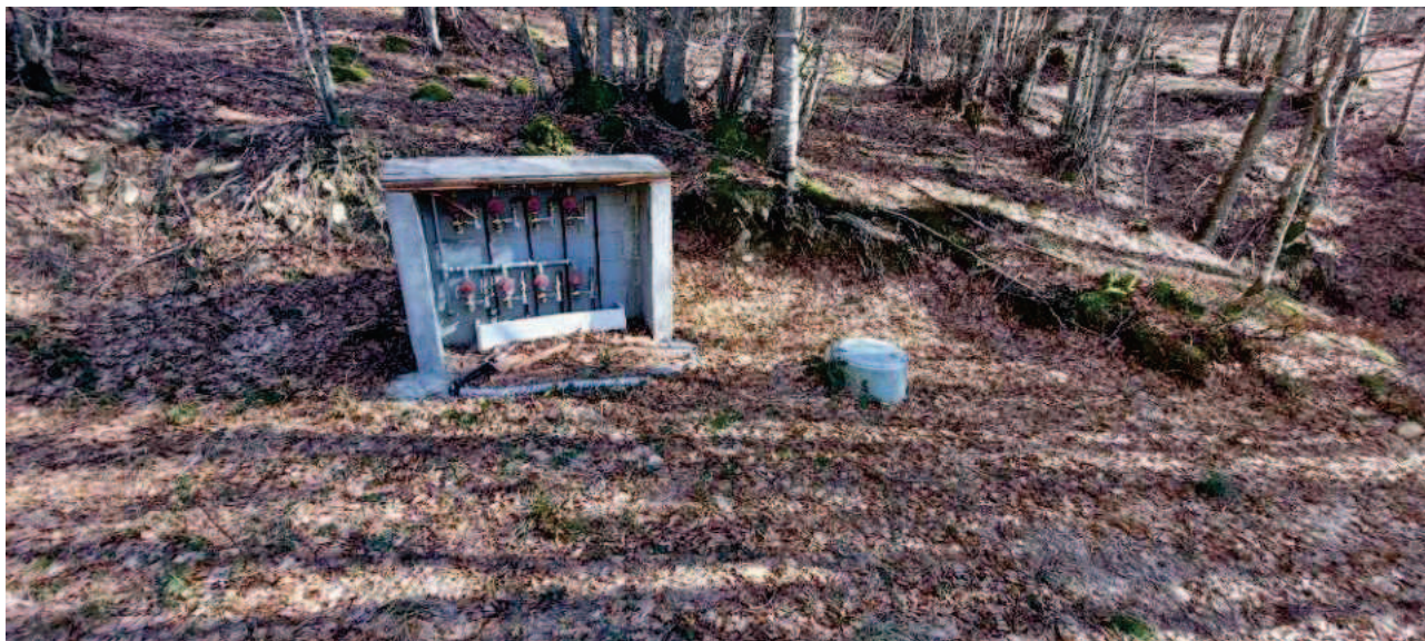
FOTO 15 – nicchia per la predisposizione dei contatori gas e bombolone GPL
