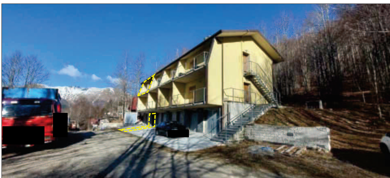
FOTO 12 - Prospetti Sud-Est e Sud-Ovest del fabbricato censito al mapp. 81
