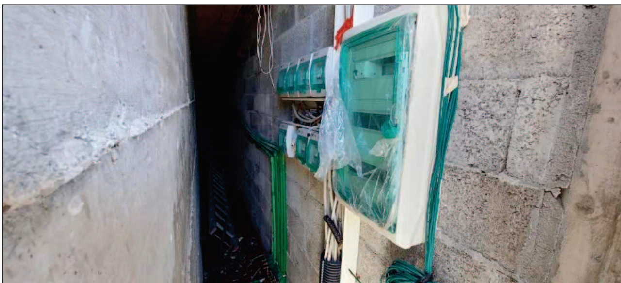
FOTO 5 – part. scannafosso ispezionabile che corre perimetralmente alla porzione controterra del piano seminterrato
