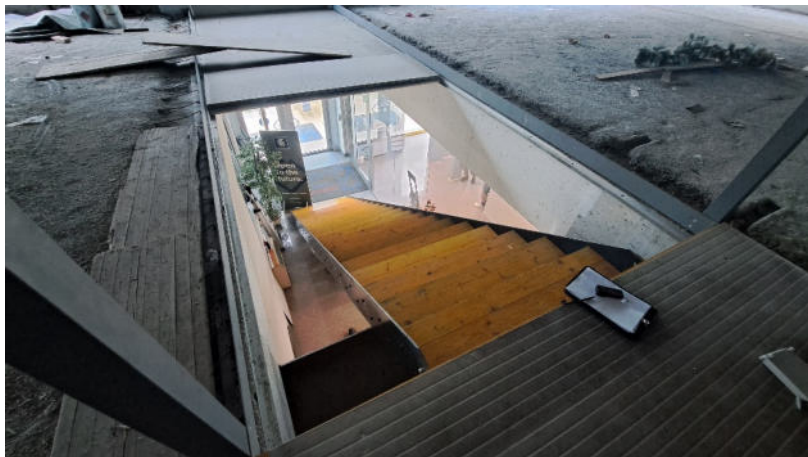
13 Interno - Collegamento piano primo
