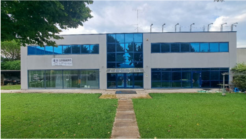
01 Vista esterno del fabbricato fronte nord
