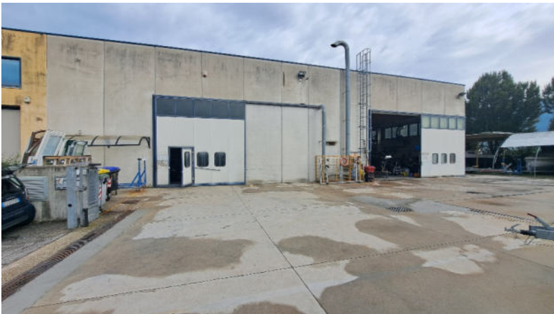
03 Vista esterno del fabbricato fronte sud
