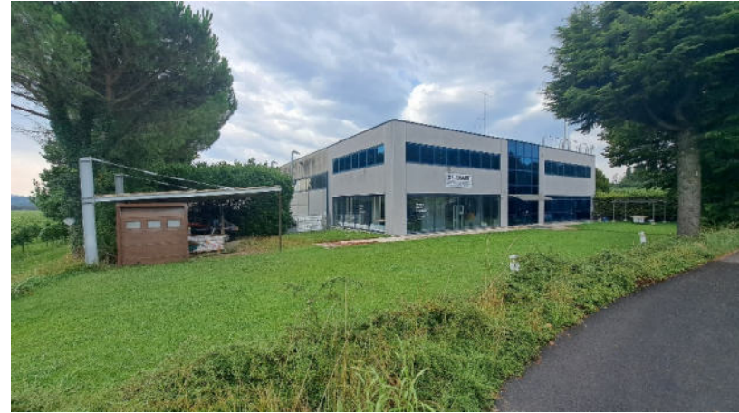
02 Vista esterno del fabbricato fronte nord-est
