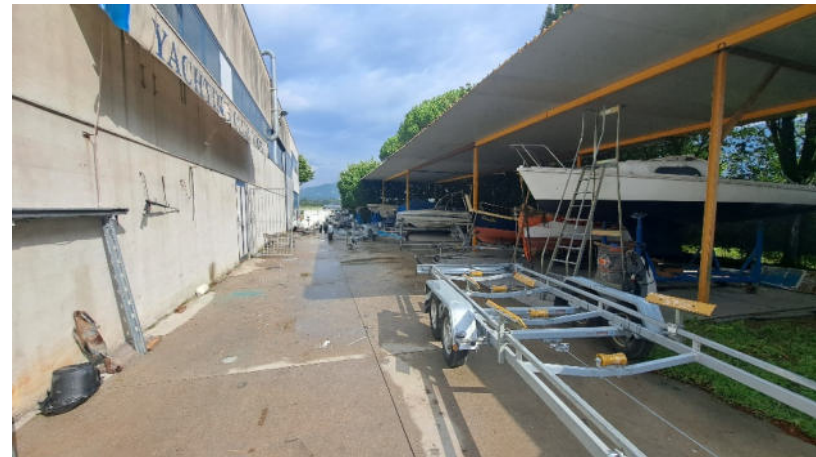
04 Vista esterno del fabbricato fronte est
