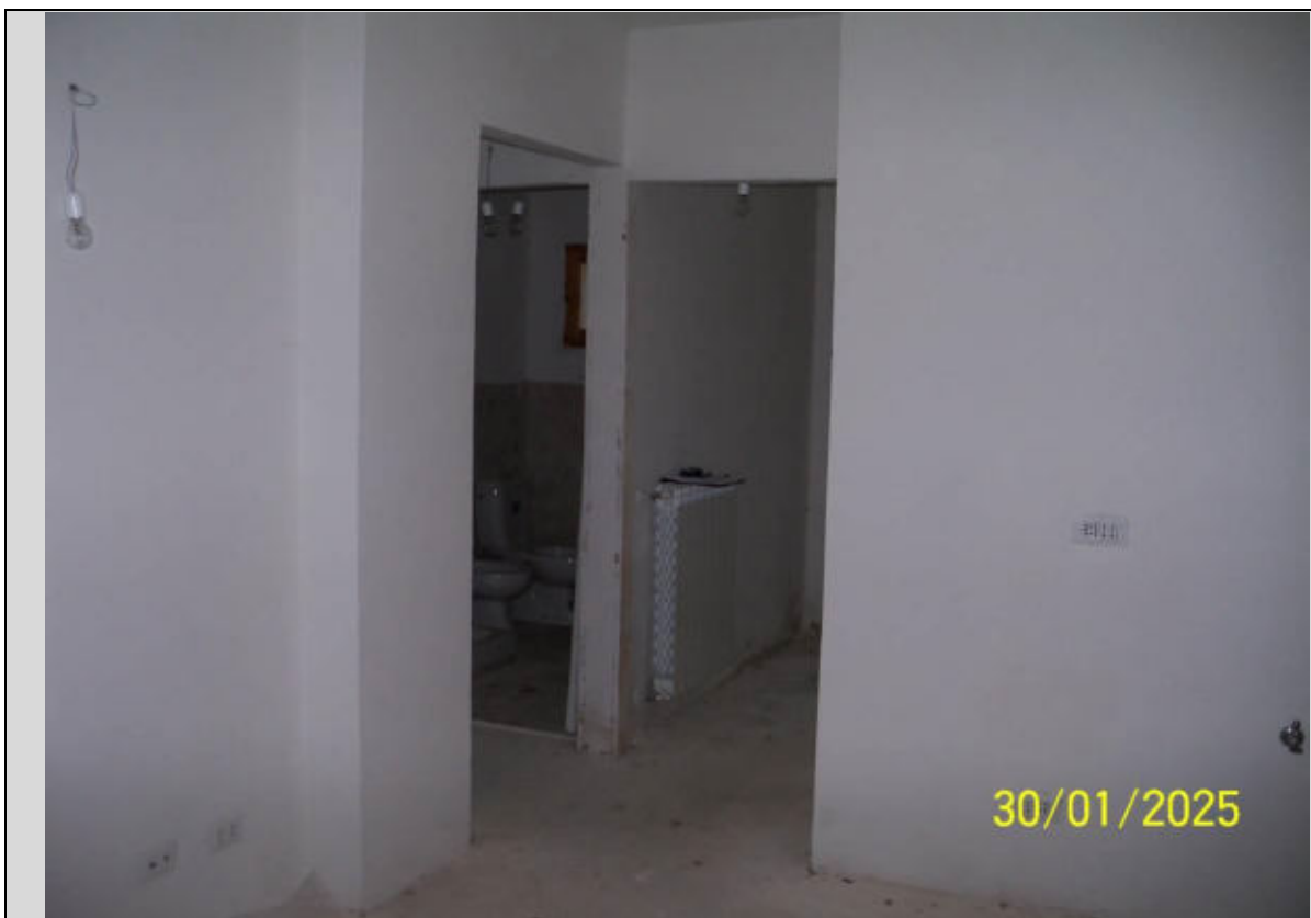
Vista Interna: Zona disimpegno vista dal locale ingresso-soggiorno Si nota l'assenza completa della pavimentazione, delle porte interne e finiture
