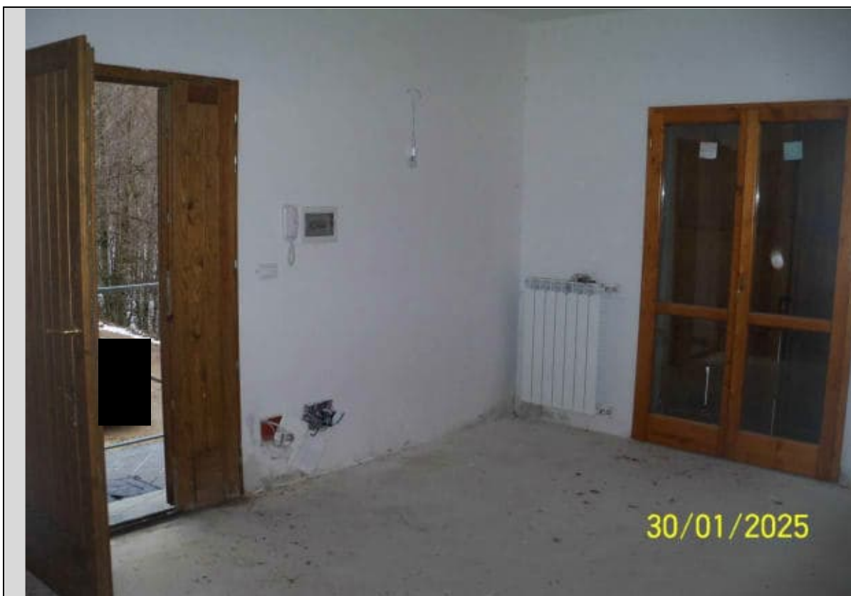
Vista Interna: Zona ingresso soggiorno dell'abitazione posta al piano terra di cui al sub.35 Si nota l'assenza completa della pavimentazione, delle porte interne e finiture
