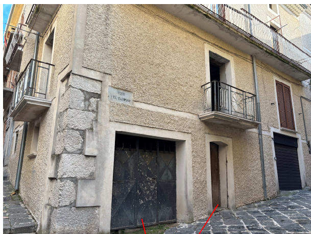
ingresso piano seminterrato
