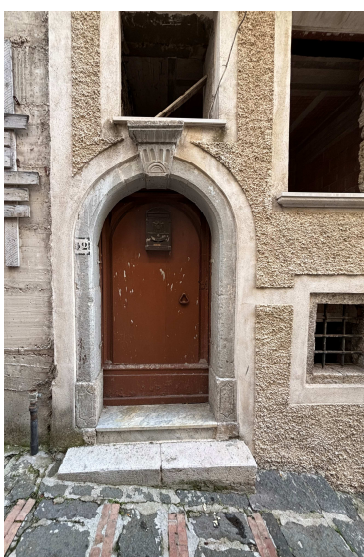
ingresso piano terra
