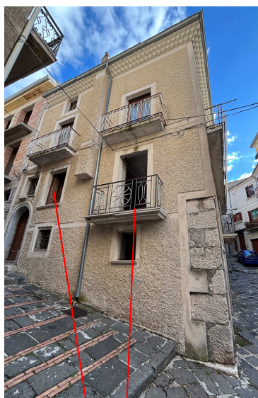
piano terra: lato Via Carpine
