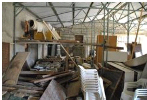
Part. 173: il vano unico interno
