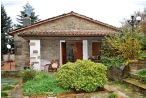
Part. 184, sub. 1: il portico sull'area della strada catastale ormai dismessa
