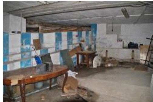
Part. 184, sub. 2: l'interno del magazzino, che da progetto (del 2010) doveva essere suddiviso in due vani
