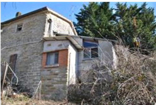
Part. 78, sub. 1: l'ampliamento dei locali cucina, con tecniche e materiali scadenti, in aderenza alla struttura originaria
