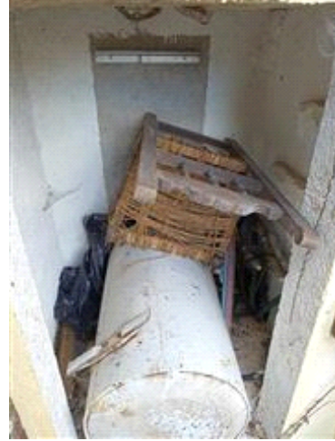
Part. 78, sub. 2: l'interno del piccolo vano tecnico a servizio del monolocale
