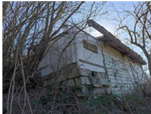
F. 61, Part. 95: il capanno non presente nelle planimetrie catastali, in stato di degrado
