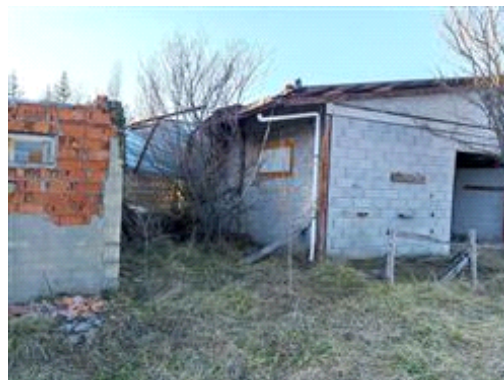
Part. 174: a sinistra, il blocco dei servizi e del fienile senza copertura; a destra, il blocco per il ricovero dei cavalli con copertura integra ma difforme
