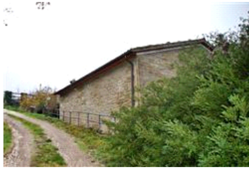
Part. 95: terreno ad uso strada di accesso
