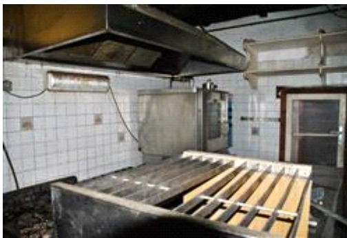
Part. 78, sub. 1: la parte della cucina nella struttura originaria
