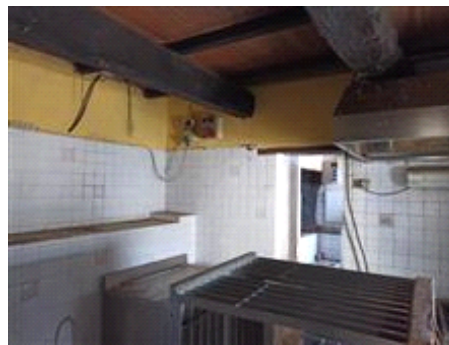
Part. 78, sub. 1: la parte della cucina nella struttura originaria
