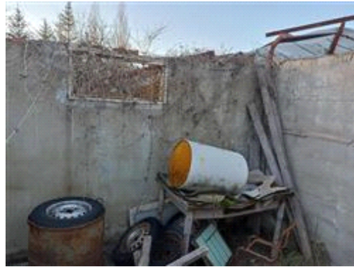
Part. 174: il blocco dei servizi (tetto divolto)
