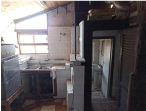
Part. 78, sub. 1: l'ampliamento dei locali cucina, dall'interno
