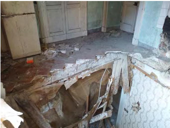
F12, 13 e 14- Bene n.4 (Vano 4, particolari su solaio sfondato)
