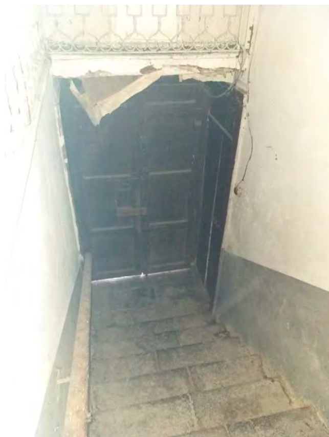
F15 e 16- Bene n.4 (Vano scala comune, ingresso da via Roma)
