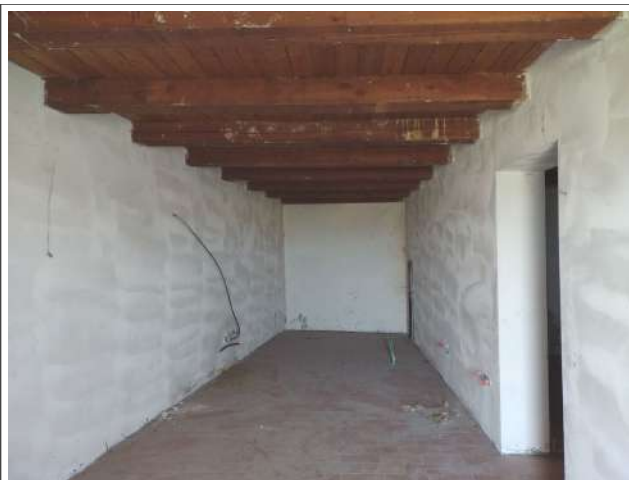
Zona p.lla 10 sub 15
