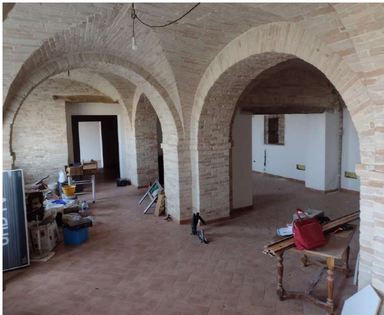
Interno locale commerciale seminterrato p.lla 9-10
