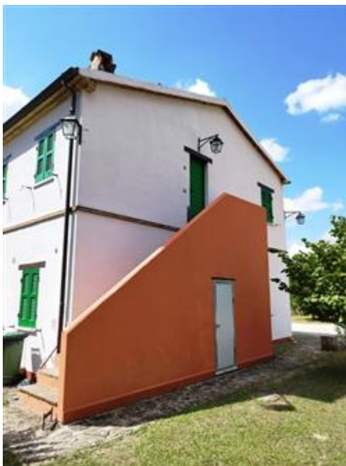
Foto esterno sub 5
