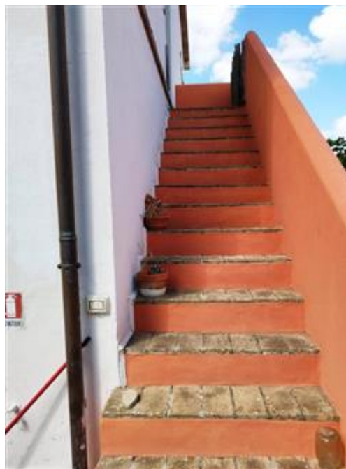
Foto esterno sub 5
