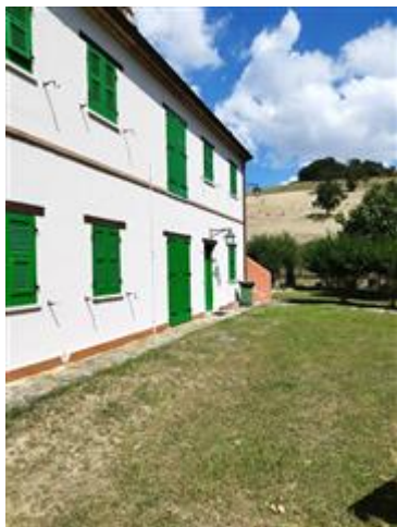
Foto esterno sub 3
